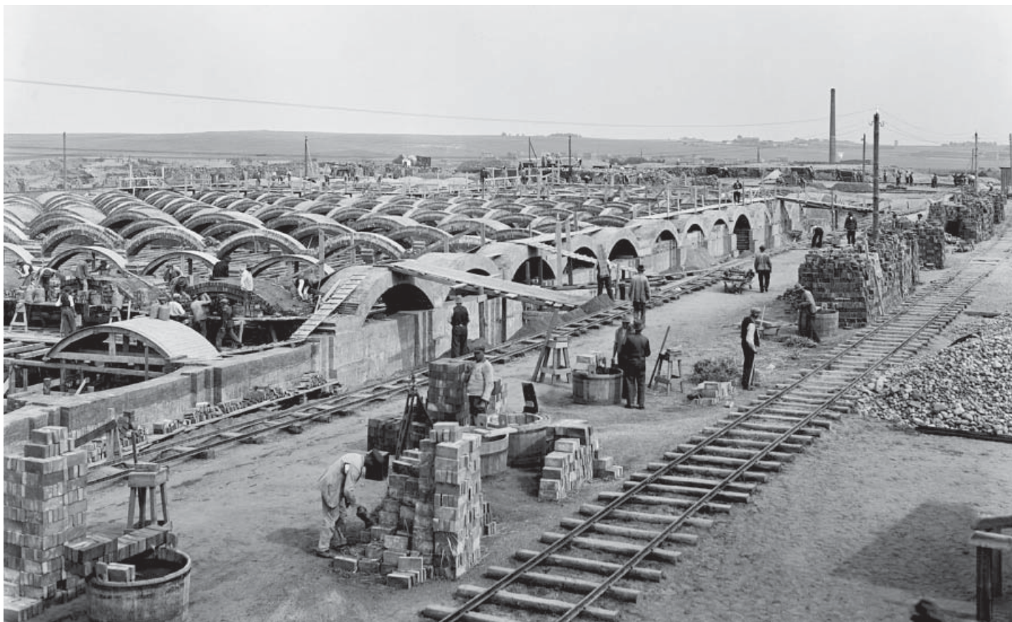
Budowa zbiorników wody w Łodzi. 1935–1937 r. Zaprojektował je na początku XX wieku William Heerlein Lindley. W jednym z wyższych miejsc miasta – 260 m n.p.m. – powstały rezerwuary wody pełniące rolę gigantycznej wieży ciśnień. Zostały zbudowane na planie czterech kwadratów o boku 60 m każdy, ze specjalnie wypalanej cegły, ze ścianami w kształcie łuków, by zmniejszyć ciśnienie zgromadzonej w nich wody. Rozbudowane po drugiej wojnie światowej łódzkie zbiorniki mieszczą 100 tys. m 3 wody (arch. ZWiK Łódź)
