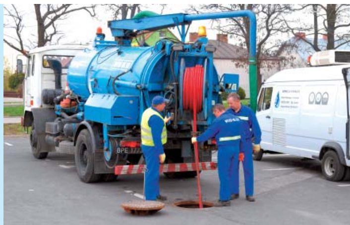
Czyszczenie kolektorów ściekowych zapewnia utrzymanie drożności systemu – Białskie Wodociągi (fot. M. Kucharczyk)
