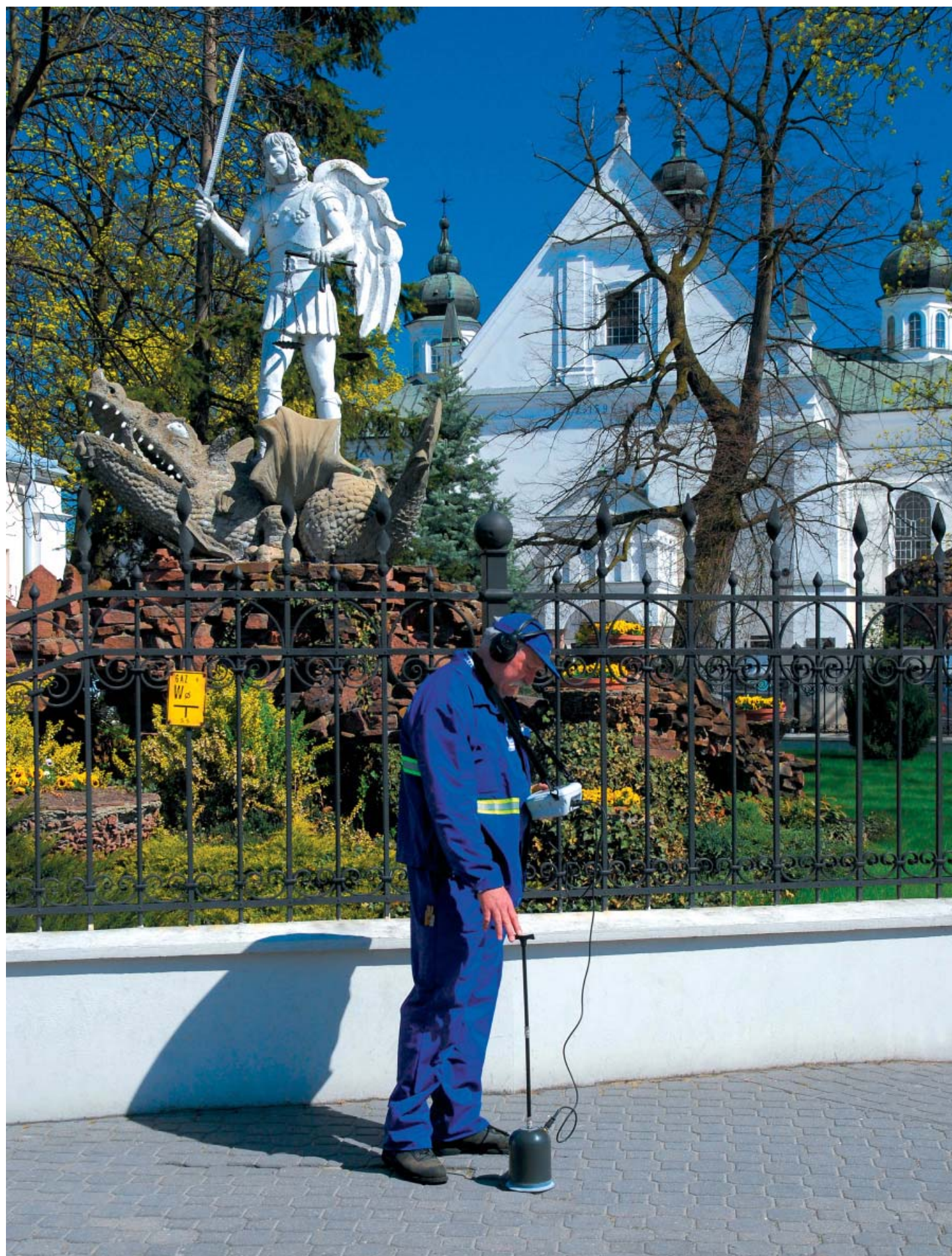
Monitorowanie sieci wodociągowej – Białskie Wodociągi (fot. M. Kucharczyk)
