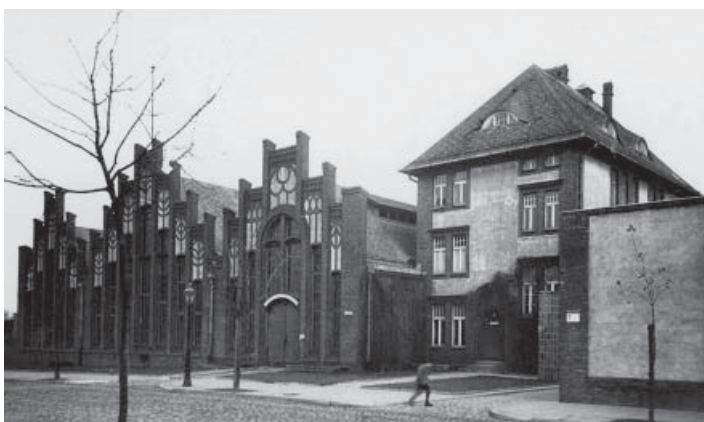
Poznań. Przepompownia ścieków (foto Aquanet SA)
