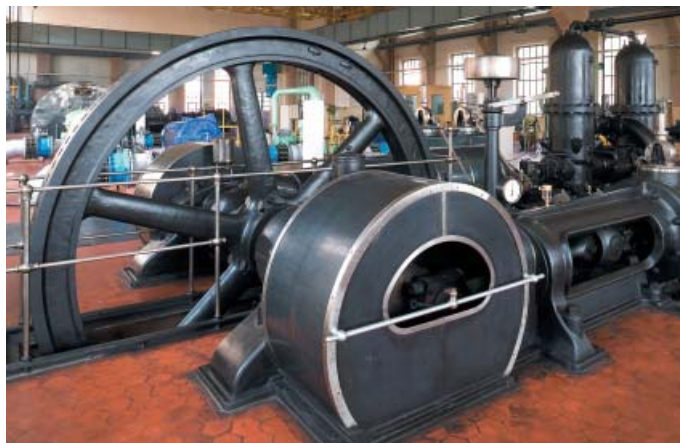
Karchowice, woj. śląskie – sprężarka parowa (foto Urząd Marszałkowski w Katowicach)
