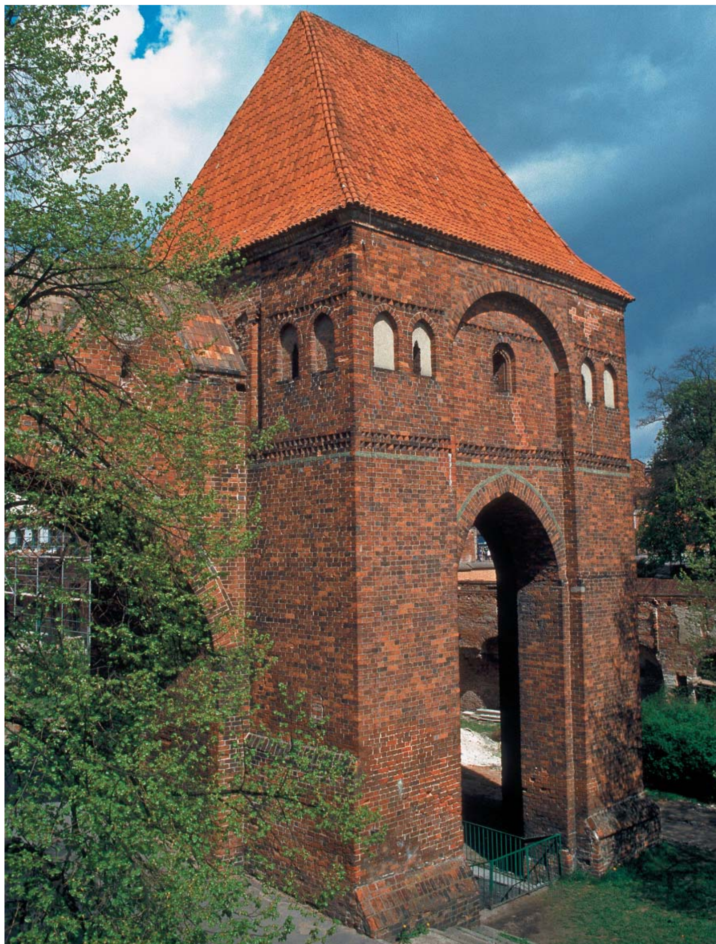
Charakterystycznym elementem zamku był wyprowadzony z naroża skrzydła wschodniego dansker (wieża kloaczna). Sięgał on około 32 metry poza obwód murów, prowadził do niego podparty na arkadach ganek z oryginalnym, ceglany zadaszeniem (foto Dariusz Zaród Photoagecy.com.pl)
