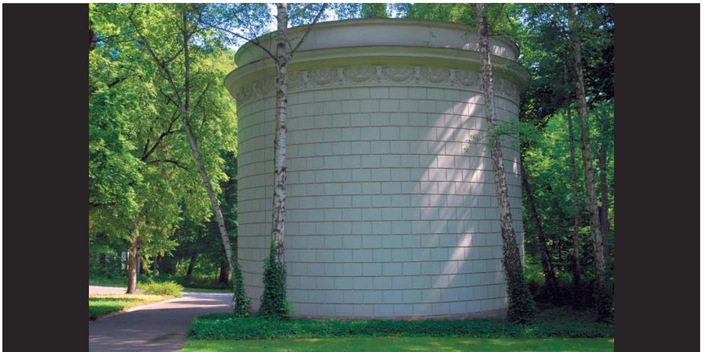
Warszawa, Łazienki Królewskie – okrągły wodozbiór wzniosł w latach 1777–1778 Dominik Merlini dla dostarczania wody do fontann ogrodowych. Przebudował go w latach 1823–1827 Ch.P. Aigner, na wzór starożytnego grobowca Cecylii Metelli w Rzymie. Obecnie mieści się w nim galeria sztuki (foto M. Kucharczyk)
