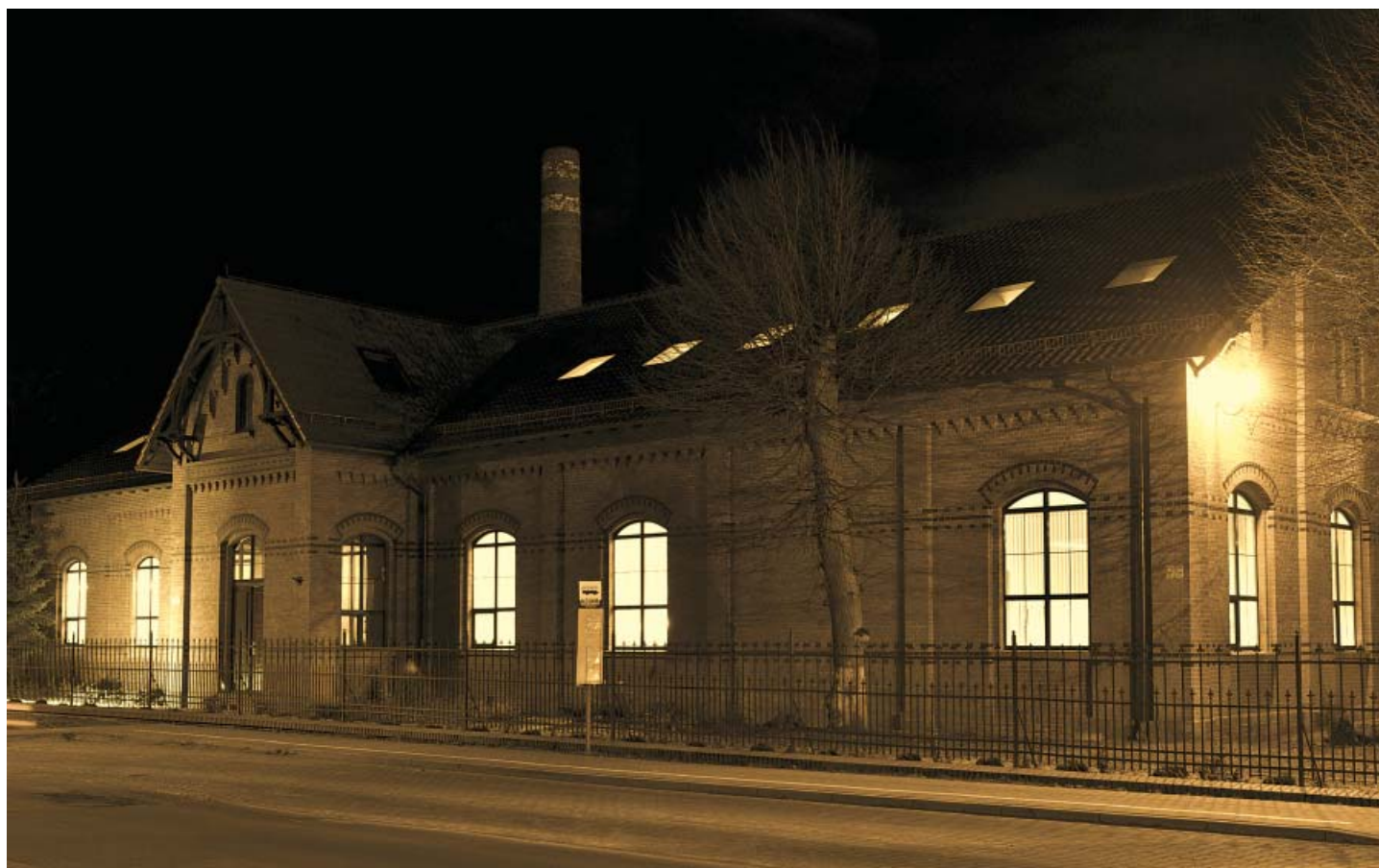
Grudziądz, woj. kujawsko-pomorskie. Stacja pomp parowych (foto L. Domowicz)
