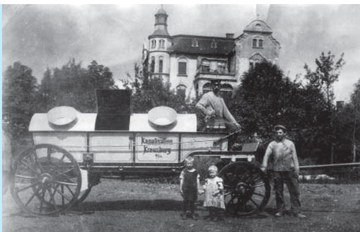
Kluczbork. Ekipa do konserwacji kanalizacji (arch. Hydrokom Kluczbork)
