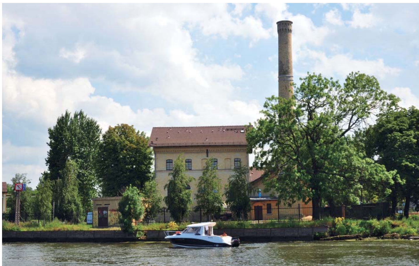
Zabytkowy budynek przepompowni ścieków Ołowianka, jeden z najstarszych obiektów gdańskiego systemu wod-kan, powstał w 1871 r. w unikatowym stylu neoromańskim. Gruntownie zmodernizowany w 2002 r., pompuje ok. 70% ścieków z obszaru Gdańska do Oczyszczalni Wschód
