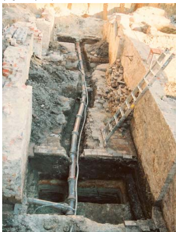
Bydgoszcz, ul. Mostowa 4. Kamionkowa kanalizacja i ołowiany wodociąg z pocz. XX w. (foto W. Siwiak)
