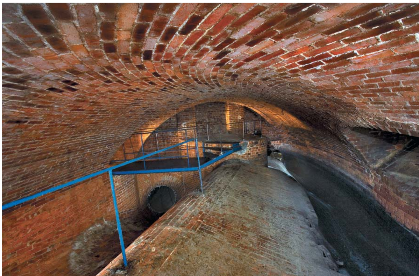
Warszawa. Połączenie kanałów pod ulicą Karową i Krakowskim Przedmieściem (foto K. Kobus/TravelPhoto)
