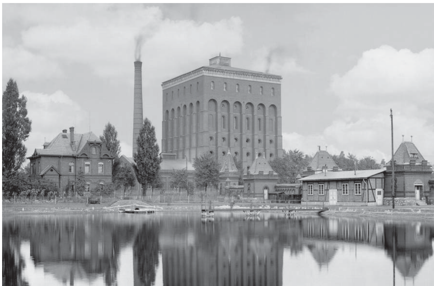
Wieża ciśnień Zakładu Uzdatniania Wody „Na Grobli” we Wrocławiu, początek XX w. (arch. MPWiK Wrocław)
