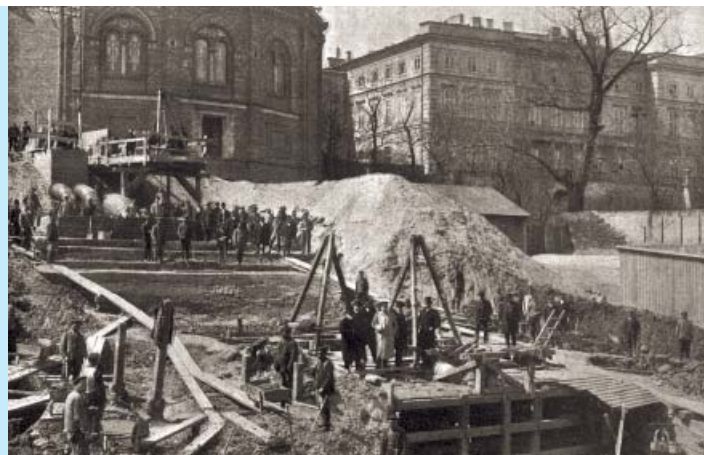
Budowa kanału burzowego w Warszawie (arch. MPWiK Warszawa)
