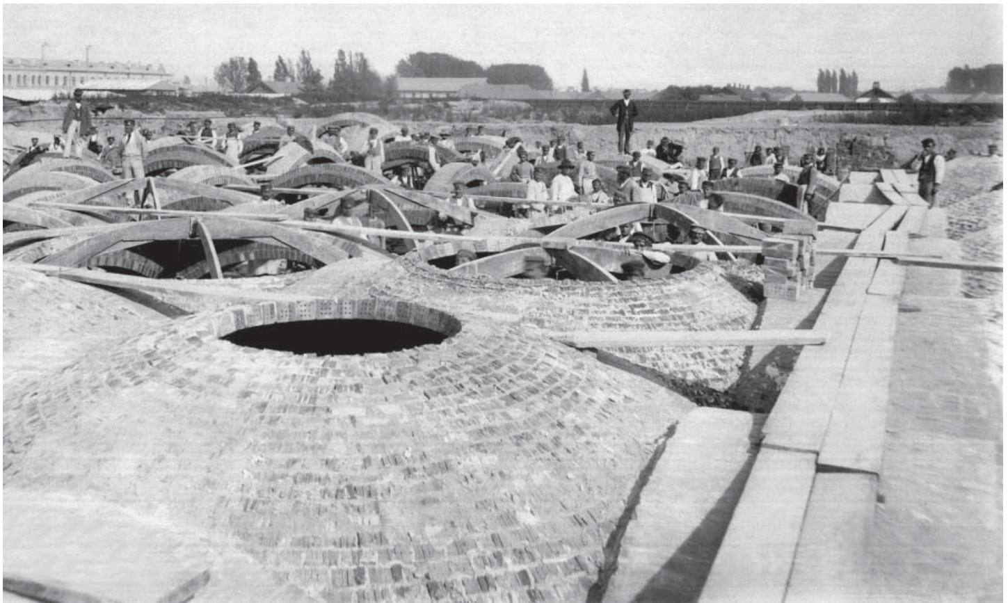
Warszawa. Budowa filtrów powolnych (arch. MPWiK Warszawa)
