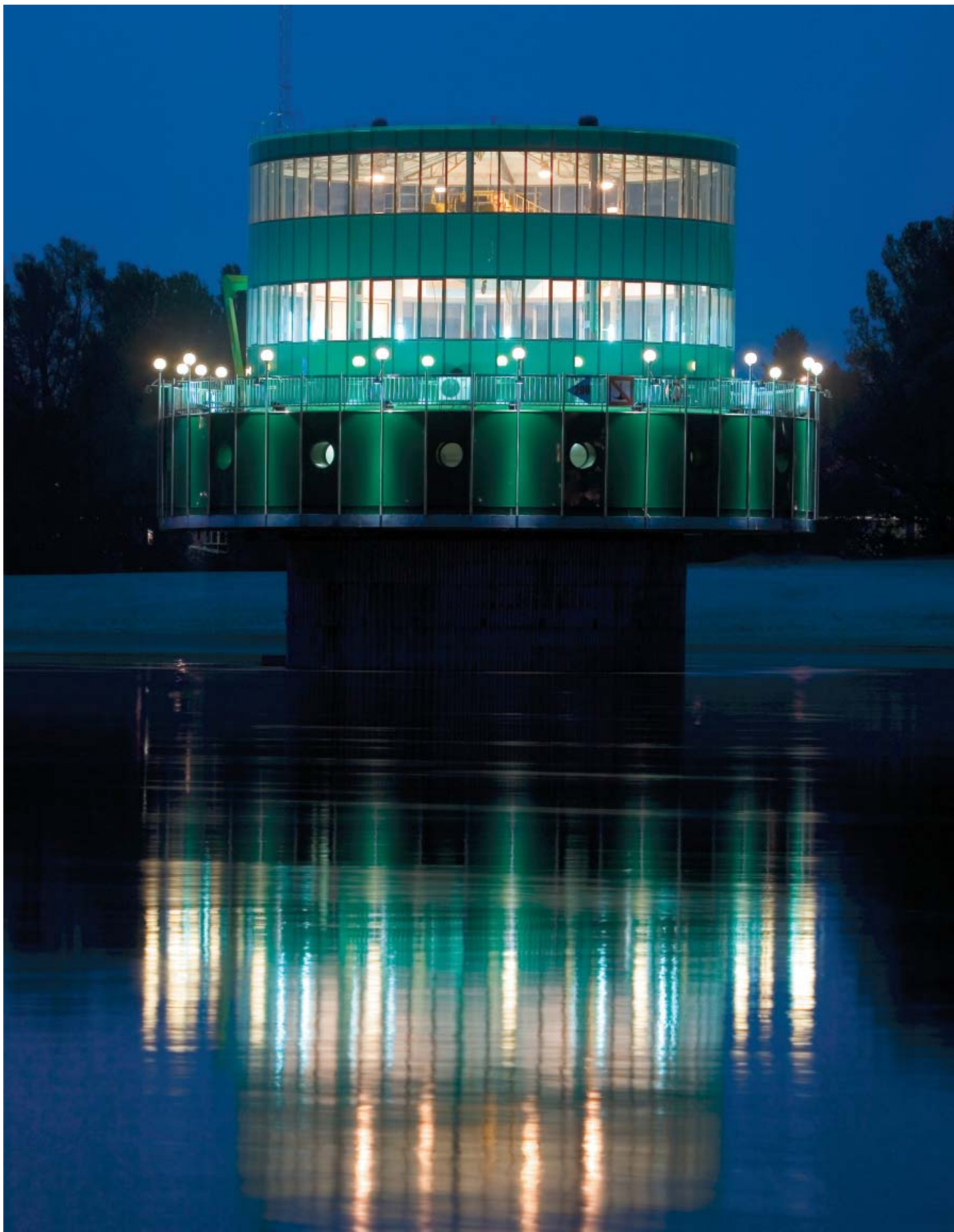
Warszawa, „Gruba Kaśka” (1964 r.) – największa w Europie studnia infiltracyjna, która pobiera wodę z promieniście ułożonych drenów znajdujących się 6 m pod dnem i 300-metrowym rurociągiem umieszczonym w podwodnym tunelu (którym obsługa może dostać się do wnętrza budowli) pompuje ją na brzeg. Metodę pobierania wody spod dna rzeki opracował Polak – inż. W. Skoraczewski, dlatego nazywana jest ona na świecie tzw. ujęciem warszawskim (fot. K. Kobus TravelPhoto)
