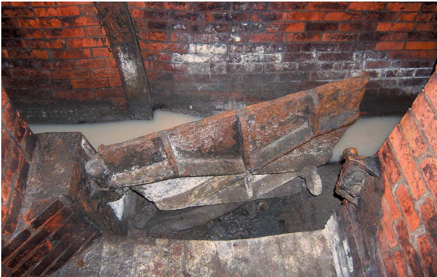
Łódź. Drzwi kanałowe w kolektorze ogólnospławnym (foto ZWiK Łódź)
