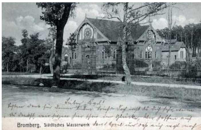
Bydgoszcz. Stacja wodociągowa Las Gdański 1900 r. (arch. W. Banach)
