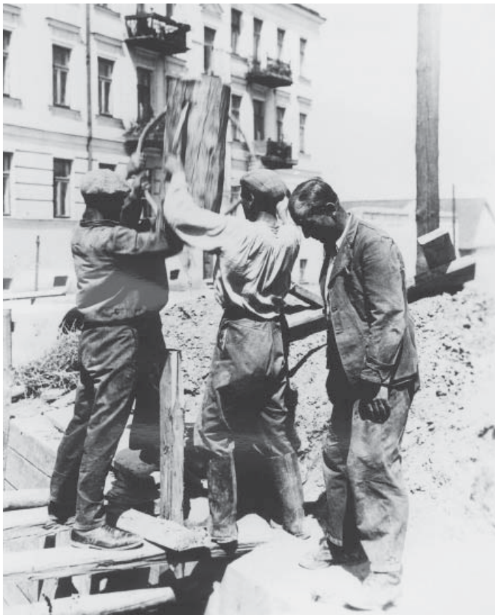
Budowa kanalizacji w Łomży, skrzyżowanie ulic: Pięknej i Stacha Konwy, okres międzywojenny (arch. MPWiK Łomża)
