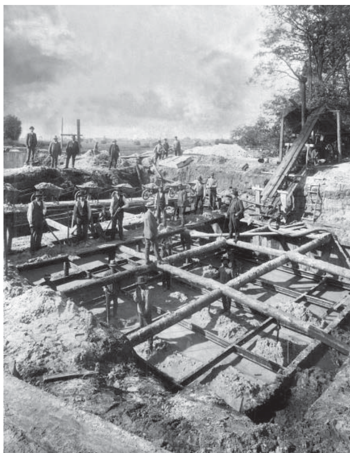
Kluczbork. Budowa przepompowni ścieków, 1905 r. (arch. Hydrokom Kluczbork)
