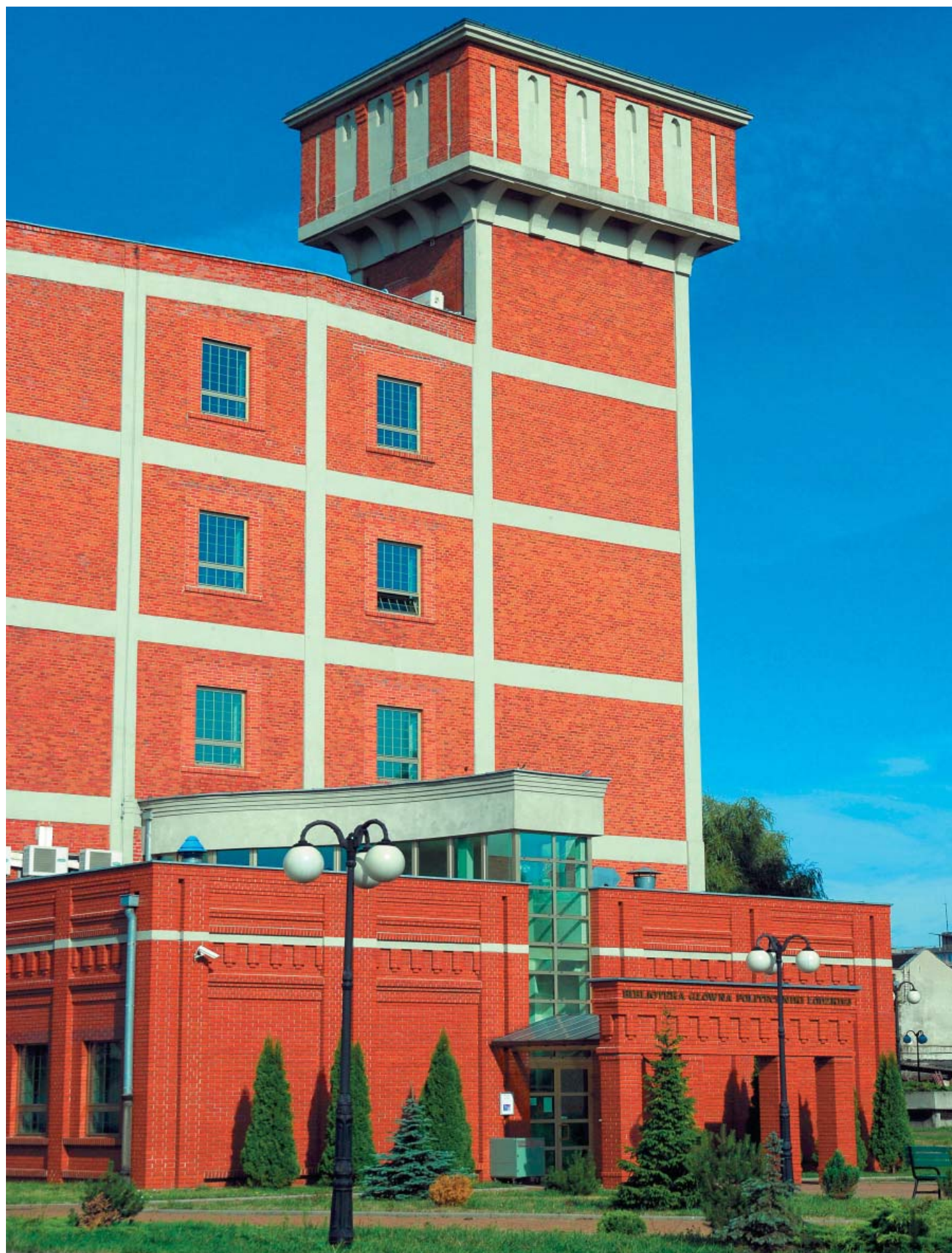
Łódź – narożna wieża wodna z 1913 r. stanowiąca część budynku składu w fabryce Schweikerta. Obecnie – Biblioteka Główna Politechniki Łódzkiej (foto M. Kucharczyk)
