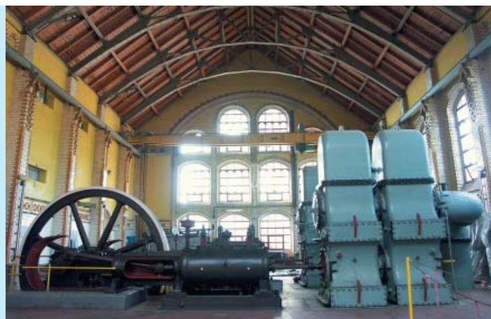
Przepompownia ścieków „Port” we Wrocławiu – 1881 r. (foto M. Madejowski)
