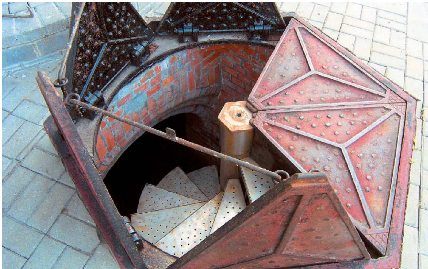
Łódź. „Gwiazda” (poniżej) – nietypowy wjazd do zejścia bocznego, prowadzącego do komory łączącej dwa najstarsze łódzkie kolektory i przelew burzowy. Budowę łódzkiej kanalizacji zaczęto właśnie od tych kanałów w 1925 r., należą one do największych podziemnych budowli. Wrażenie robi burzowiec (powyżej) o przekroju dzwonu – bez trudu mógłby przejechać nim autobus komunikacji miejskiej (foto MPWiK Łódź)
