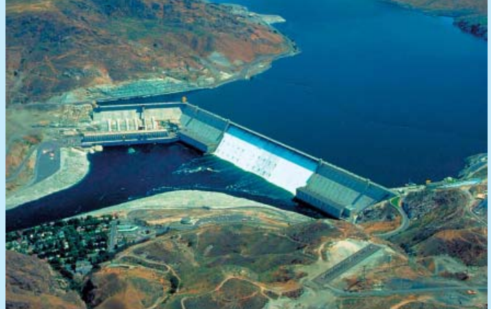
Grand Coulee – zapora w USA na rzece Kolumbii, wysokość 167 m, długość 1300 m, pojemność jeziora zaporowego 11,6 km 3
