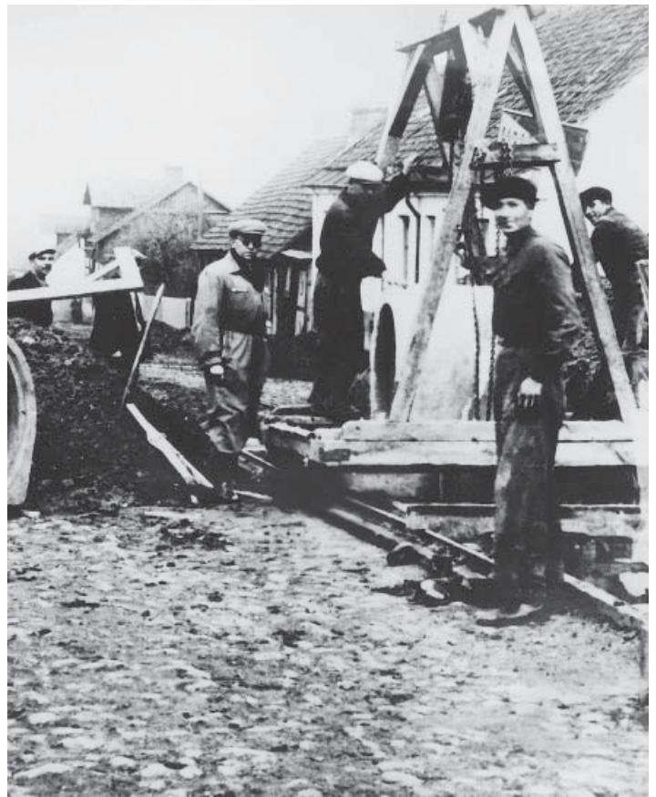
Budowa kanalizacji w Łomży na ul. Nadwiślańskiej, 1938 r. (arch. MPWiK Łomża)
