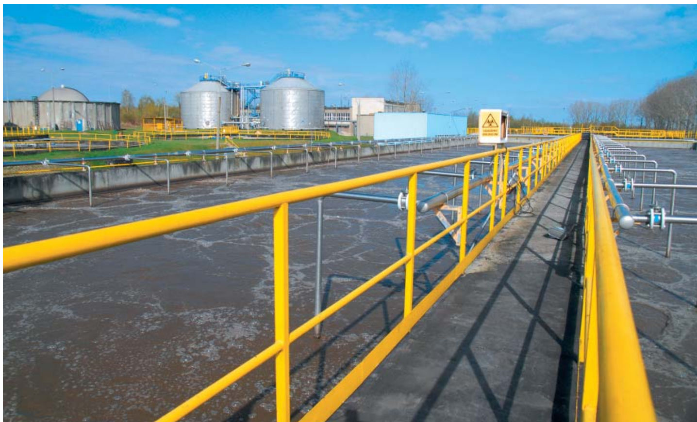
Oczyszczalnia ścieków – Białskie Wodociągi (fot. M. Kucharczyk)
