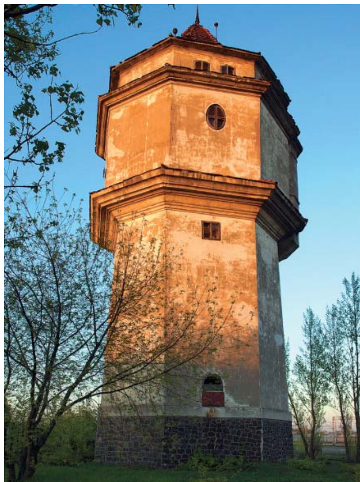
Sochaczew, woj. mazowieckie – wieża ciśnień z 1921 r. (arch. ZWiK Sochaczew)
