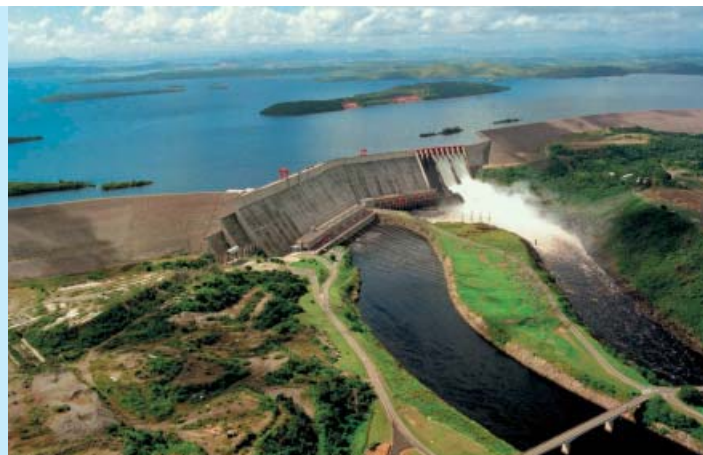
Guri – hydroelektrownia we wschodniej Wenezueli na rzece Caroní: zaporę wys. 162 m, zbiornik retencyjny 4,2 tys. km 2 (@Photofactory®)
