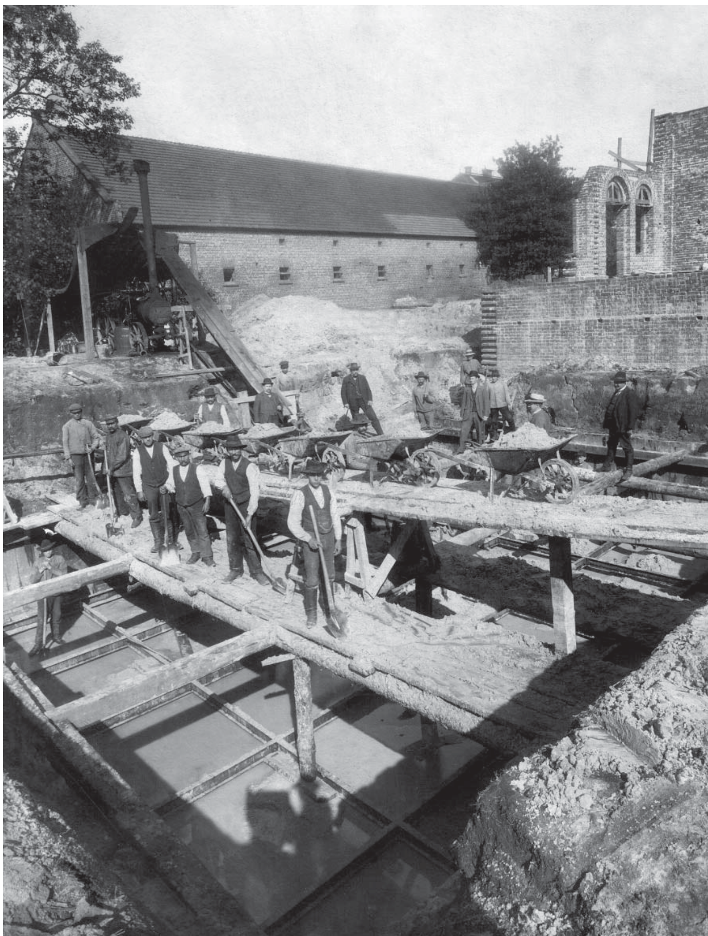
Kluczbork. Budowa przepompowni ścieków, 1906 r. (arch. Hydrokom Kluczbork)
