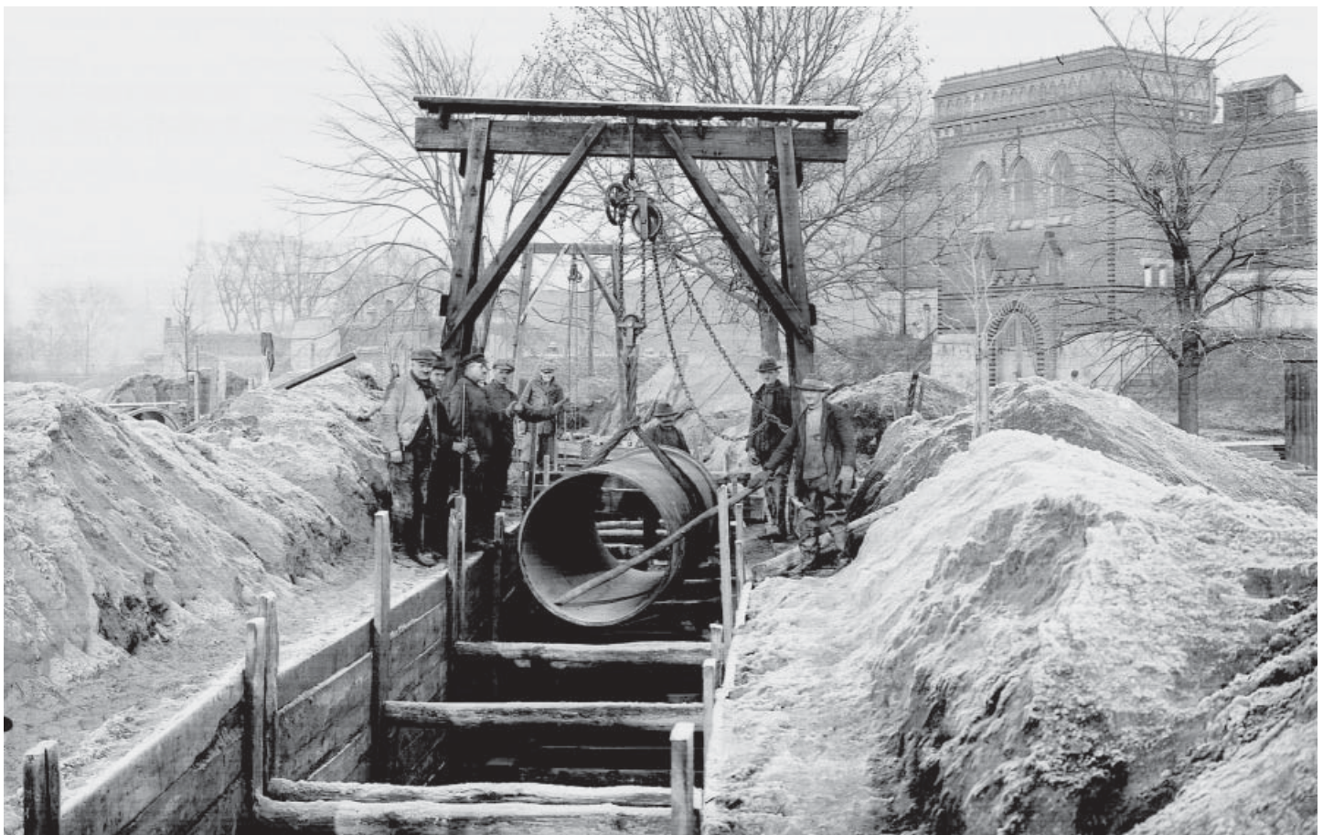
Renowacja rurociągu wody we Wrocławiu w pobliżu odzelaźniacza w zakładzie „Na Grobli” – 1936 r. (arch. MPWiK Wrocław)
