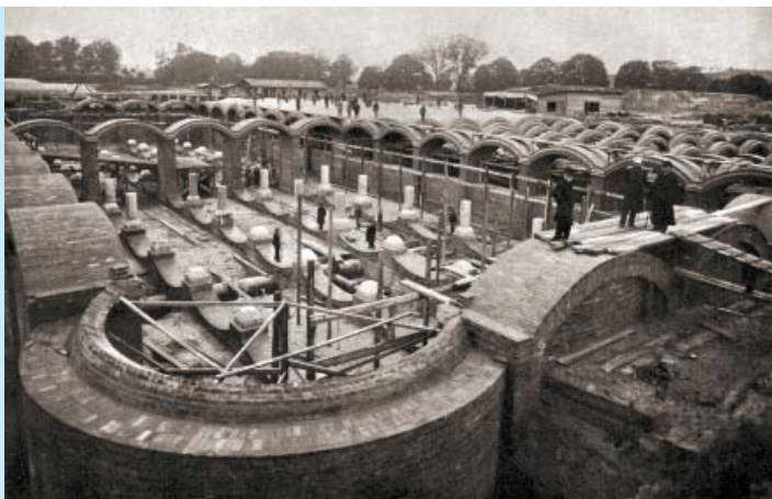
Budowa filtrów powolnych w Warszawie (arch. MPWiK Warszawa)
