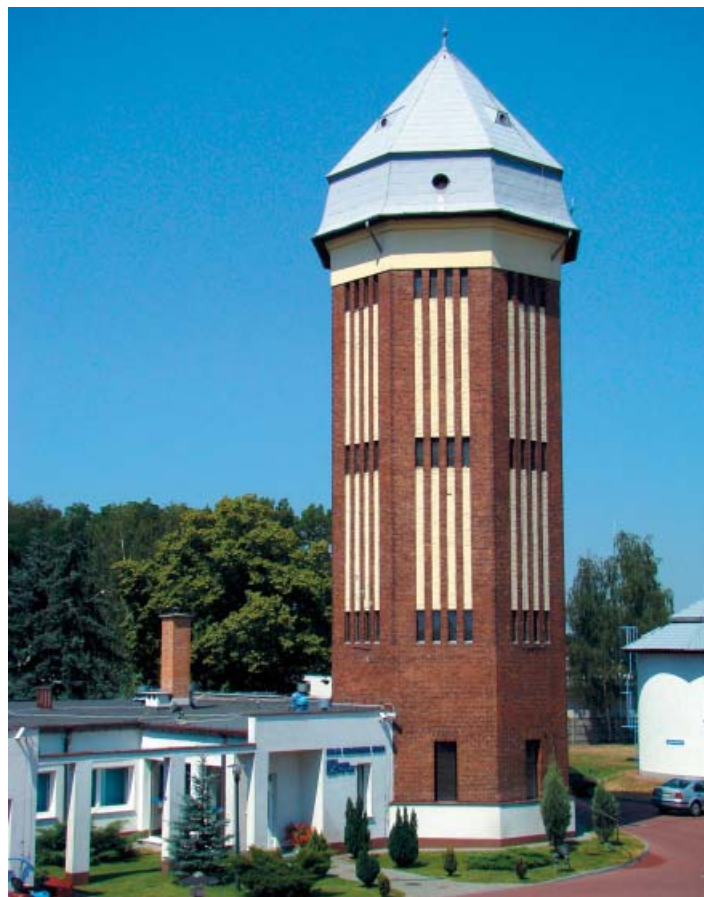
Nowy Tomyśl, woj. wielkopolskie – wieża ciśnień z 1906 r., wysokość 32 m, zbiornik 100 m 3 , stacja pomp tłokowych napędzanych silnikami na gaz miejski (foto P. Janik)
