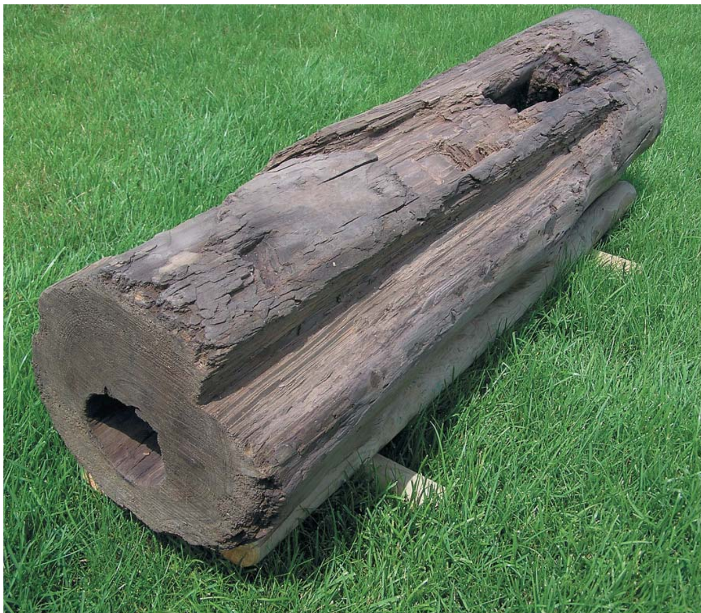
Lublin. Drewniana XVI-wieczna rura wodociągowa (foto MPWiK Lublin)
