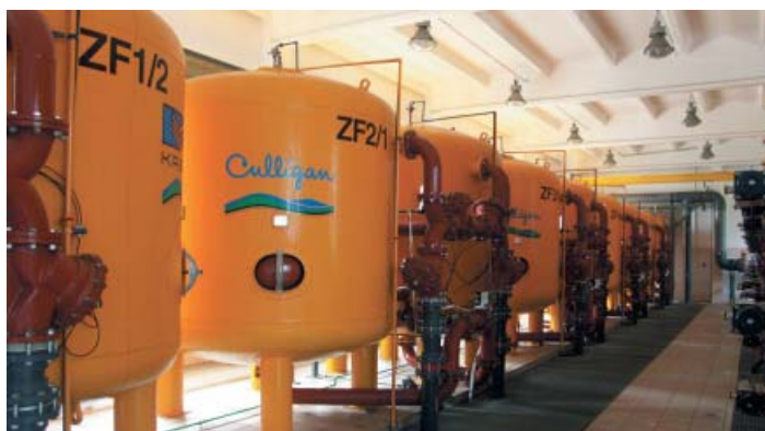
Zespół filtrów ciśnieniowych pospiesznych KREVOX - Culligan (typ HF 9) w stacji uzdatniania wody
