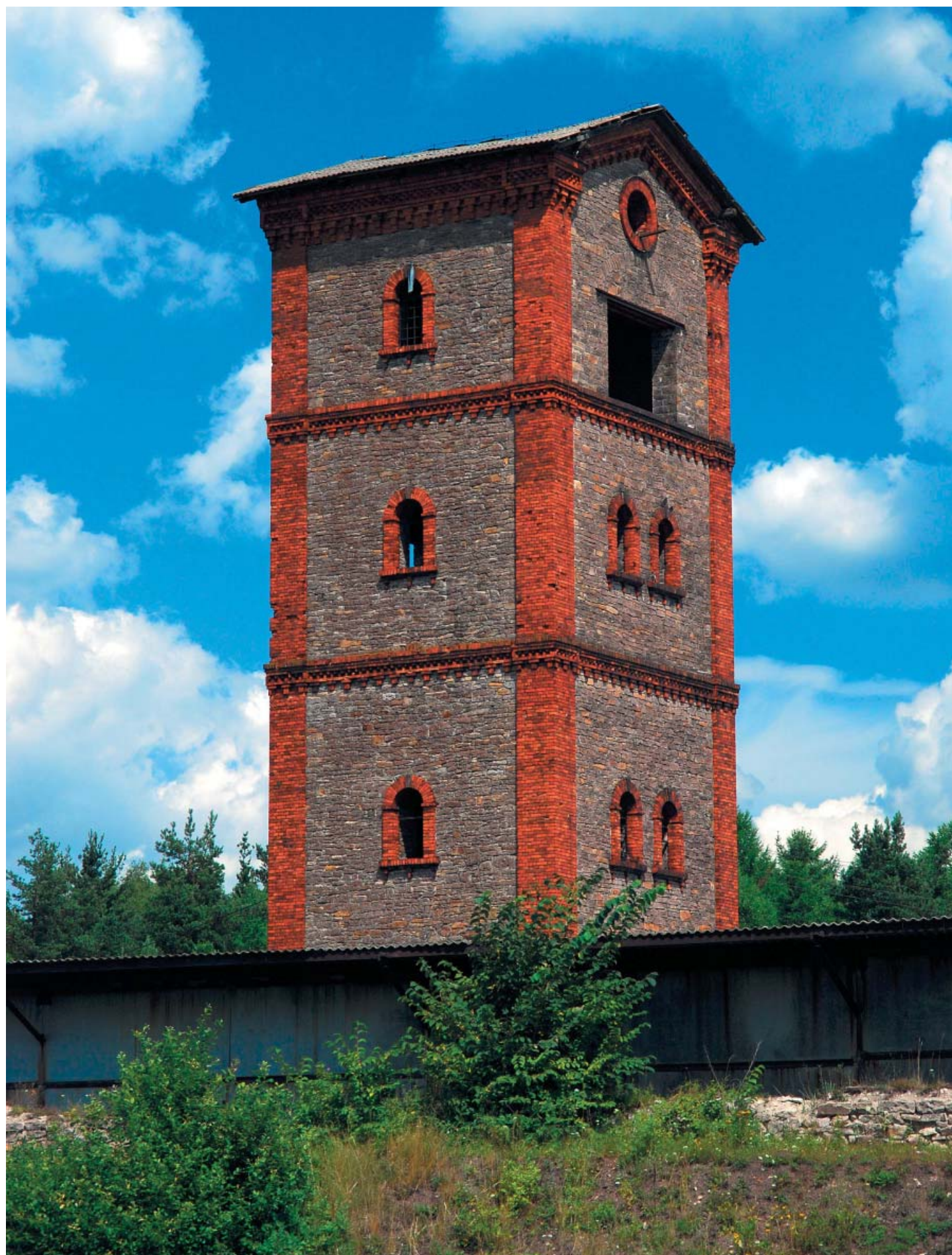
Furmanów, woj. świętokrzyskie – gichtociąg (1877) czyli... winda wodna (wieża wyciągowa) – wykorzystywana w dawnych hutach jako urządzenie do transportowania wsadu do pieca hutniczego – działała dzięki przepompowywaniu wody pomiędzy zbiornikami na różnych poziomach i wykorzystaniu zasady naczyń połączonych (foto M. Kucharczyk)
