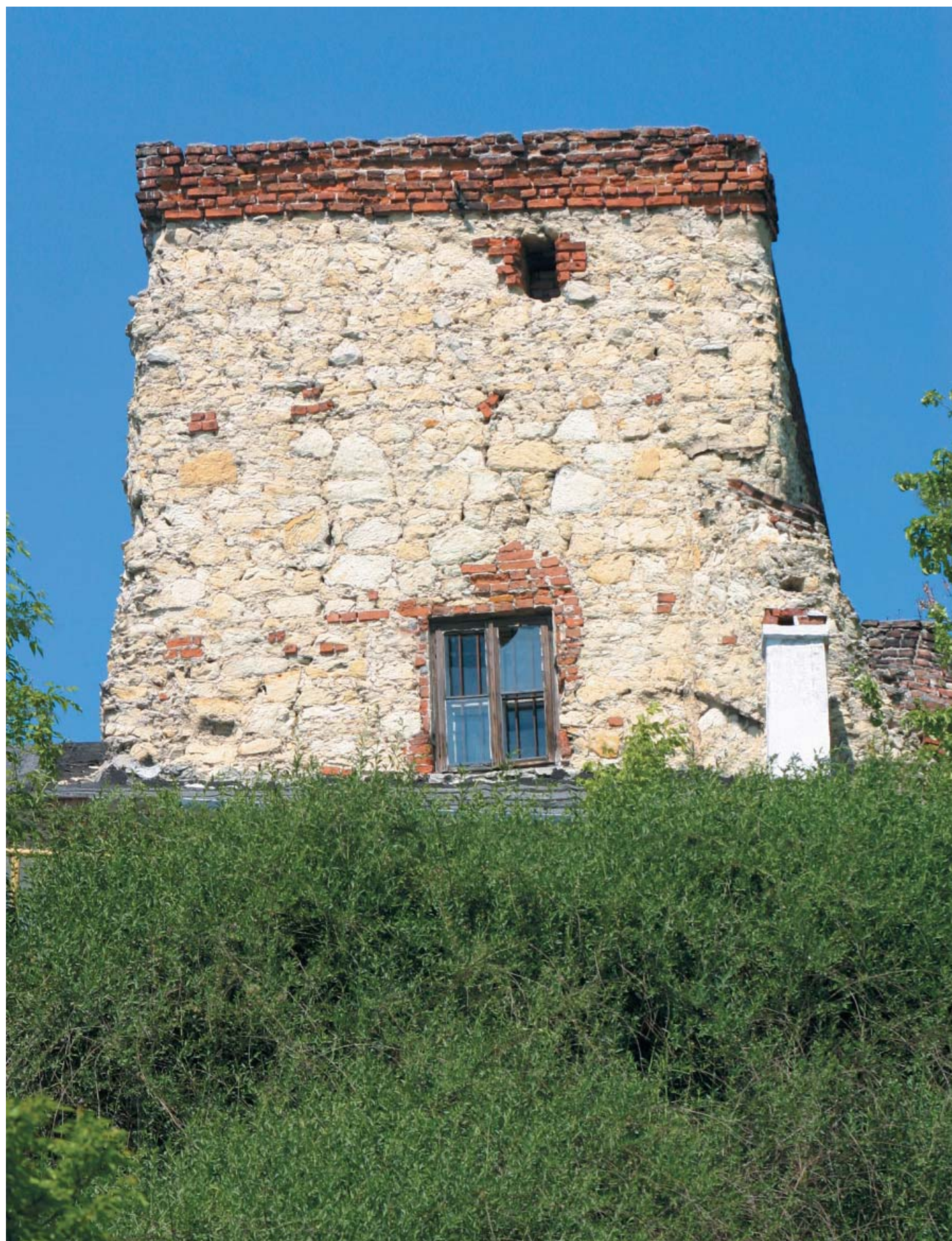
Lublin. Wieża wodna z 1564 r. zbudowana z łupanego kamienia wapiennego oraz z cegły z czterospadowym dachem. Ze zbiornika z wieży woda spływała grawitacyjnie drewnianymi rurami do browarów, kamienic bogatych mieszczan, klasztorów, szpitala przy kościele św. Ducha, łaźni i publicznych studzienek miejskich (foto MPWiK w Lublinie / arch. MPWiK Lublin)
