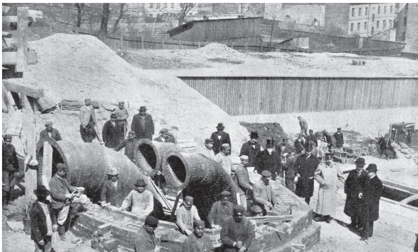
Warszawa. Budowa kanału burzowego (arch. MPWiK Warszawa)
