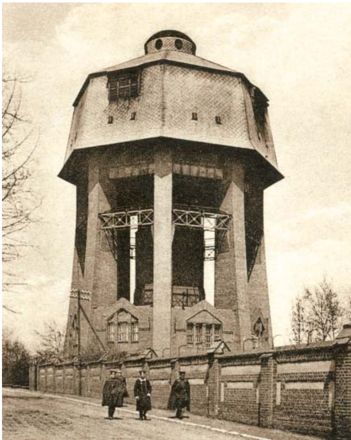
Zabrze, woj. śląskie – wieża ciśnień przy ul. Zamoyskiego (wysokość 46 m, pojemność rezerwuaru 2 tys. m 3 ) wybudowana w latach 1907–1909 dostarczała wodę dla znacznej części Zabrza, Maciejowa, Sośnicy i warsztatów naprawy lokomotyw w Gliwicach. Jej projekt wykonali architekci August Kind i królewski radca budowlany Friedrich Loose. Na dole mieściły się kiedyś mieszkania i biura (arch. Muzeum Miejskie w Zabrzu)
