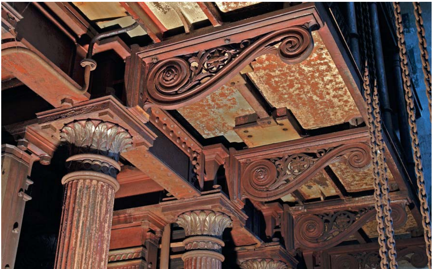
Wieża ciśnień przy ul. Na Grobli we Wrocławiu – detale zdobnicze (foto A. Olej-Kobus, K. Kobus, TravelPhoto)
