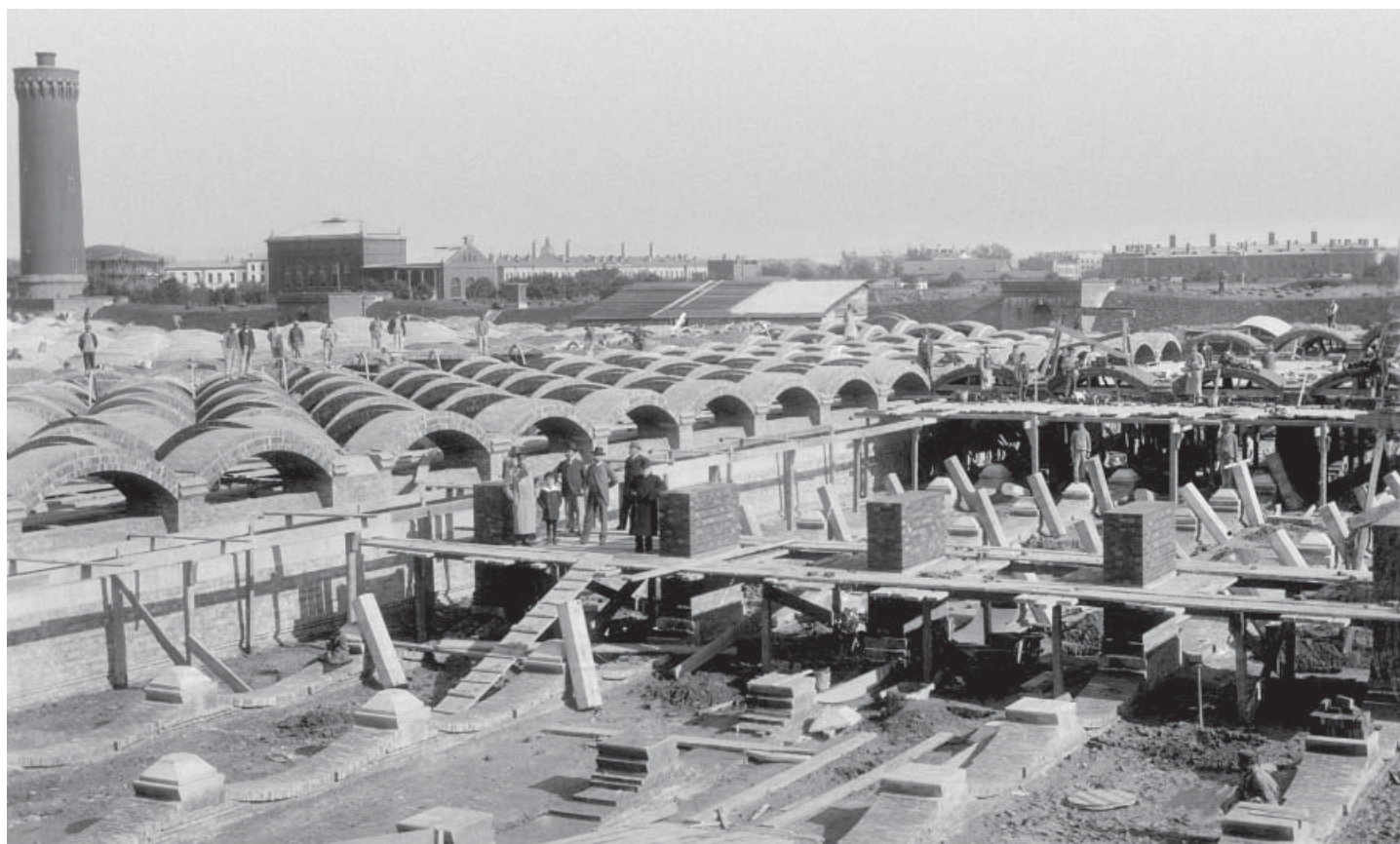
Warszawa. Budowa filtrów powolnych (arch. MPWiK Warszawa)
