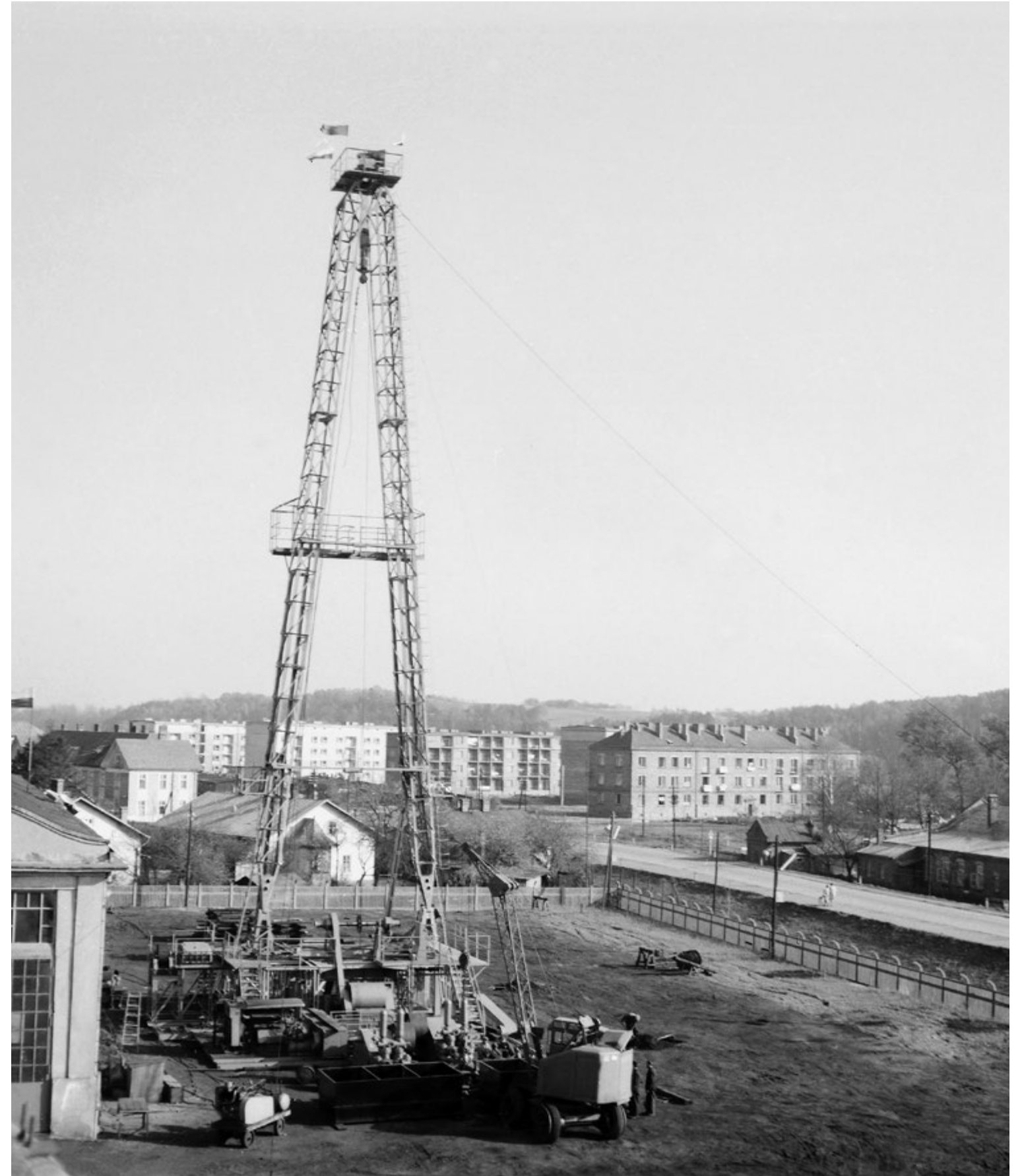
Montaż wieży wiertniczej w Fabryce Maszyn „Glinik” w Gorlicach / Installation of a derrick in the Machinery Factory “Glinik” in Gorlice
