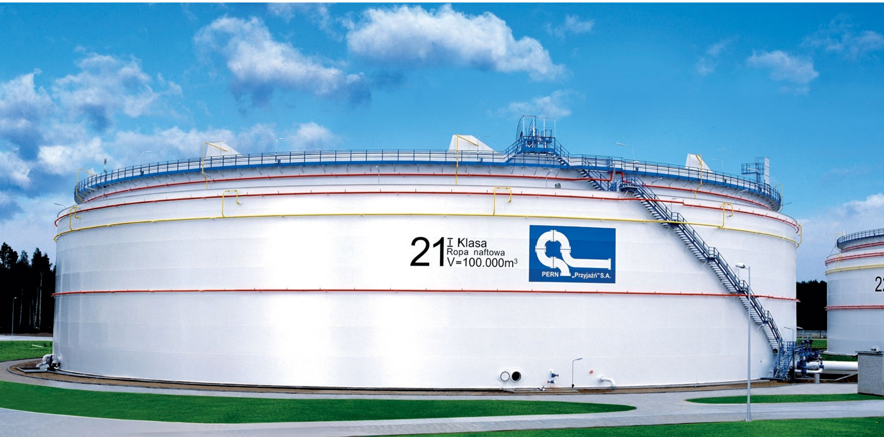
Zbiornik na ropę naftową w Adamowie o pojemności 100 000 m 3 z podwójnym dnem i płaszczem oraz pływającym dachem wykonany przez Mostostal Płock S.A. dla PERN Przyjaźń S.A. / Oil tank in Adamowo with the capacity of 100,000 m 3 , double bottom and shell and a floating roof, built by Mostostal Płock S.A. for PERN Przyjaźń S.A.
