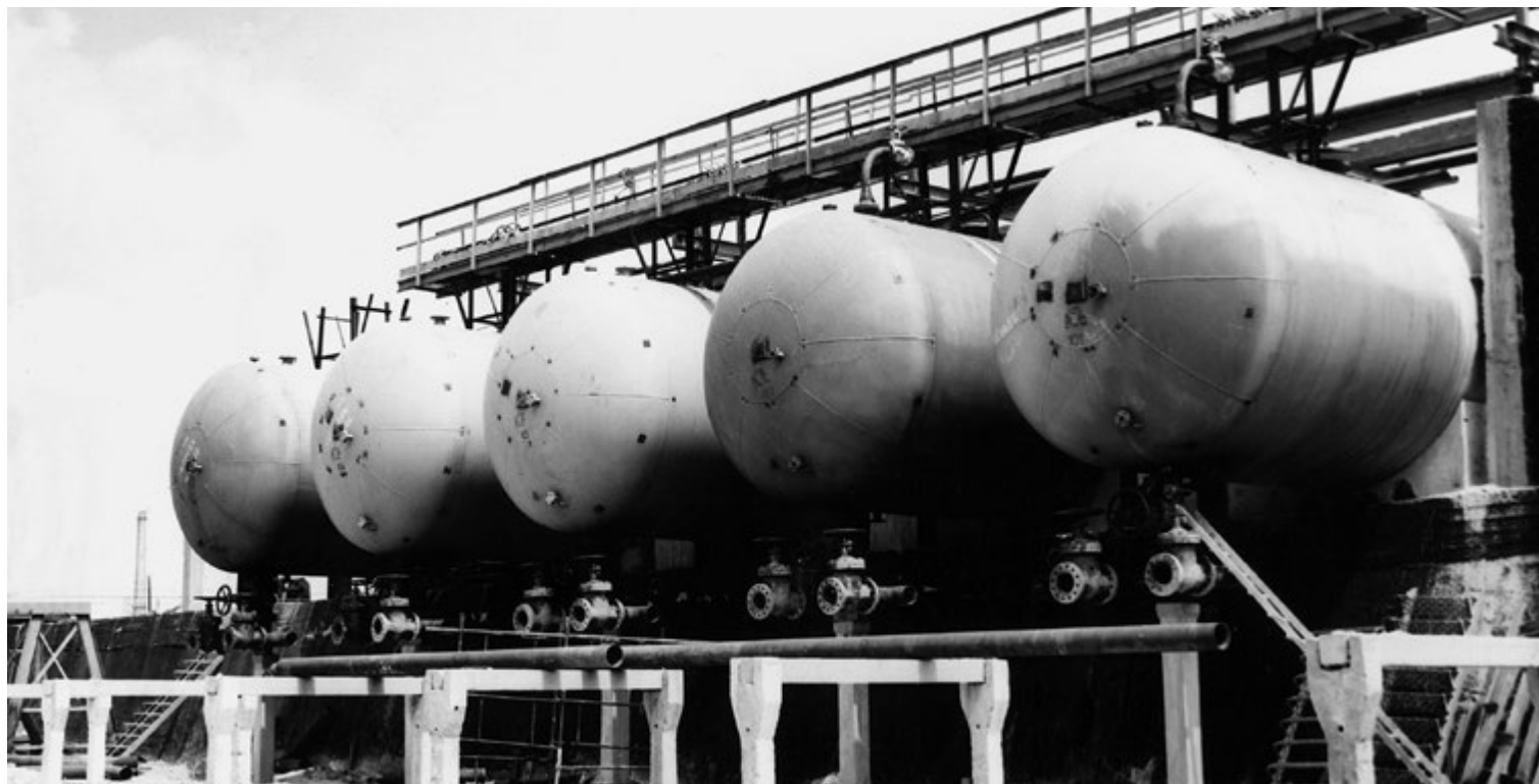
Płock – budowa zbiorników petrochemicznych / Płock – construction of petrochemical tanks
