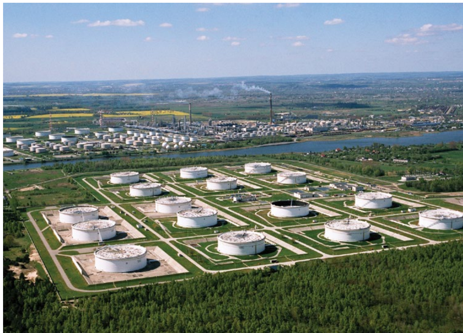
Zbiorniki na trasie rurociągu „Przyjaźń” w Gdańsku / Tanks on the route of the Druzhba Oil Pipeline in Gdańsk
