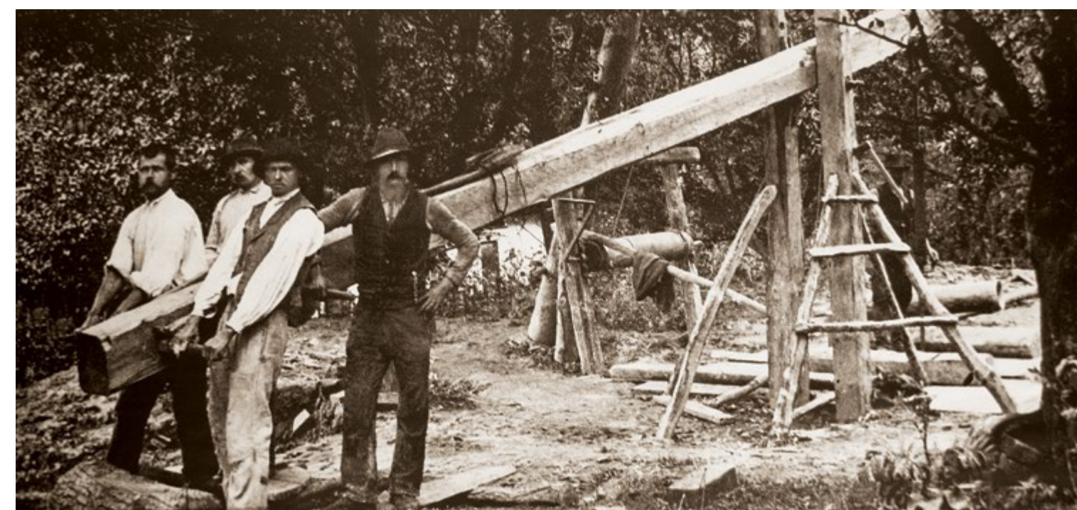
Kiwno ręczne – ropa pompowana była dzięki pracy ludzi. Sękowa, początek XX w. / A hand-operated nodding donkey – oil was pumped using human labour. Sękowa, early 20 th century
