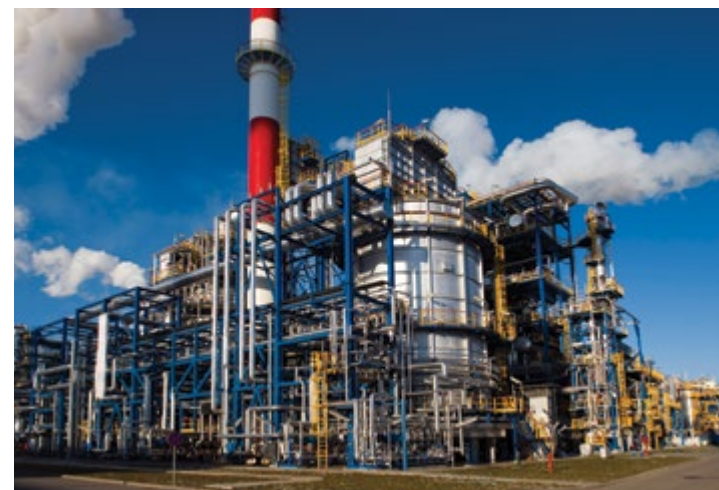
Rafineria Grupy Kapitałowej LOTOS w Gdańsku / Refinery in Gdańsk owned by LOTOS Capital Group
