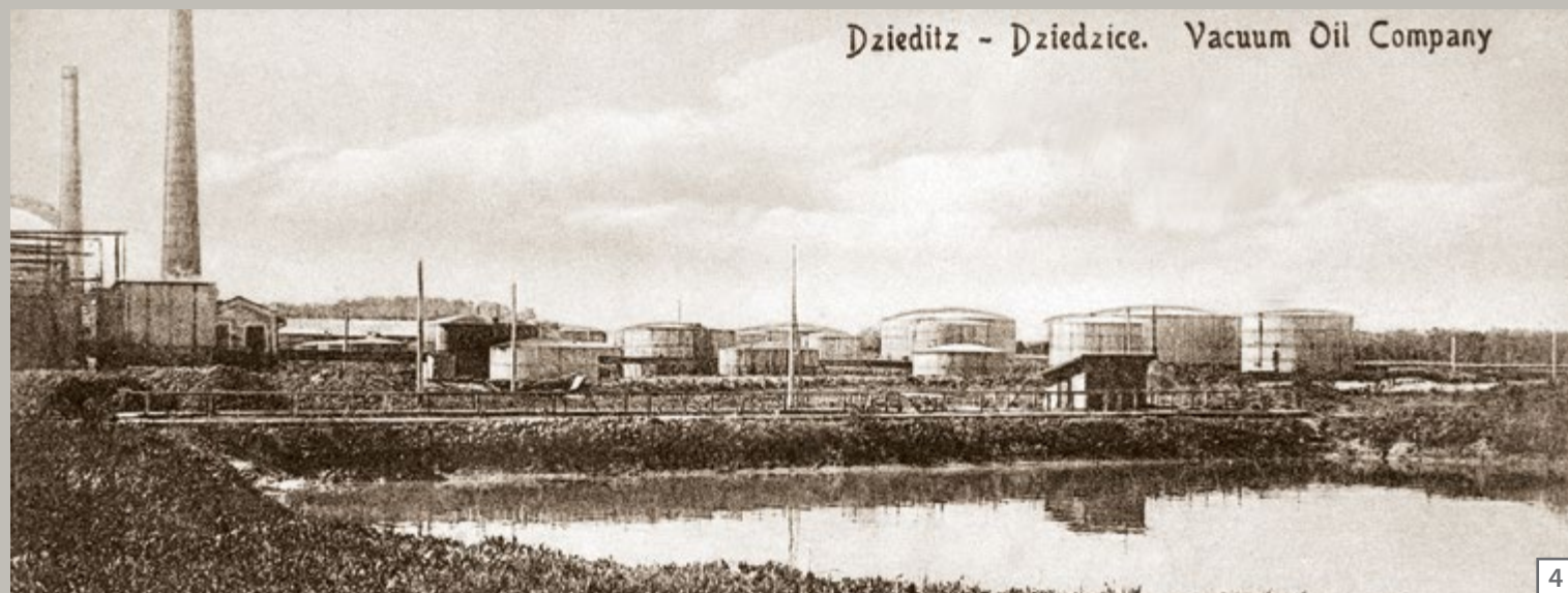
Wraz z rosnącym wydobywaniem rozwijały się rafinerie przetwarzające ropę naftową. Największymi z nich były zakłady w: Limanowej (1), Jasle (2), Trzebini (obecnie ORLEN Południe) (3) i Dziedzicach (4) / Along with increasing mining output petroleum refineries developed. The largest were the plants in: Limanowa (1), Jasło (2), Trzebinia (today ORLEN Południe) (3) and Dziedzice (4)
