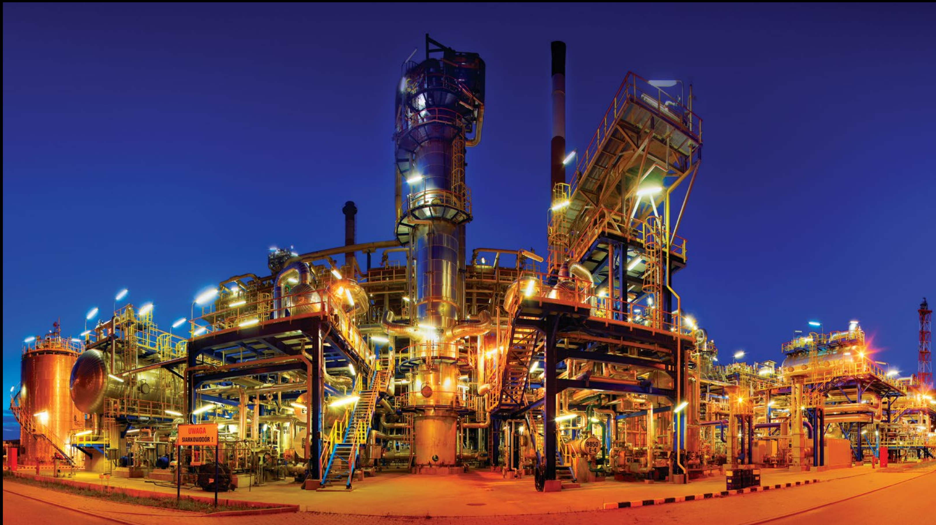
Rafineria Grupy Kapitałowej LOTOS w Gdańsku / Refinery in Gdańsk owned by LOTOS Capital Group
