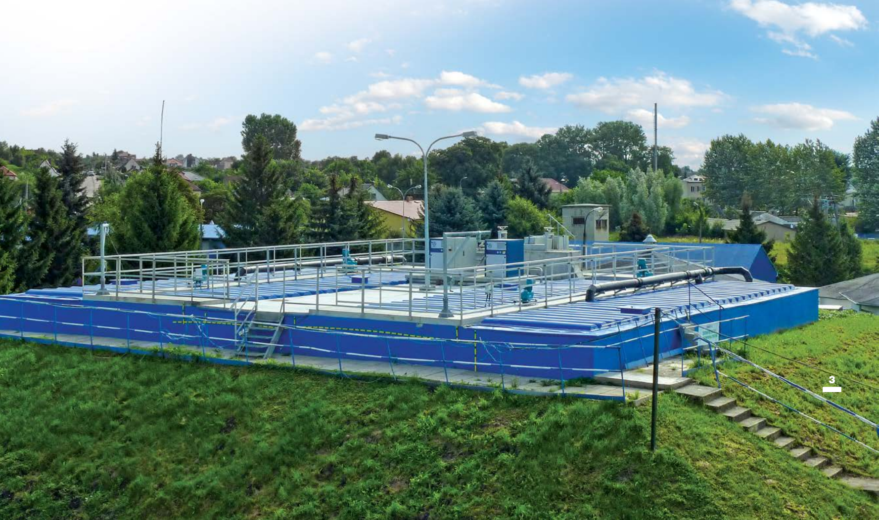
3. Zbiornik retencyjny na oczyszczalni ścieków w Sokółce
