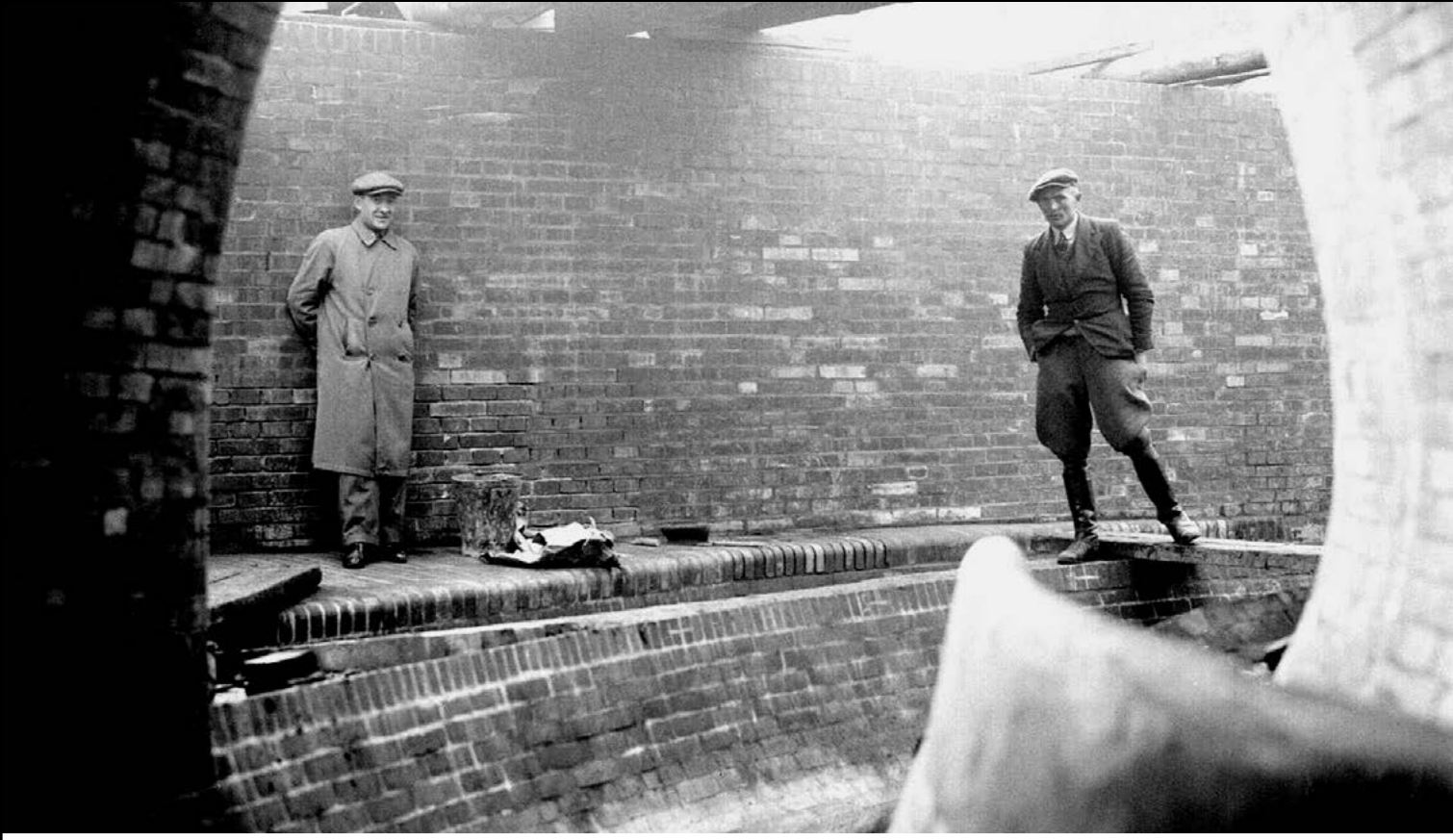
Budowa krytego koryta rzeki Łódki, gdzie znajduje się „podwieszany” kanał odbierający ścieki, lata 30. XX w.
