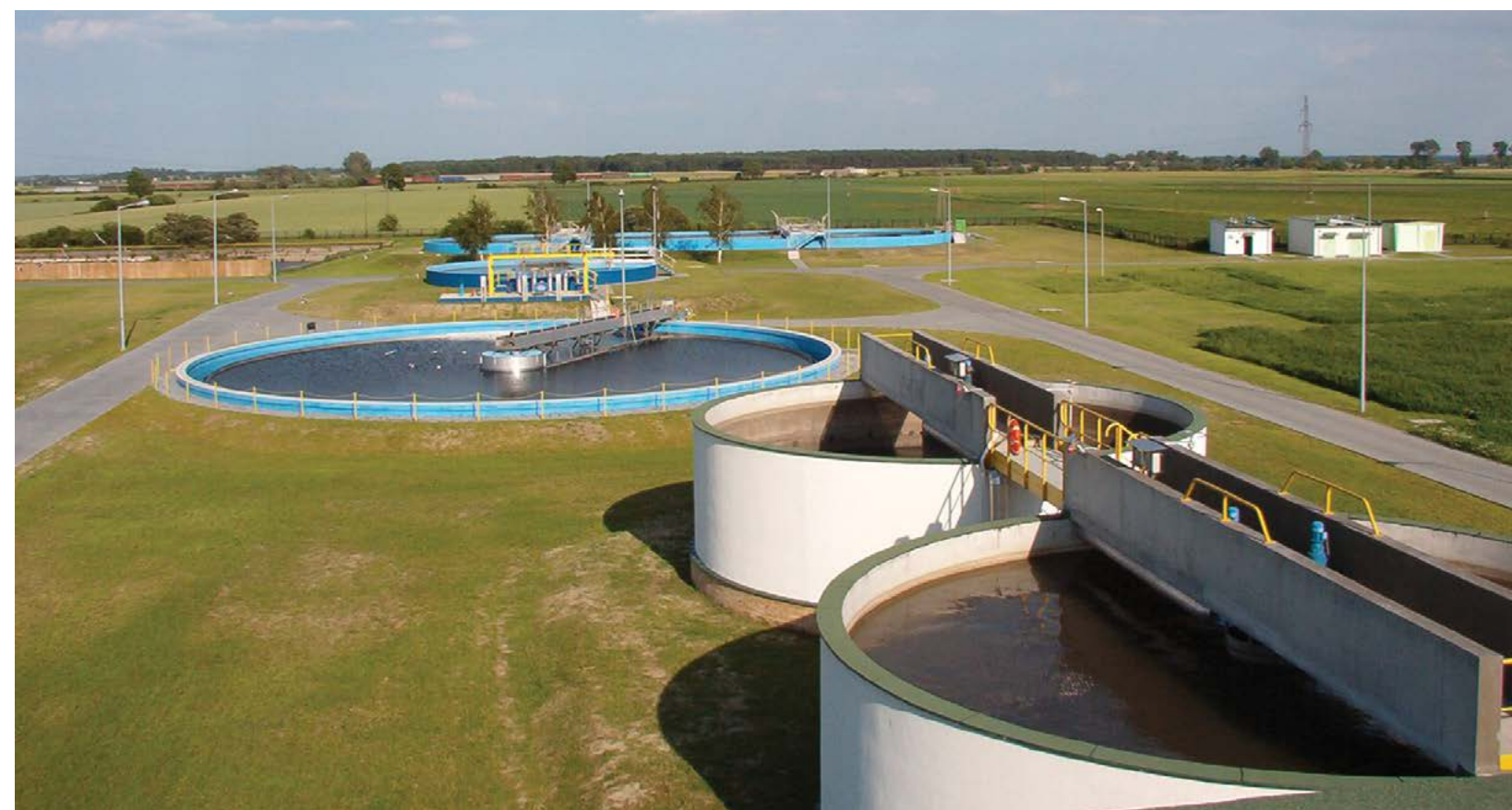
Oczyszczalnia ścieków w Chwałkowie
