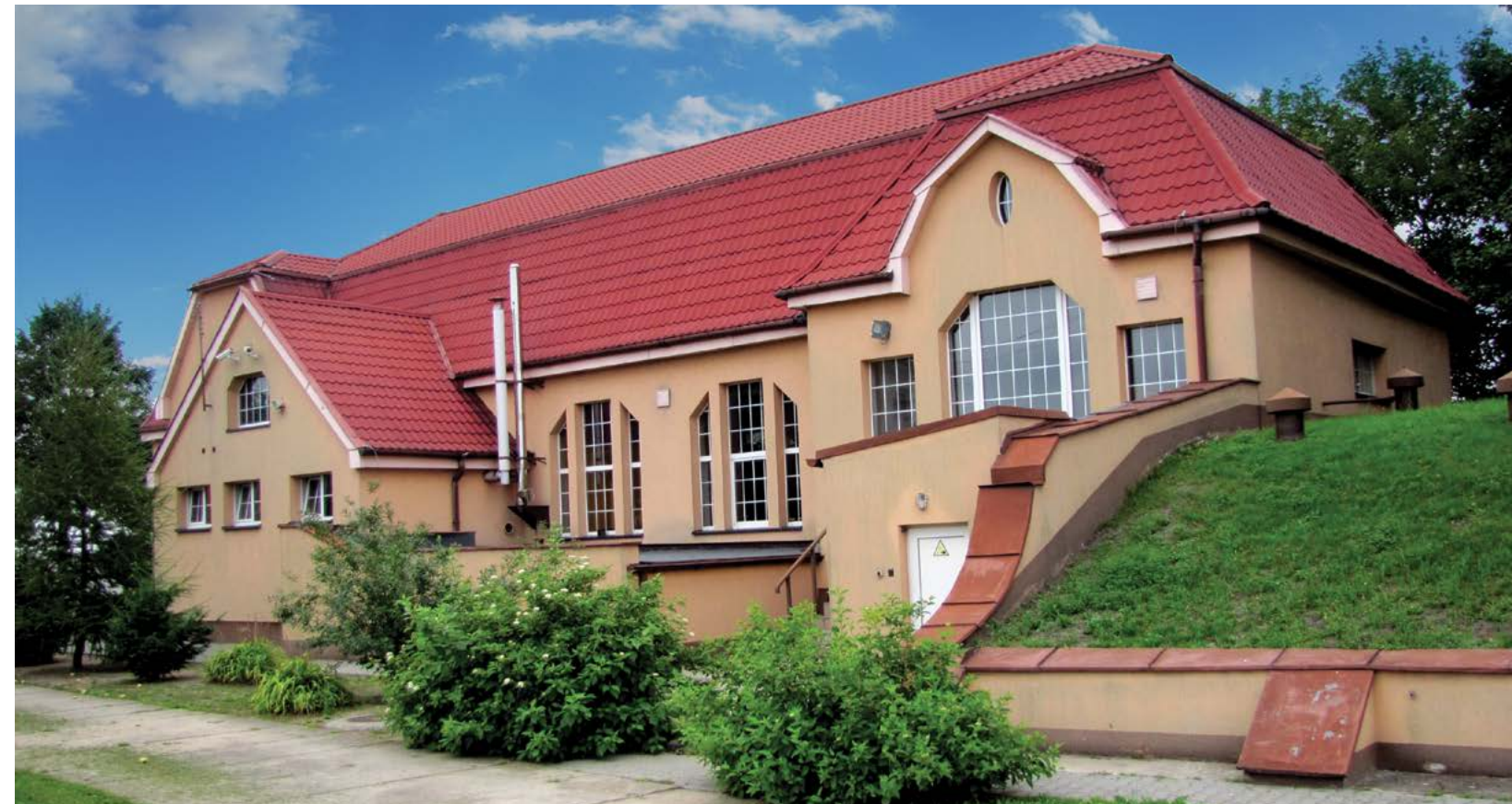
Stacja uzdatniania wody w Środzie Wielkopolskiej
