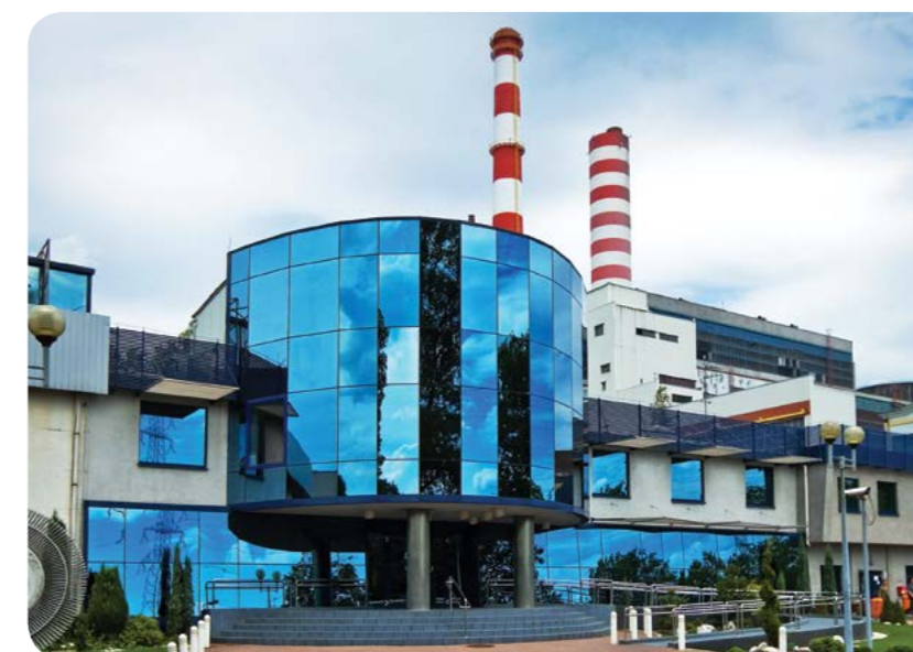
Elektrownia Łaziska / Łaziska Power Plant (Tauron Wytwarzanie)
