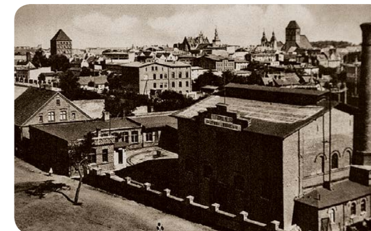
Elektrownia miejska w Chojnicach – ok. 1910 r. / Municipal Power Plant in Chojnice – ca. 1910 (arch. Photofactory®)
