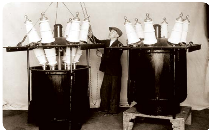
Montaż przekładników wysokiego napięcia w fabryce Szpotańskiego / Assembly of high voltage current transformers at the Szpotański factory (arch. Photofactory®)
