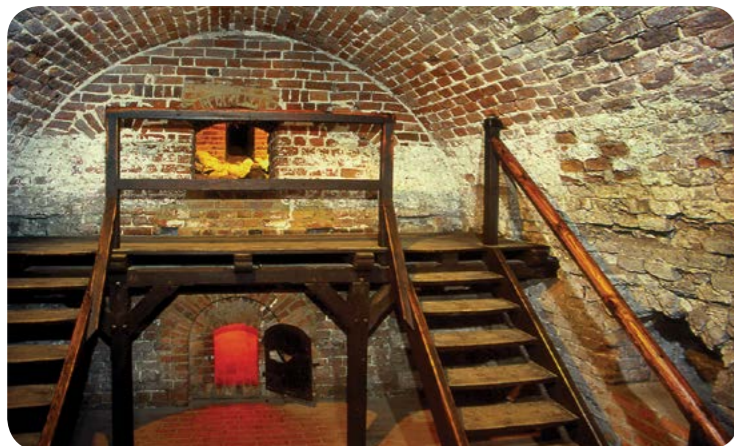
Piec pod Wielkim Refektarzem (po lewej) i wnętrze komory akumulacyjnej wypełnionej kamieniami na zamku w Malborku / The furnace under the Grand Refectory (on the left) and a stone-filled storage chamber the castel in Malbork (arch. Photofactory®)
