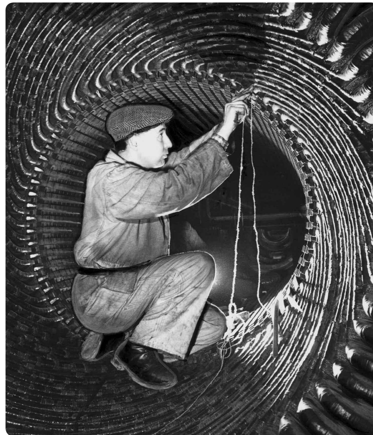
Elektrownia Jaworzno – elektryk przy sprawdzaniu uzwojeń generatora turboszespolu – 1955 r. The Jaworzno Power Plant – a fitter checking the coils of the turbine generator unit – 1955 (arch. Photofactory®)
