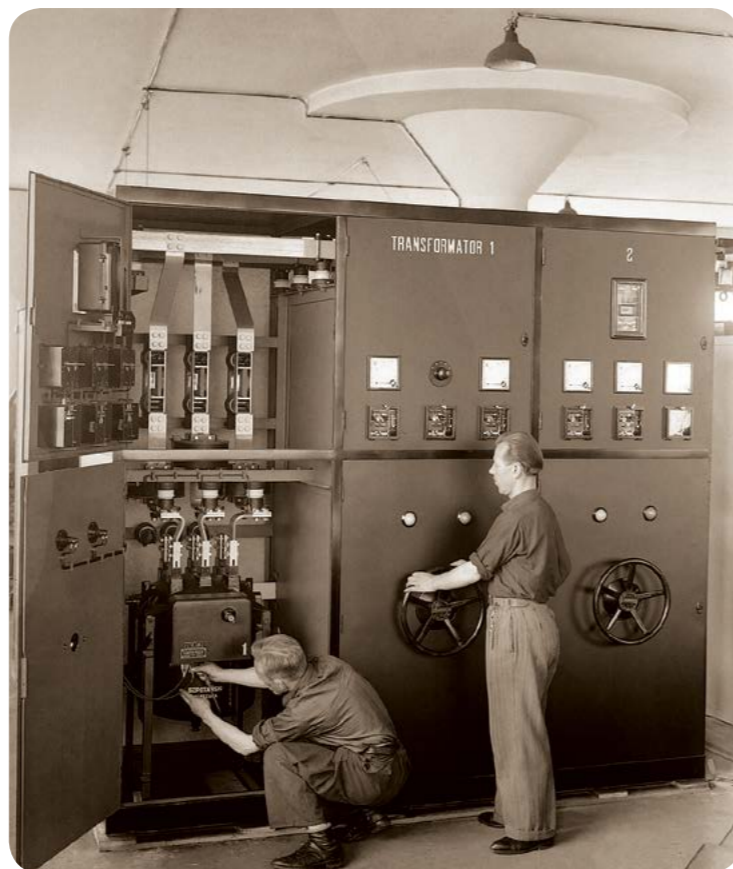
Rozdzielnica średnich napięć / Medium voltage switchgear (arch. Photofactory®)
