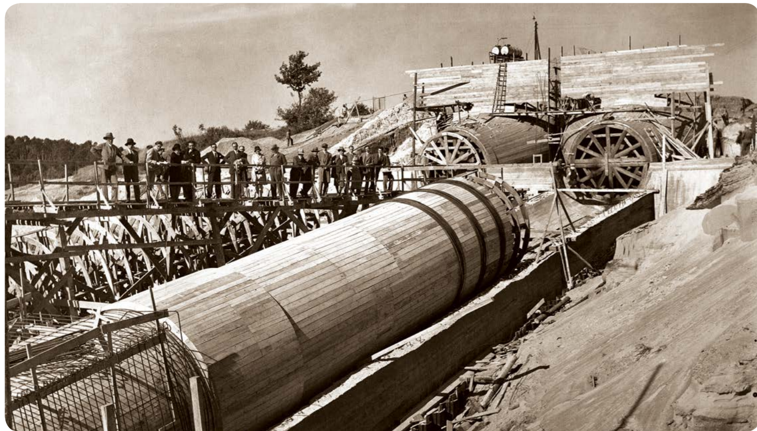
Budowa elektrowni wodnej Żur – opierzenie zamku wodnego, 1929 r. / Construction of the Żur hydropower plant – planking of the water lock, 1929 (arch. Photofactory®)
