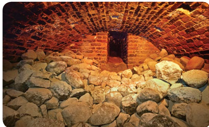
Piec pod Wielkim Refektarzem (po lewej) i wnętrze komory akumulacyjnej wypełnionej kamieniami na zamku w Malborku / The furnace under the Grand Refectory (on the left) and a stone-filled storage chamber the castel in Malbork (arch. Photofactory®)
