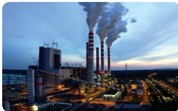
Zespół elektrowni Pątnów-Adamów-Konin wybudowany został w latach 1958-1974 The Pątnów-Adamów-Konin power plant complex was built in 1958-1974 (arch. Photofactory®)
