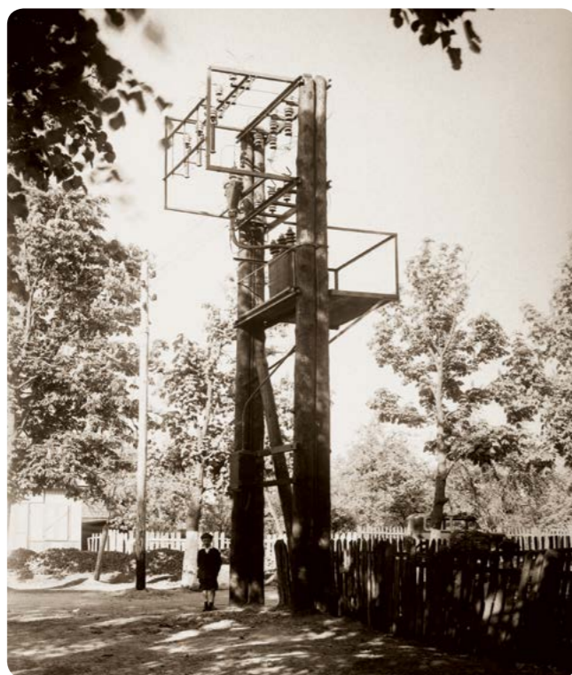
Jablonna – podstacja słupowa / Jablonna – pole substation (arch. Photofactory®)
