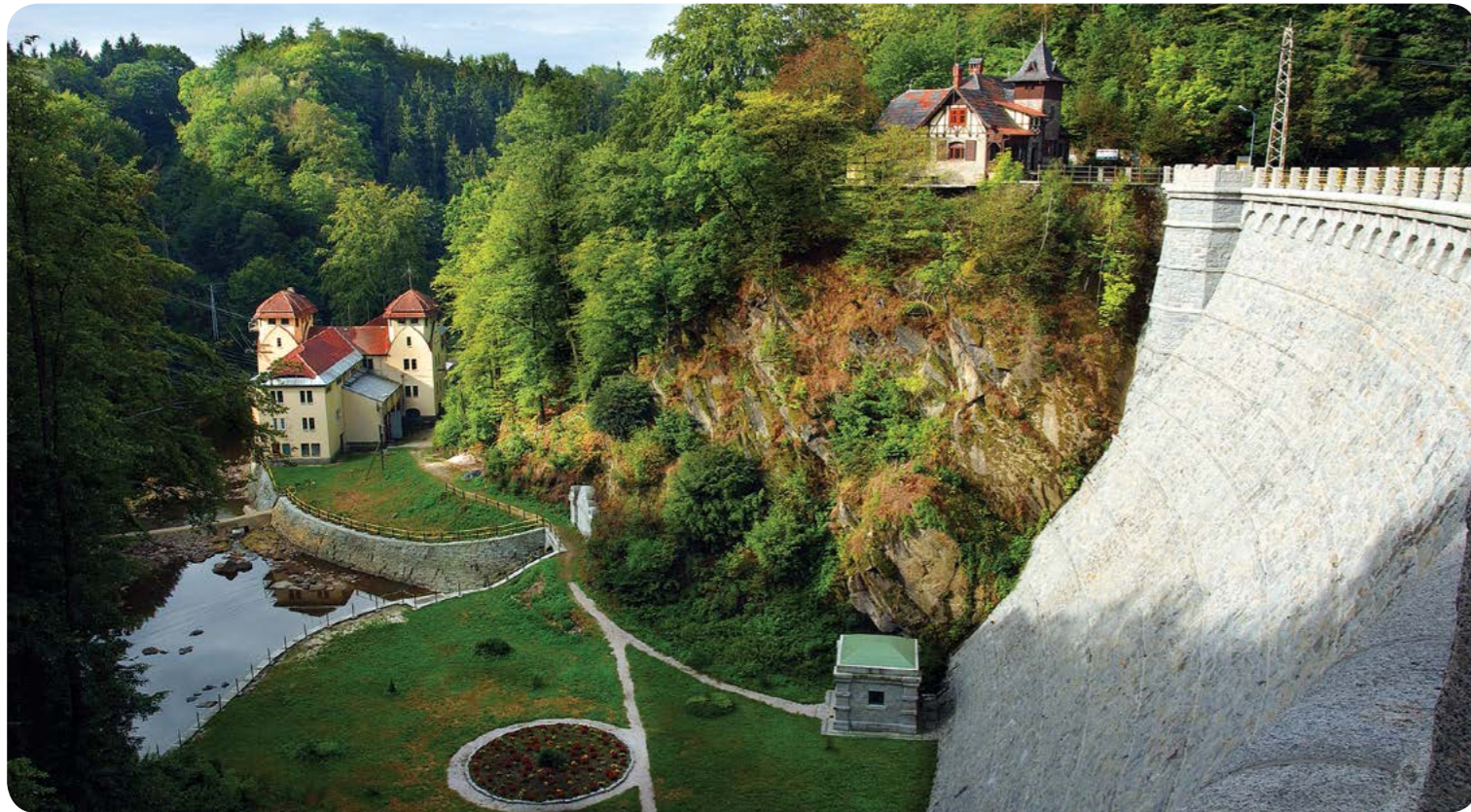
Elektrownia Wodna Leśna – najstarsza i zarazem pierwsza elektrownia zawodowa w Polsce Hydroelectric Power Plant Leśna – the oldest and at the same time the first commercial power plant in Poland (Tauron Ekogenergia)
