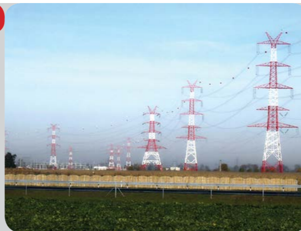
Linia czterotorowa 2x400kV/2x220kV Plewiska-Kromolice / Four-circuit 2x400kV/2x220kV Plewiska-Kromolice line
