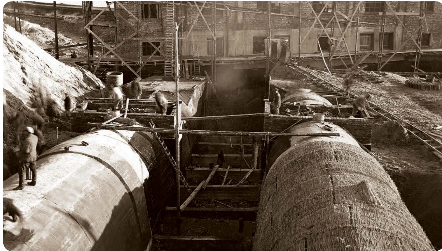
Budowa elektrowni wodnej Żur – izolowanie rur ciśnących, 1929 r. / Construction of the Żur hydropower plant – insulating the delivery pipes, 1929 (arch. Photofactory®)
