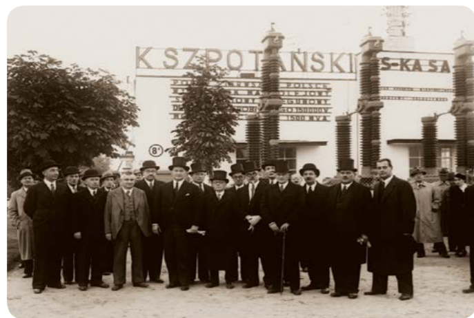
Pawilon FAE K. Szpotański podczas Wystawy Przemysłu Metalowego i Elektrotechniki w Warszawie w 1938 r. / The exhibition hall of Electrical Engines Factory – K. Szpotański at the Metal Industry and Electrical Engineering Fair in Warsaw in 1938. (arch. Photofactory®)
