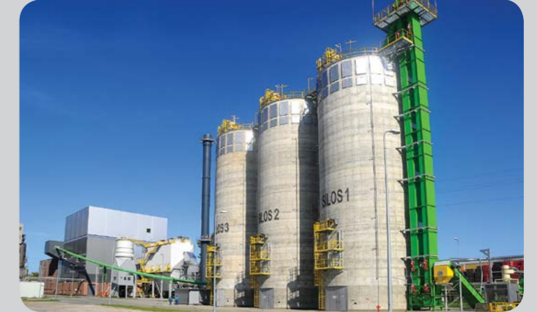
Elbląg – blok energetyczny Energa / Elbląg – Energa power unit
