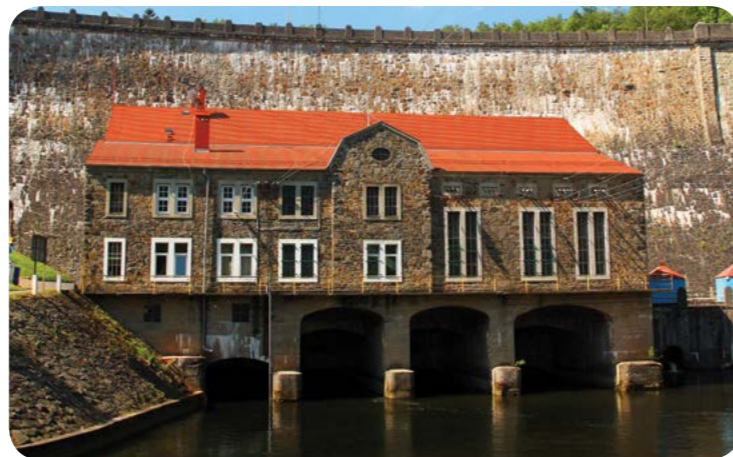
Elektrownia Wodna Złotniki o łącznej mocy zainstalowanej 4,42 MW ruszyła w 1924 r. The Złotniki Hydroelectric Power Plant with installed capacity totalling 4.42 MW was put into operation in 1924 (Tauron Ekoenergia)
