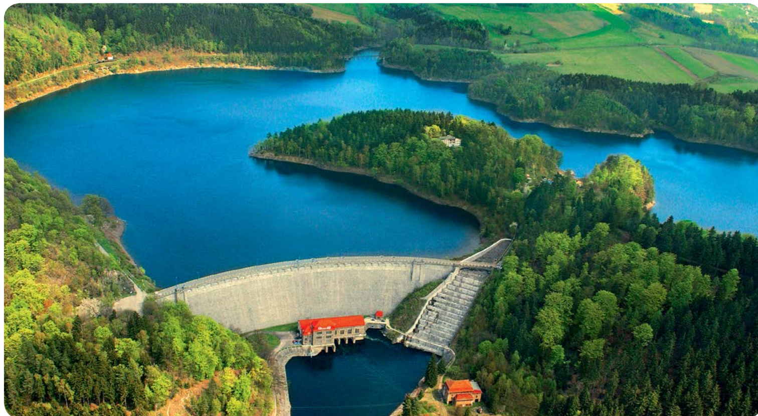
Wysoka na 62 m i długa na 270 m zapora na Bobrze w Pilchowicach / 62 m tall and 270 m long dam on the Bóbr in Pilchowice (Tauron Ekoenergia)
