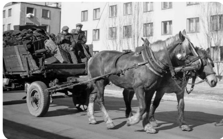
Transport węgla do jednej z miejskich kotłowni – lata 50. XX w. / Transport of coal to one of the city boiler plants – the 1950s (arch. Photofactory®)
