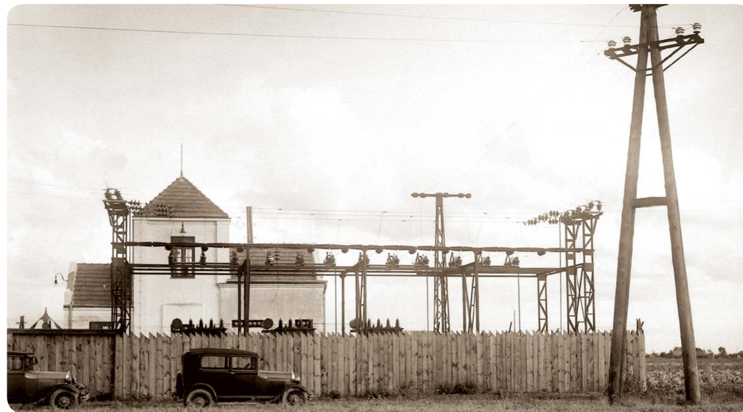
Karolino – podstacja / Karolino – substation (arch. Photofactory®)
