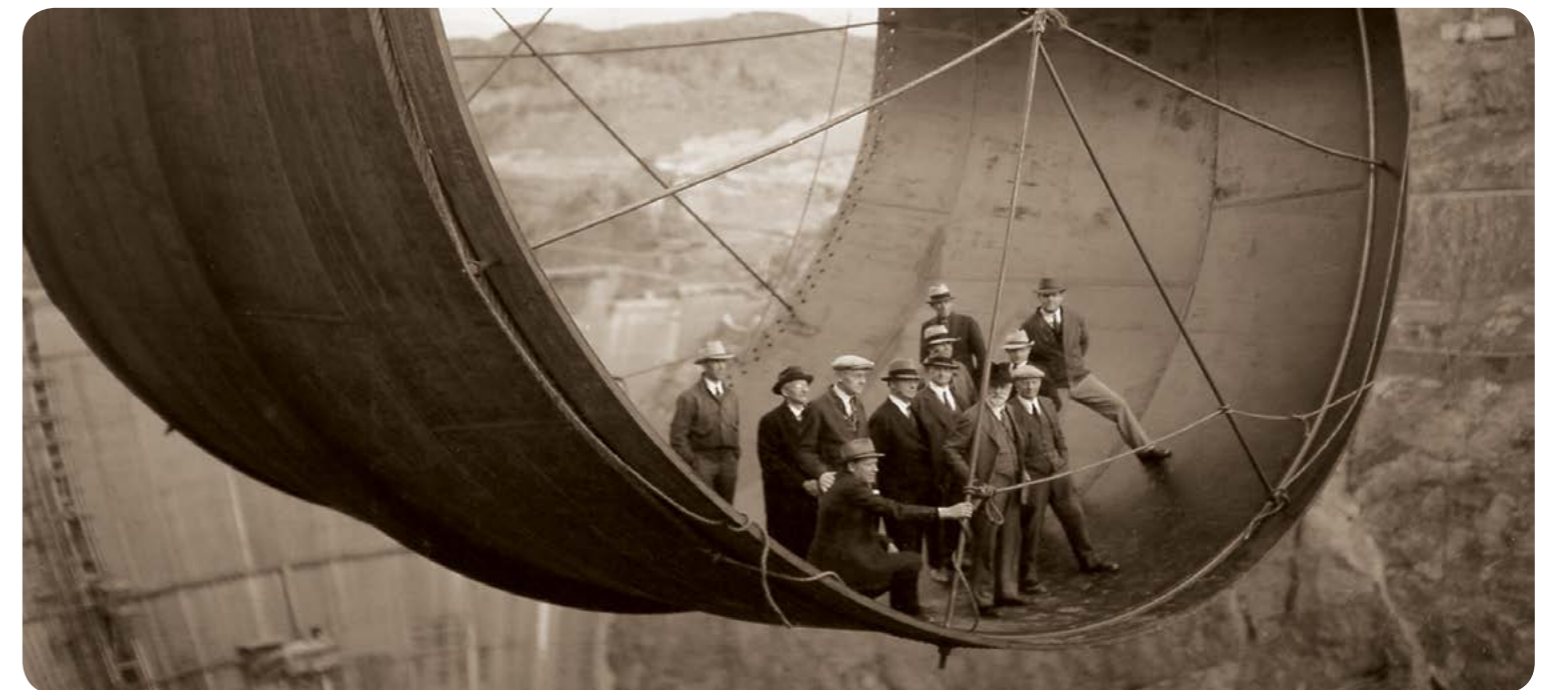
Fragment śluzy służącej do spuszczenia wody z jeziora Mead, budowa zapory Hoovera 1935 r. A fragment of the sluice on Lake Mead, construction of the Hoover Dam, 1935 (arch. Photofactory®)
