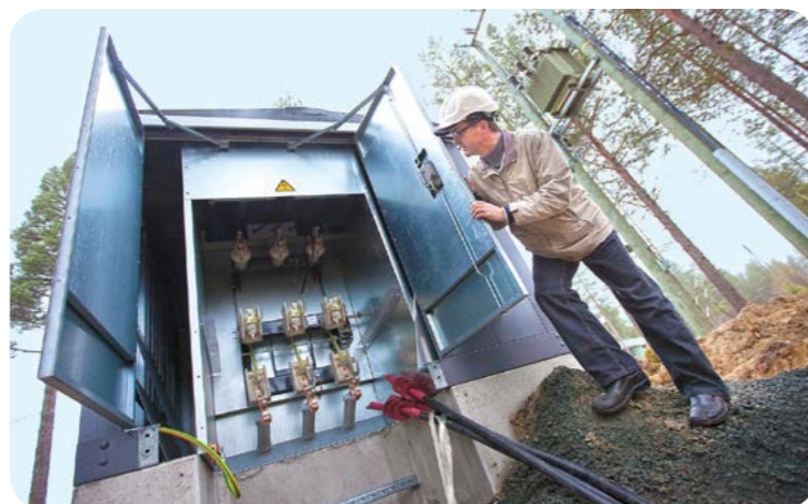
Stacja transformatorowa / Transformer station (arch. Photofactory®)
