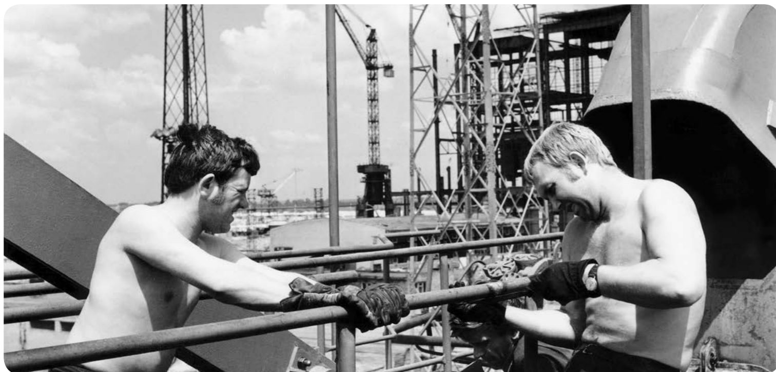
Elektrownia Kozienice – Leszek Bartin i Zbigniew Magiera podczas montażu rozładowarki węgla The Kozienice Power Plant – Leszek Bartin and Zbigniew Magiera installing a coal discharge unit (arch. Photofactory®)
