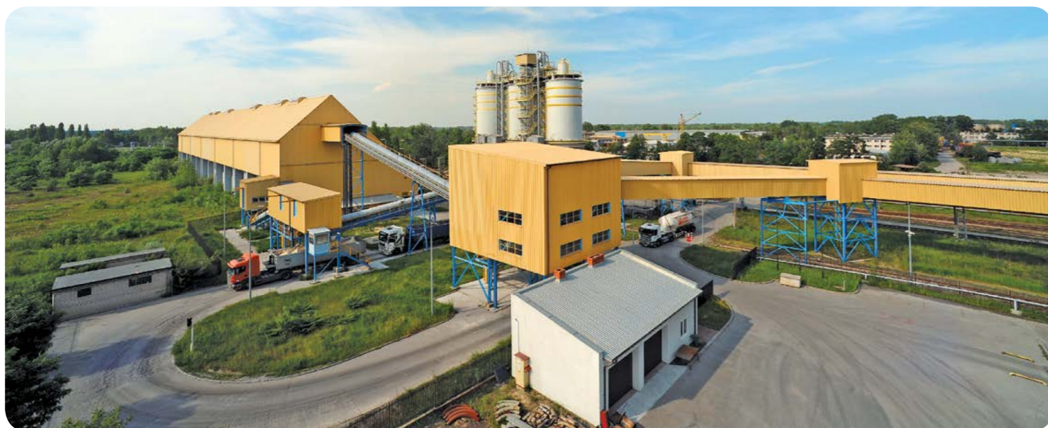
Ponad 60% odpadów paleniskowych elektrowni jest zagospodarowywane przez cementownie i zakłady produkujące materiały budowlane, na zdjęciu magazyn gipsu i zbiorniki retencyjne popiołu / More than 60% of furnace waste from power plants is disposed of by cement plants and manufacturers of construction materials; photo: gypsum storage and ash storage tanks (ENEA Wytwarzanie)
