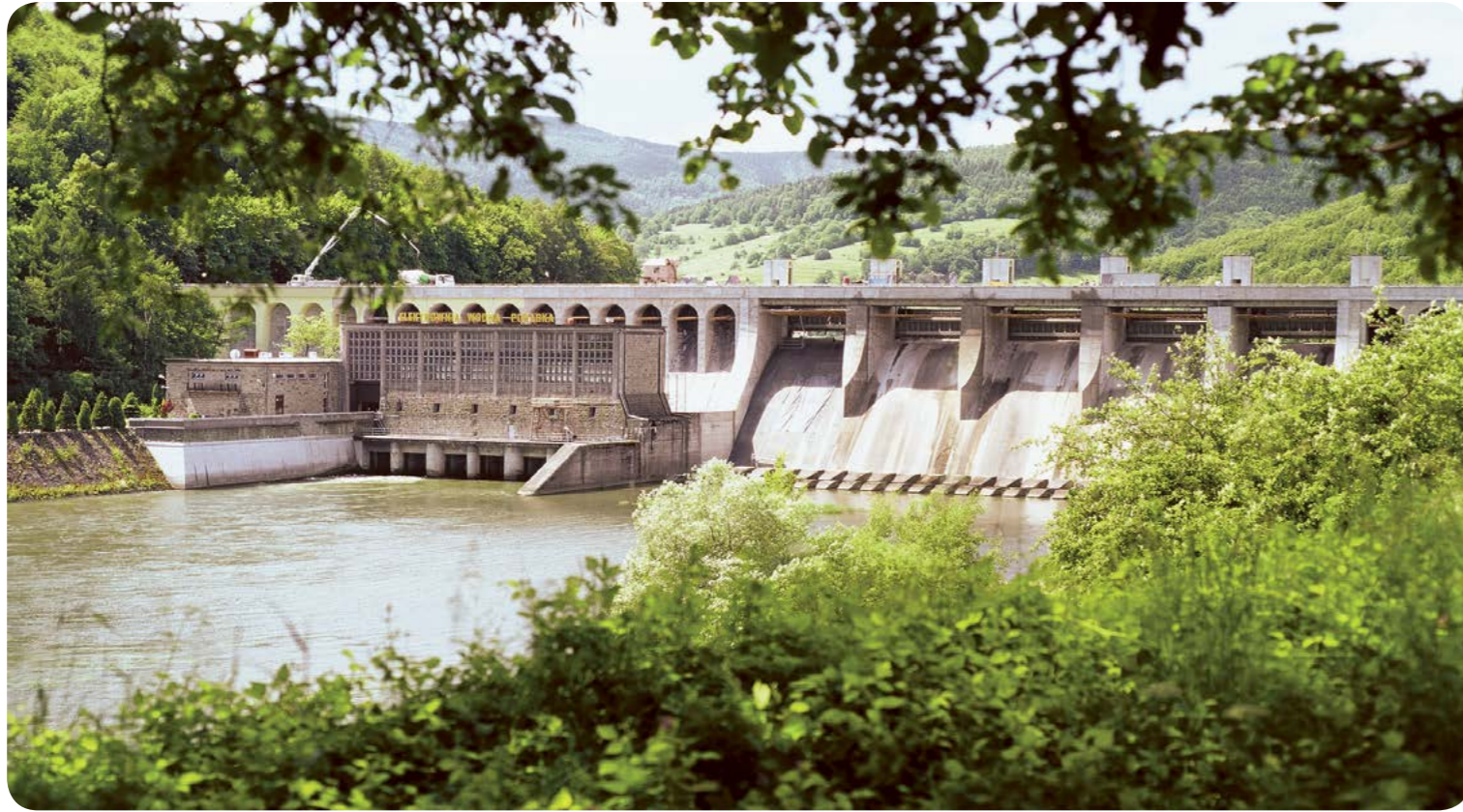
Druga co do wielkości elektrownia szczytowo-pompowa w Polsce – Elektrownia Wodna Porąbka Second largest pumped-storage plant in Poland – Hydroelectric Power Plant Porąbka (arch. Photofactory®)
