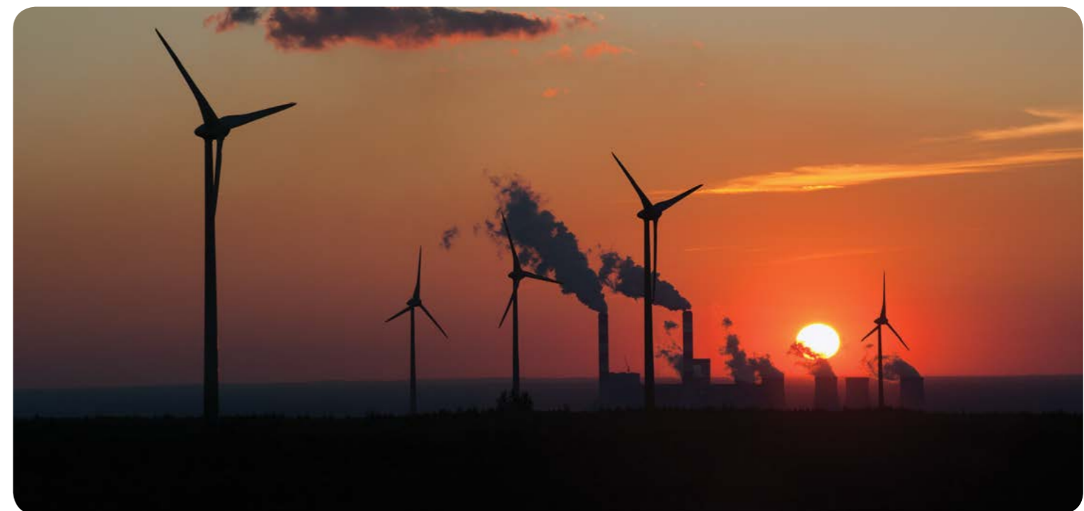
Parł Wiatrowy Kamięńsk / Kamięńsk Wind Farm – PGE Energia Odnawialna (arch. Photofactory®)
