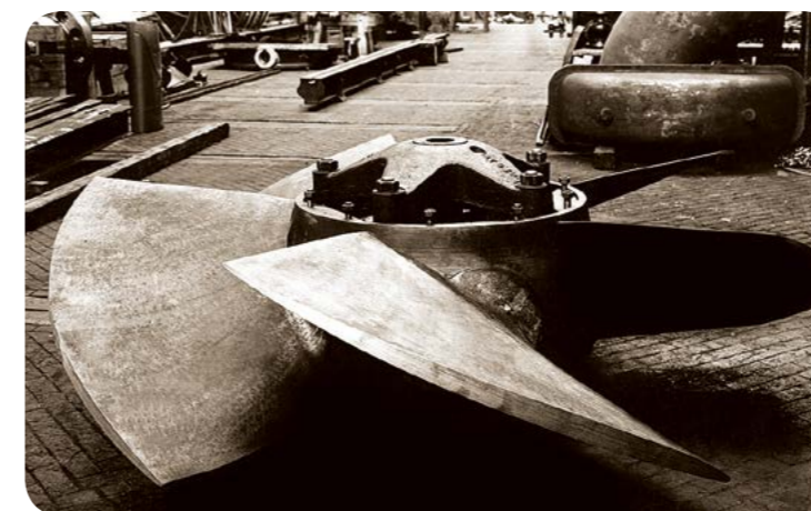
Wirnik (śmigło) turbiny wodnej systemu Kaplana o mocy 6000 KM, 1930 r. 6000 HP Kaplan turbine wheel (propeller), 1930 (arch. Photofactory®)
