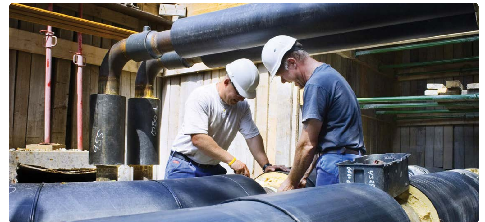
Wymiana rurociągów na preizolowane znacznie ogranicza straty ciepła / Replacing pipelines with pre-insulated ones considerably reduces heat losses (arch. Photofactory®)
