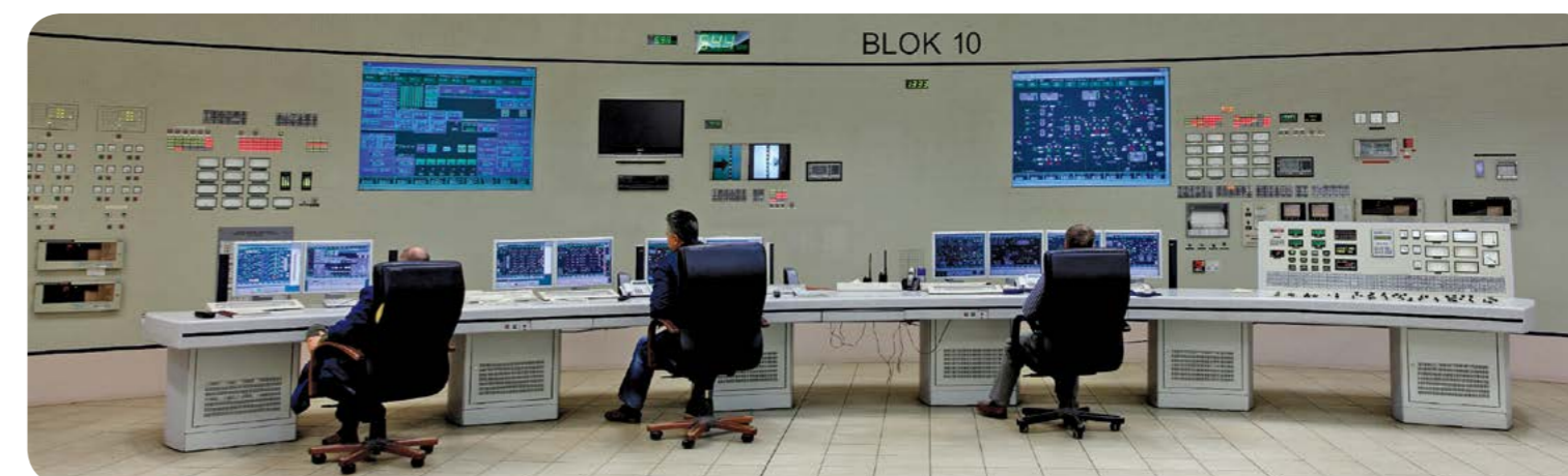
Nastawnia „pięsetek” blok nr 10 - Elektrownia Kozienice / “500” control room, power unit no. 10 – Kozienice Power Plant (ENEA Wytwarzanie)
