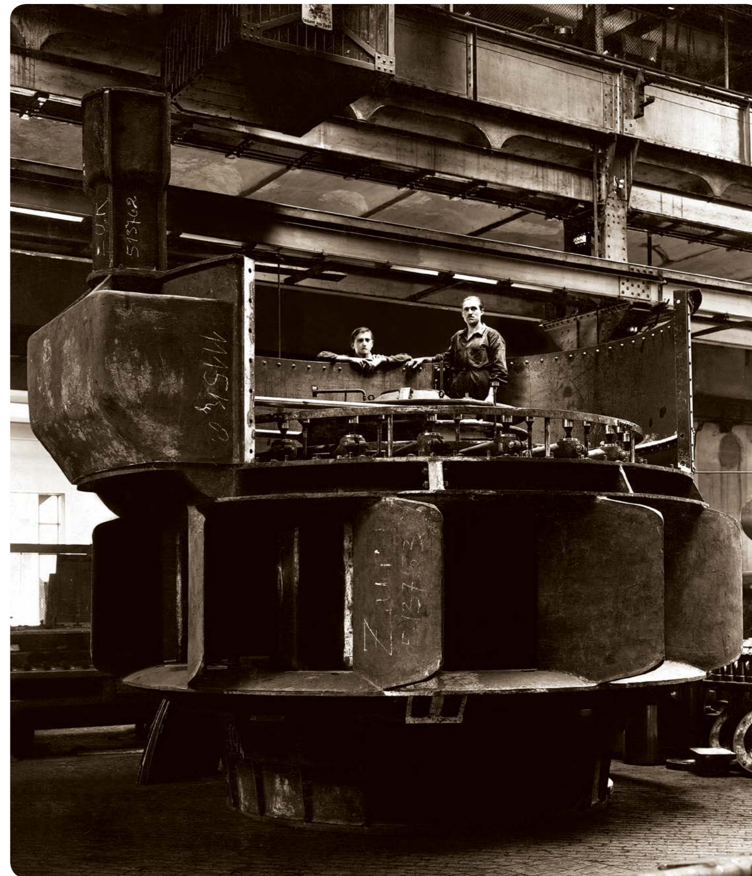
Budowa elektrowni wodnej Żur – montaż w fabryce (Austria) głównego kadłuba turbiny wodnej Kaplana, 1929 r. / Construction of the Żur hydropower plant – assembly of the main body of the Kaplan turbine at the factory (Austria), 1929 (arch. Photofactory®)
