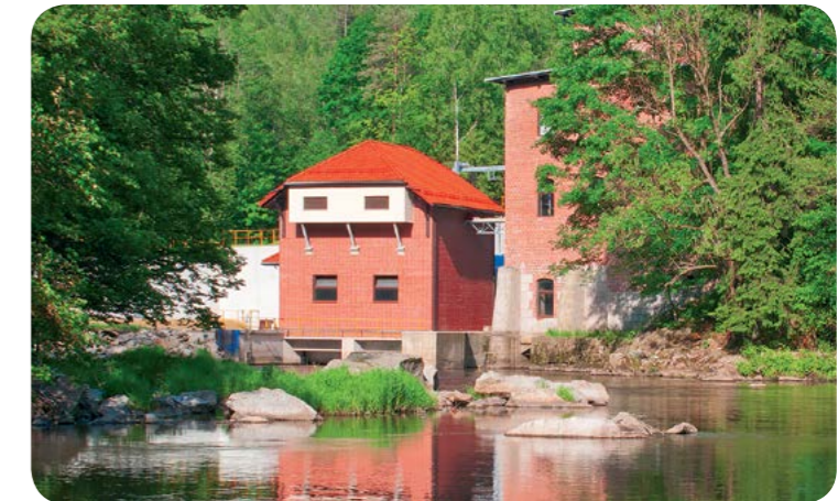
Elektrownię Wodną Bobrowice IV włączono do sieci w 2008 r. / The Bobrowice IV Hydroelectric Power Plant was connected to the grid in 2008 (Tauron Ekoenergia)
