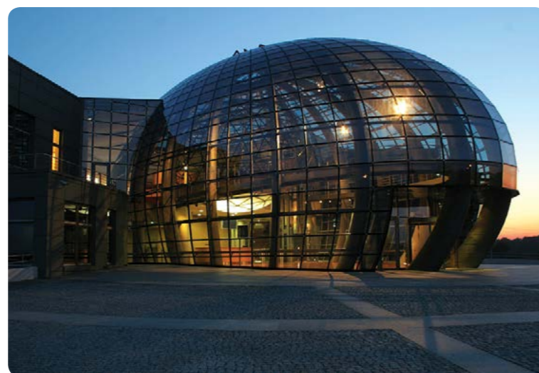
Siedziba Polskiej Sieci Elektroenergetycznej Operator S.A. w Konstancinie-Jeziorna / Headquarters of Polskiej Sieci Elektroenergetycznej Operator S.A. in Konstancin-Jeziorna (arch. PSE)
