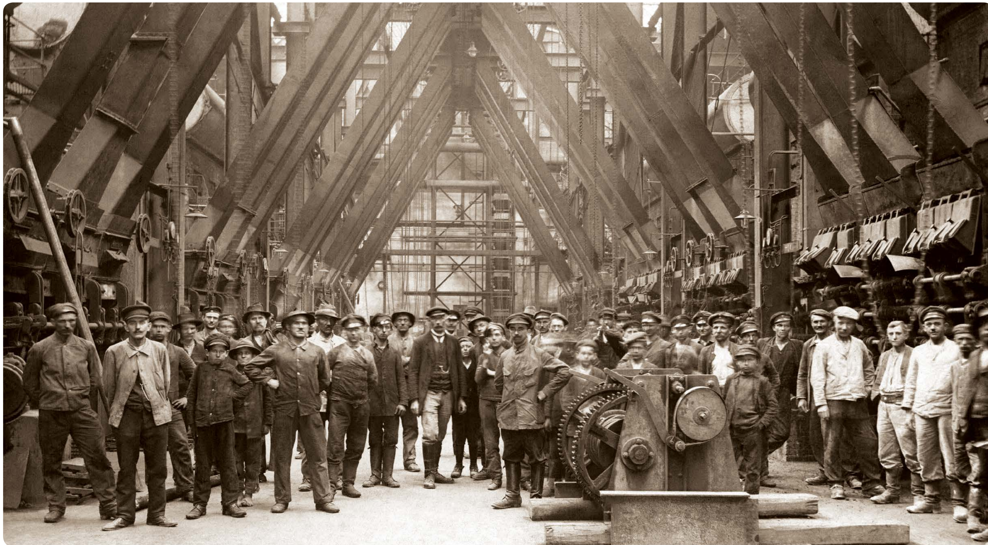
Budowa kotłowni w elektrowni w Łaziskach – 1917 r. / Construction of a boiler house in the power plant in Łaziska – 1917 (arch. Photofactory®)
