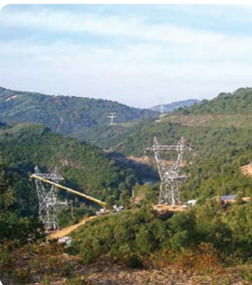
Linia 225 kV Argentiere – Serre – Poncon (Francja) / 225 kV Argentiere – Serre – Poncon (France) line
