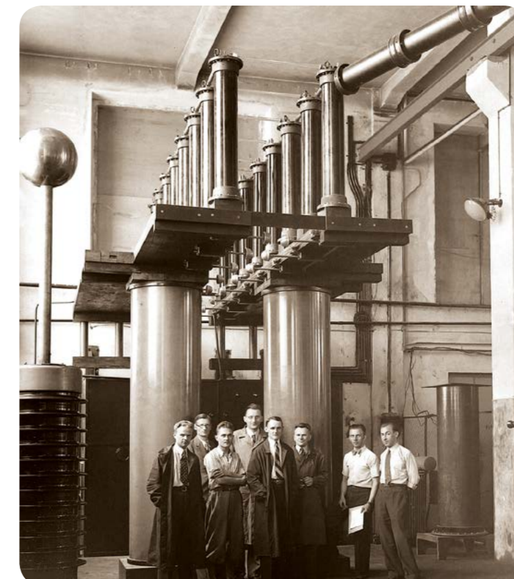
Zaplecze badawczo-rozwojowe w fabryce Szpotańskiego. Próba napięciowa łańcucha izolatorów z armaturą ochronną wykonywana za pomocą transformatora probierczego 600 kV i mocy trwałej 165 kVA (po lewej). Transformator probierczy na napięcie 1 600 000 V wykonany w Fabryce Aparatów Elektrycznych (po prawej) / R&D facilities at the Szpotański Factory. Voltage test of the chain of insulators with protective fittings by means of a 600 kV test transformer with continuous rating 165 kVA (on the left); 1600 000 V test transformer produced by the Electrical Engines Factory (on the right) (arch. Photofactory®)
