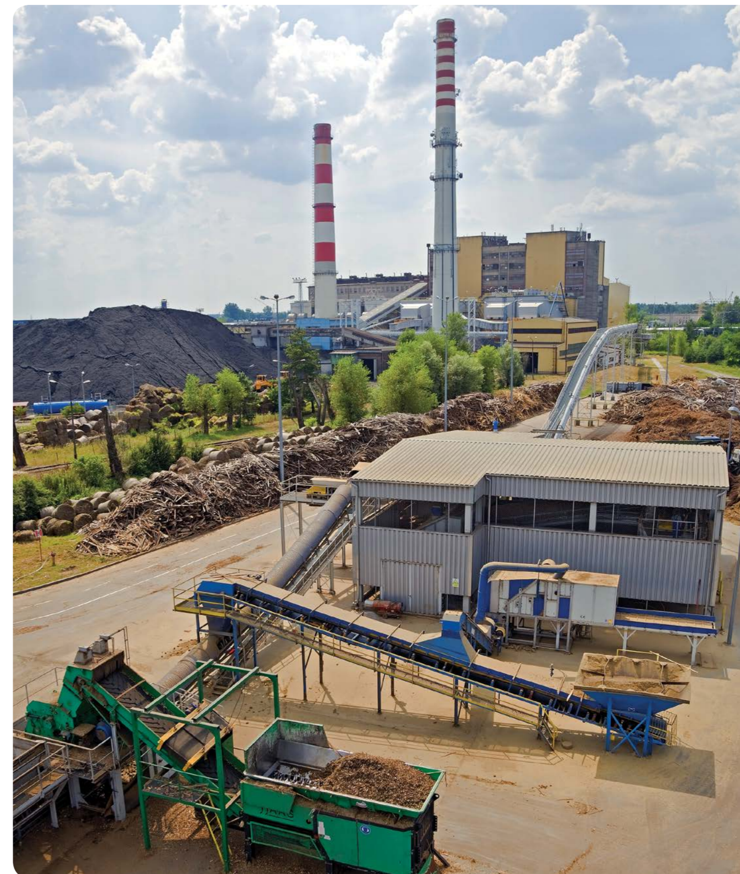
Instalacja współpalania biomasy w Elektrowni Stalowa Wola / Biomass co-combustion installation at the Stalowa Wola Power Plant (arch. Photofactory®)
