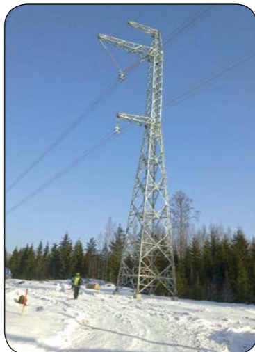
Linia 450 kV DC Nikuviken – Anttila (Finlandia) / 450 kV DC Nikuviken – Anttila (Finland) line
