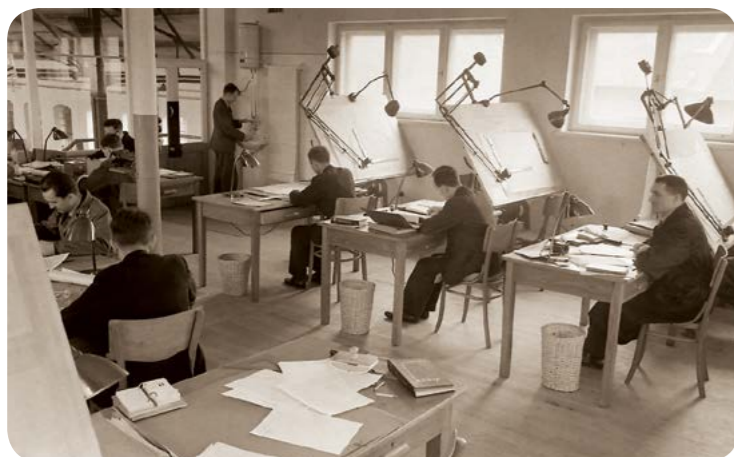
Biura konstrukcyjno-rozwojowe fabryki Szpotańskiego Design and development offices at the Szpotański factory (arch. Photofactory®)
