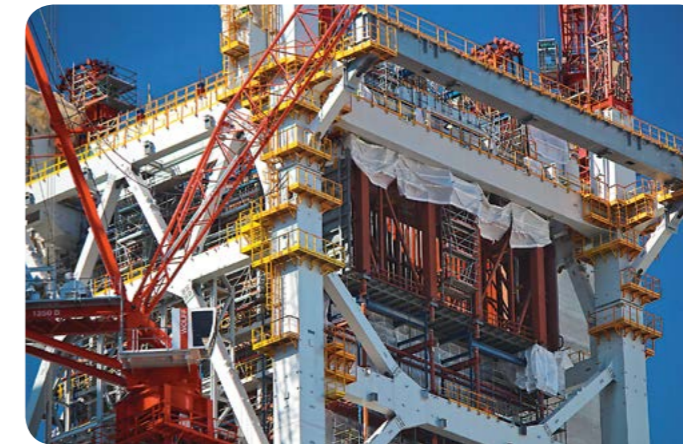
Elektrownia Opole – konstrukcja nośna wraz z rusztem nośnym kotła nr 6 / Opole Power Plant – load bearing structure and grid of boiler no. 6
