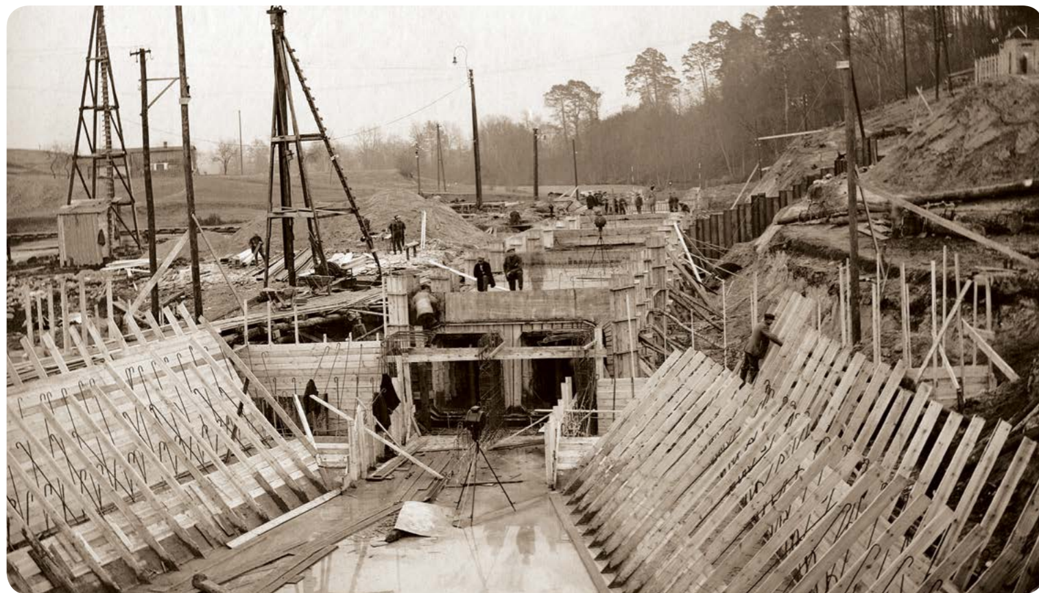
Budowa elektrowni wodnej Żur – wlot i żelbetowe rury spustu, 1928 r. / Construction of the Żur hydropower plant – inlet and reinforced concrete outlet pipes, 1928 (arch. Photofactory®)
