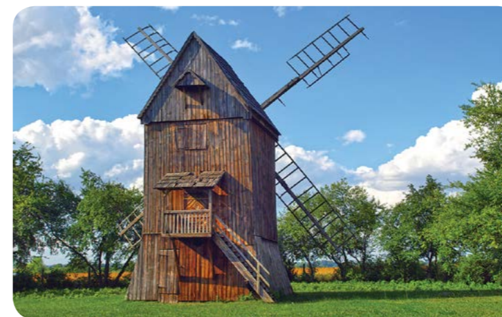
Paltraki miały rolkowe łożyska co ułatwiało obracanie „na wiatr” / Roller windmills had roller bearings which facilitated turning them to the wind (arch. Photofactory®)
