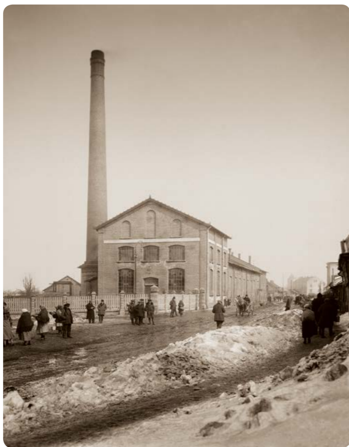
Budynki elektrowni w Przemyślu uruchomionej w 1896 r. / Buildings of the power plant in Przemyśl commissioned in 1896 (arch. Photofactory®)
