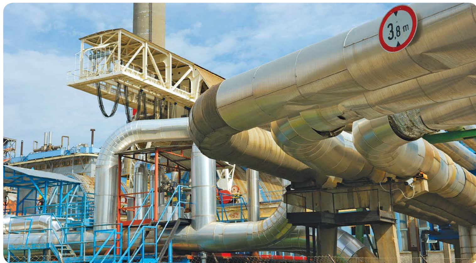
Nowoczesna sieć ciepłownicza przy elektrociepłowni / A modern district heating system attached to a CHP (arch. Photofactory®)
