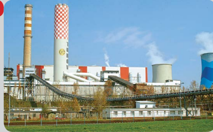
Elektrownia Turów / Turów Power Plant
