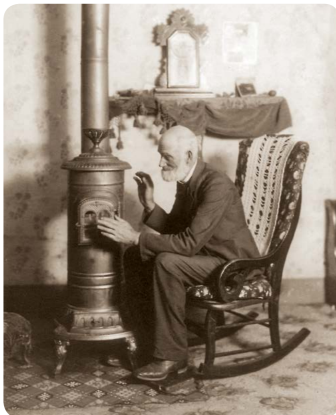
Piecyki żeliwne były idealnym rozwiązaniem ze względu na zamknięte palenisko i dekoracyjną obudowę – mogły pełnić rolę atrakcyjnego mebla / Cast iron stoves were an ideal solution with regard to their closed furnace and decorative housing – they could play a role of an attractive piece of furniture (arch. Photofactory®)
