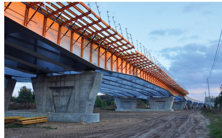
Betonowe filary i podpory mostu w Toruniu, MZD Toruń
