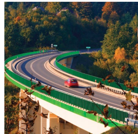
Wiadukt – Świnna Poręba
