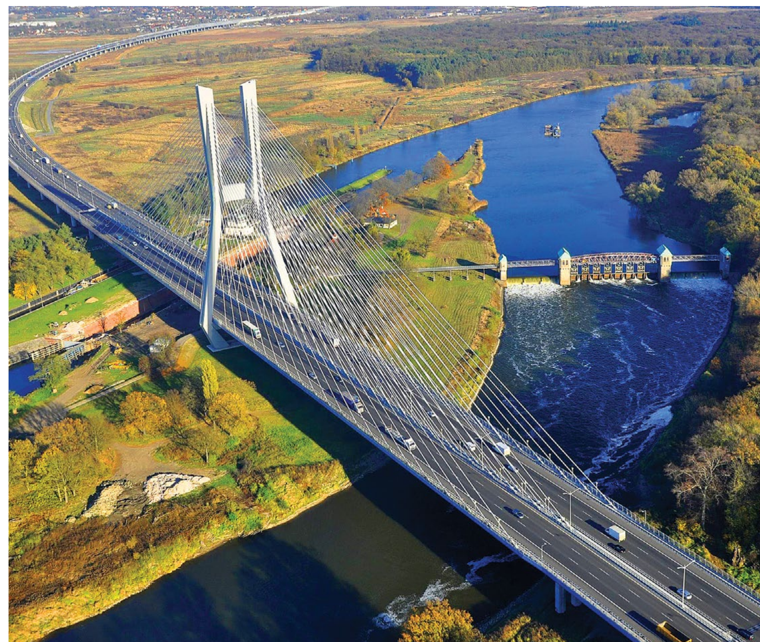
Most Rędziński we Wrocławiu, Mostostal Warszawa
