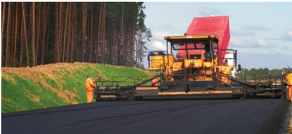
Układanie nawierzchni asfaltowej na drodze S3 przez DHV Polska
