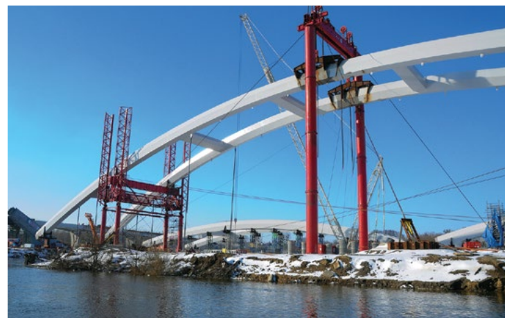
Montaż łuków na moście w Toruniu, MZD Toruń
