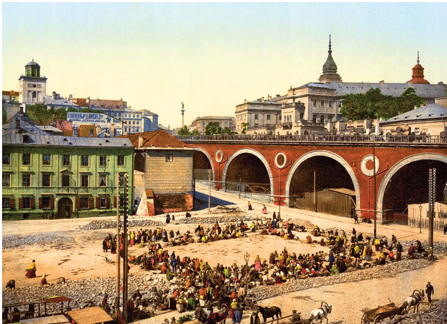
Prace brukarskie w okolicy wiaduktu nad Powiślem w Warszawie, początek XX w.
