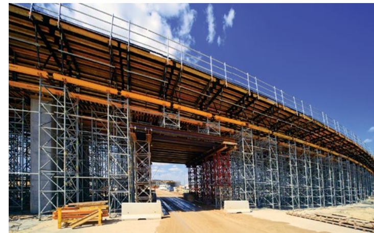
Budowa wiaduktu nad A1 w Strykowie zaprojektowanego przez MOSTY Katowice
