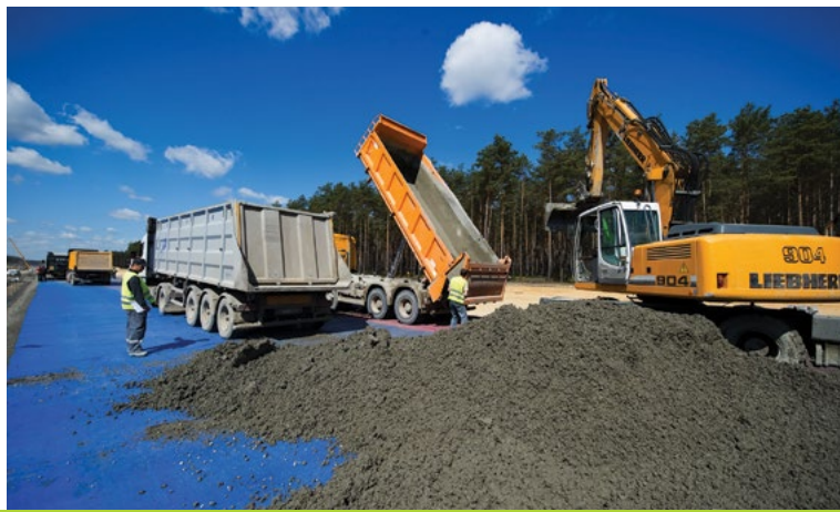
Układanie nawierzchni betonowej w okolicy Trzciela, Autostrada Wielkopolska
