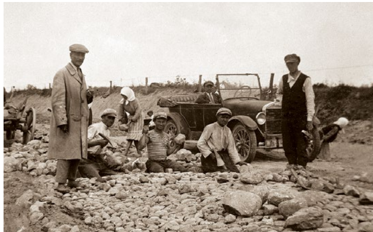
Budowa drogi Sarnaki-Konstantynów, 1930 r.
