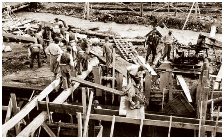
Budowa mostu drogowego przez Skawinę w Makowie Podhalańskim, 1935 r.
