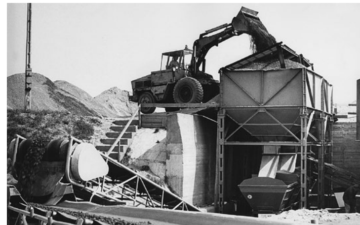
Wytwórnice mas bitumicznych, Rożyny, 1977 r.
