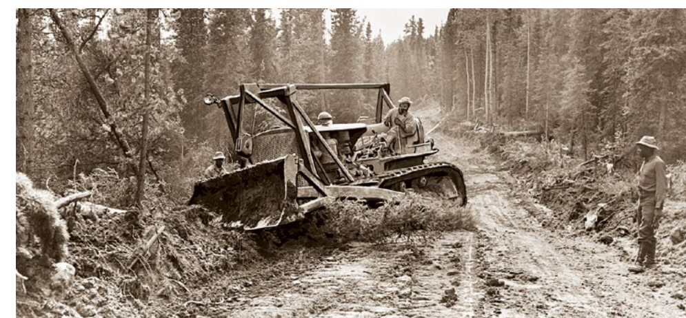
Budowa autostrady ALCAN – 1942 r.
