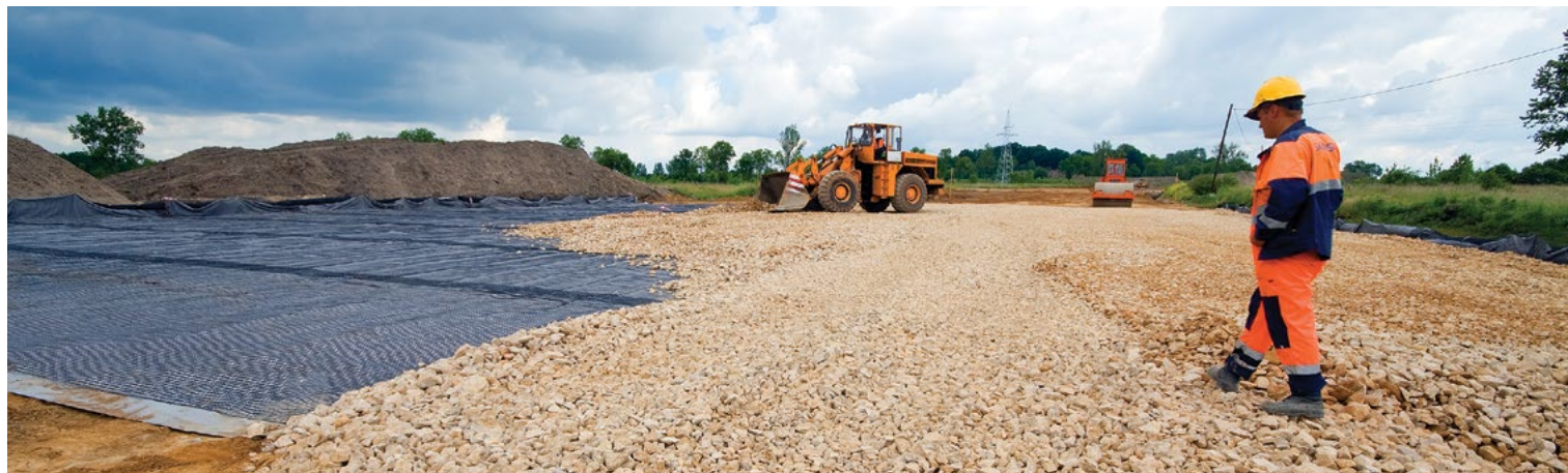
Układanie podbudowy z kruszyw, GDDKiA
