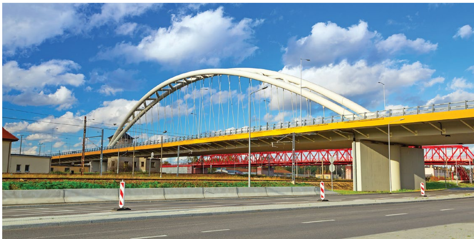
Wiadukt w Gdańsku nad A1
