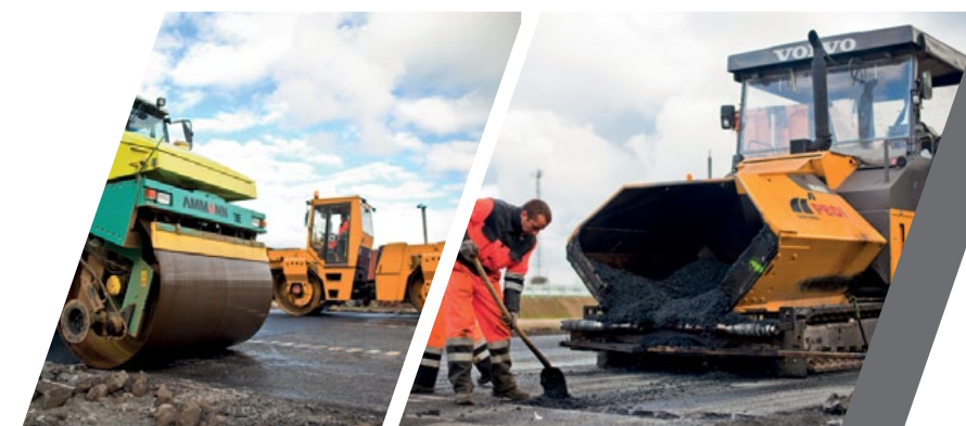
Przebudowa ul. Polnej w Toruniu – osiedle JA Inwestor: MZD Toruń
