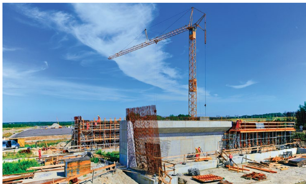
Podstawowym materiałem konstrukcyjnym w budownictwie mostowym jest beton, z którego powstają fundamenty, podpory, przyczółki czy przęsła
