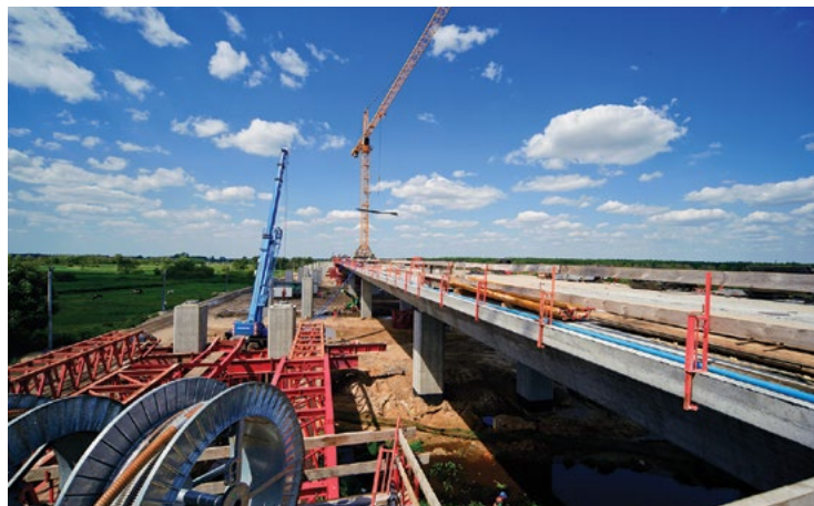
Budowa wiaduktu w okolicy Kutna nad A2, MOSTY Katowice
