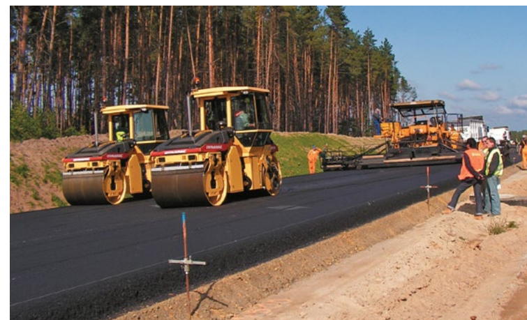
Nawierzchnia asfaltowa budowana jest przede wszystkim z asfaltu i kruszywa mineralnego (pochodzenia skalnego), które w połączeniu tworzą mieszankę mineralno-asfaltową
