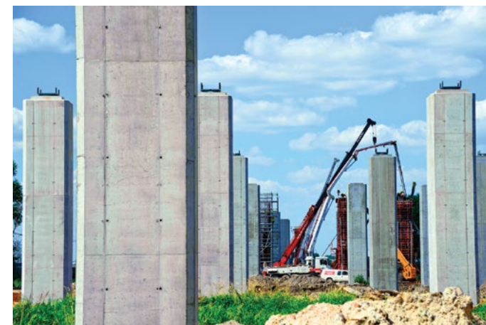
Betonowe filary i pale prefabrykowane pod wiadukt nad A4 w okolicy Tarnowa, MOSTY Katowice
