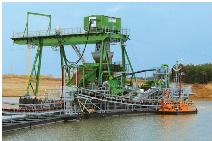
Uruchomienie nowoczesnej koparki głębokoczepalnej w kopalni Dębówko
