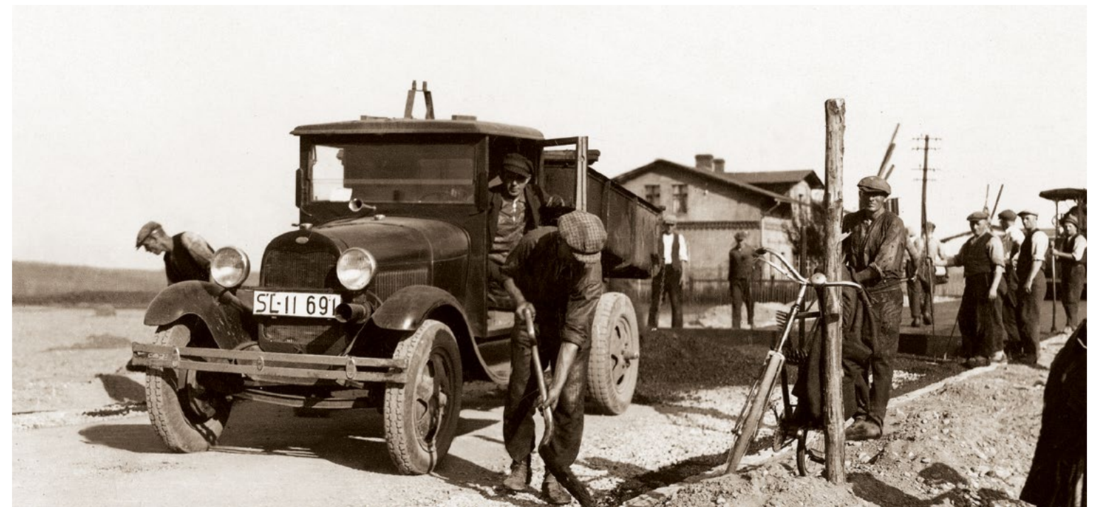
Budowa nawierzchni drogi Żory-Rybnik-Debic, 1933 r.
