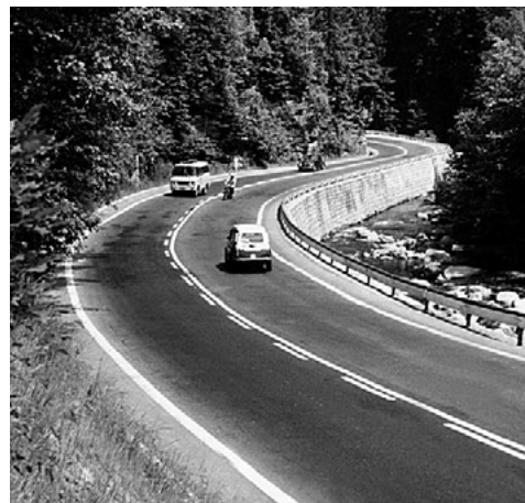
Budowa trasy Piechowice-Szklarska Poręba-Jakuszyce-Szczucin
