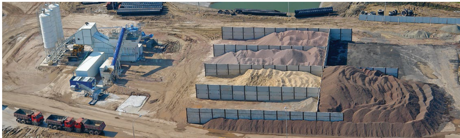
Składowisko różnych rodzajów kruszych na placu budowy, Gdańsk Transport Company
