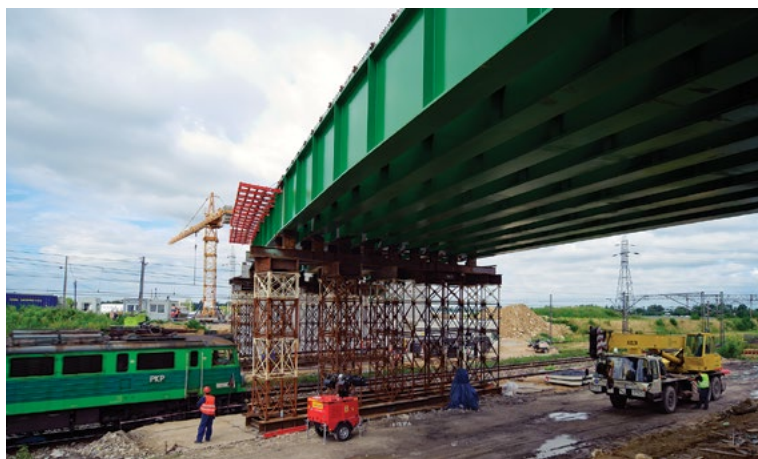
Budowa wiaduktu nad S69 w Bielsku-Białej zaprojektowanego przez MOSTY Katowice
