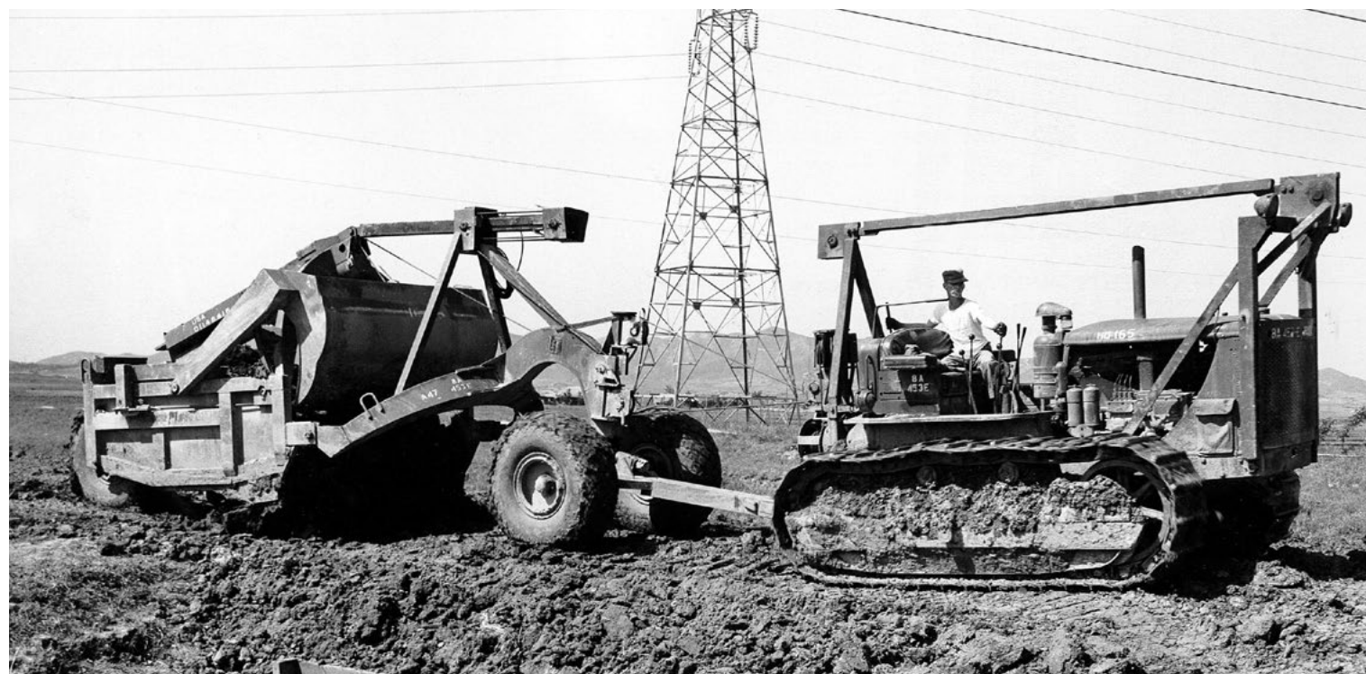
Budowa drogi w Korei w okolicy rzeki Han przez amerykańską armię, początek lat 50. XX w.
