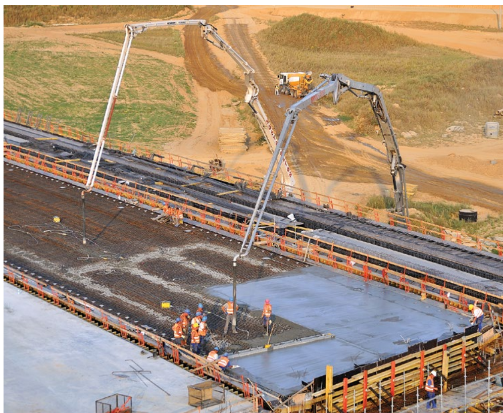
Wylewanie betonu na S17 na odcinku Bogucin-Dąbrownica, Budimex
