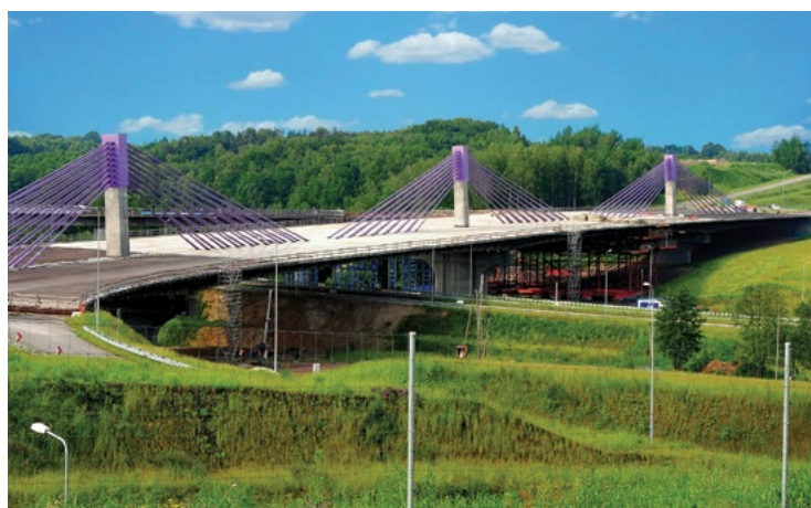
Wiadukt w Mszanie
