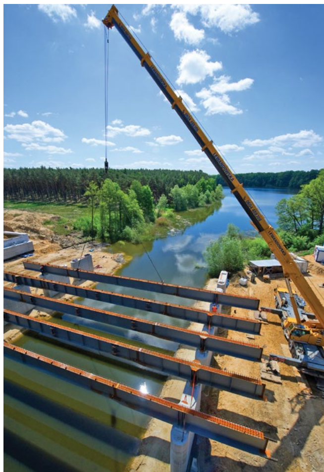
Usztywnianie blachownic mostu nad rzeką Obrą, Autostrada Wielkopolska
