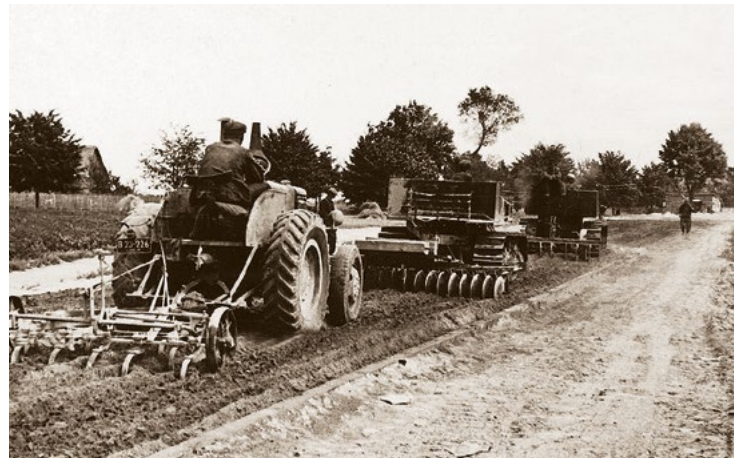
Mieszanie gruntu doziarnionego z cementem na sucho, lata międzywojenne
