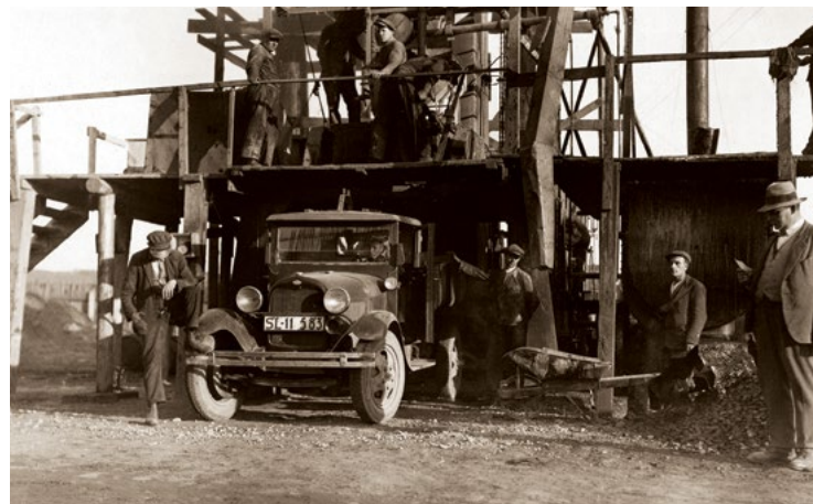
Instalacja maszyny do produkcji asfaltu, Żory-Rybnik-Debicz, 1933 r.
