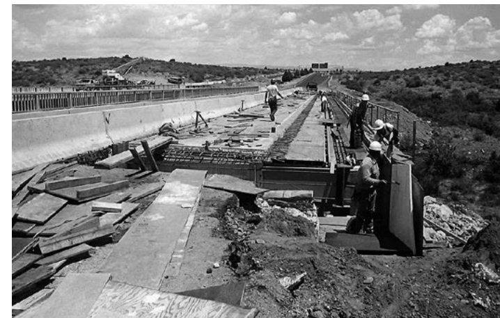
Budowa drogi w miejscowości Camp Verde w USA, 1980 r.
