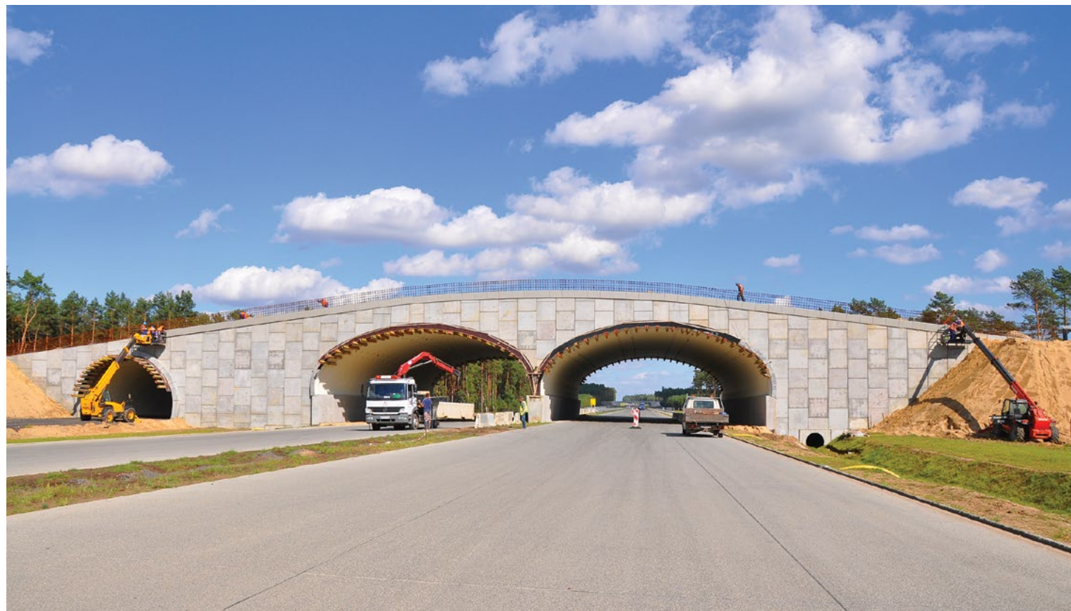
Widok współczesny dużego mostu krajobrazowego będącego przejściem dla zwierząt w okolicy Trzmiela, Autostrada Wielkopolska
