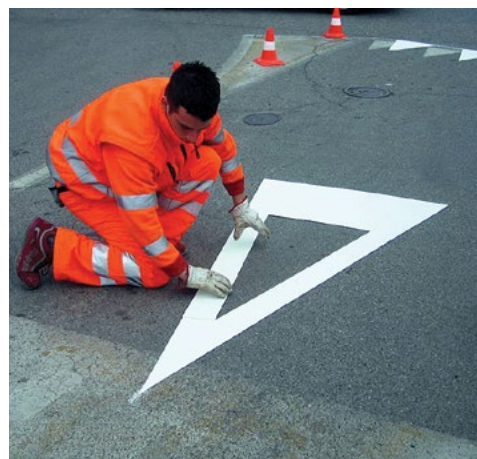
Przyklejanie taśm prefabrykowanych
