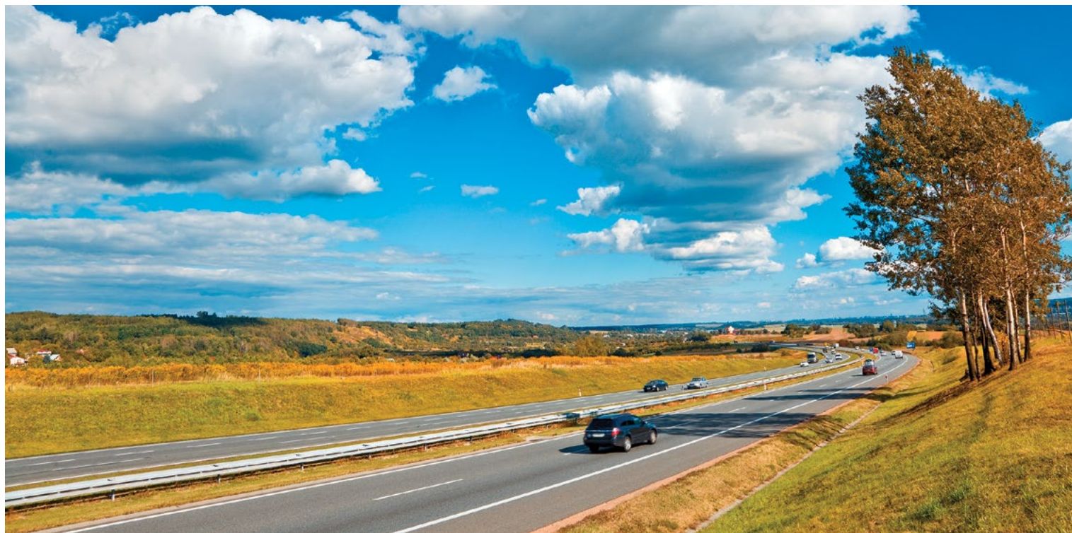
Odcinek A4 Katowice-Kraków, Stalexport Autostrada Małopolska
