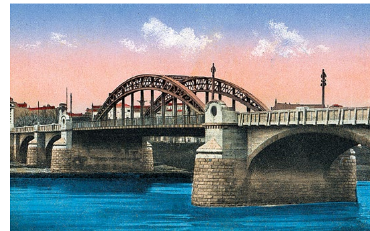
Poznań – most Wielki (obecnie św. Rocha) wybudowany w latach 1911-1913
