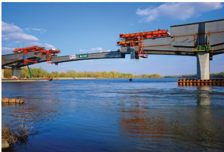
Budowa mostu Północnego w Warszawie
