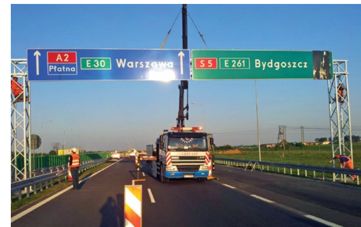
Montaż znaków pionowych przez firmę Erplast
