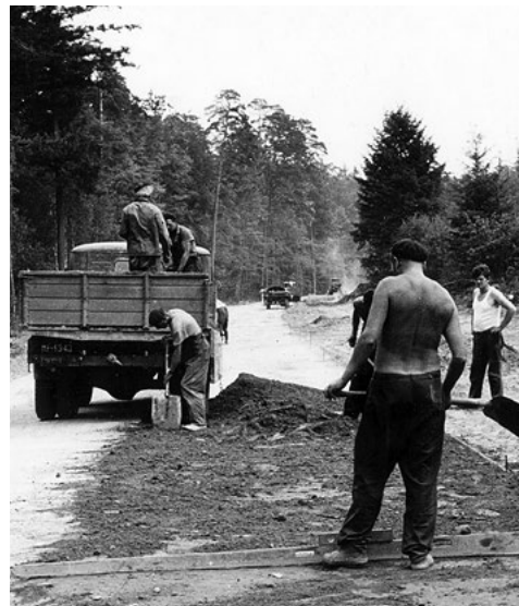
Budowa drogi Parłówko-Ploty, lata 70. XX w.
