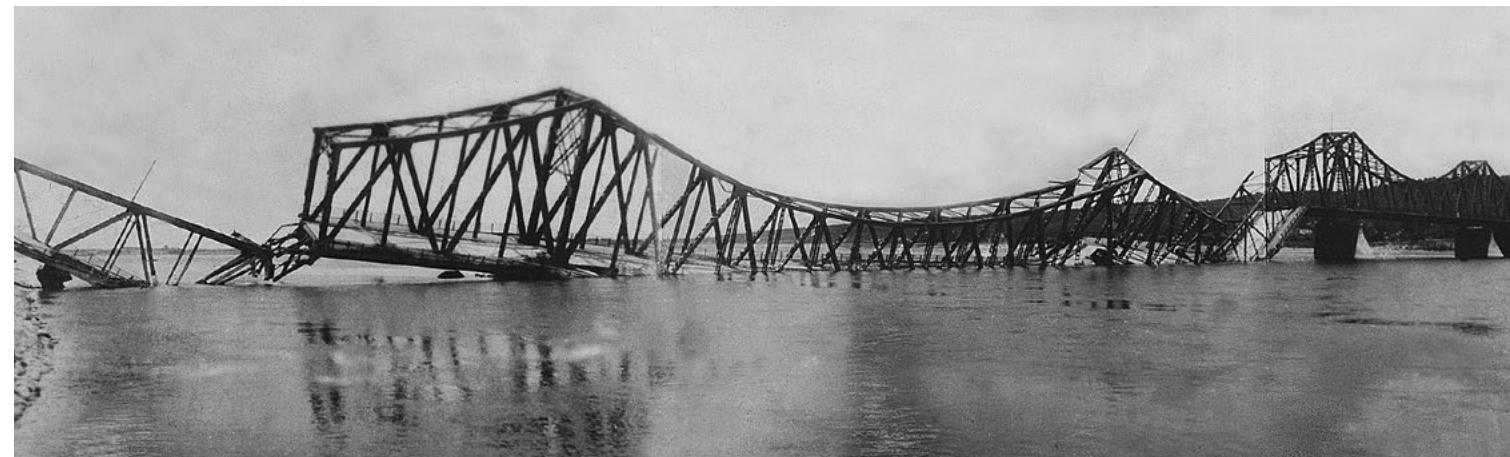
Zniszczony w wyniku działań wojennych most przez Wisłę we Włocławku, 1945 r.
