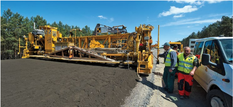
Układanie warstwy chudego betonu w okolicy Jordanowa, Autostrada Wielkopolska
