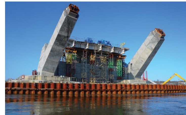
Betonowe filary i podpory mostu w Toruniu, MZD Toruń
