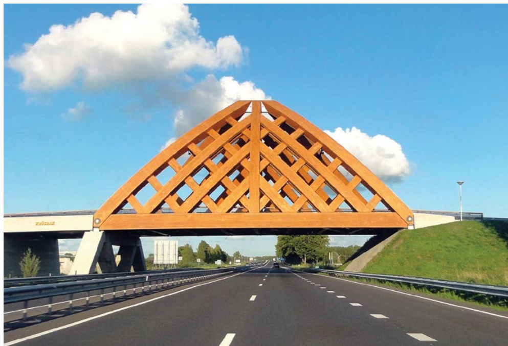
Wiadukt Sneek w Holandii wykonany z drewna klejonego
