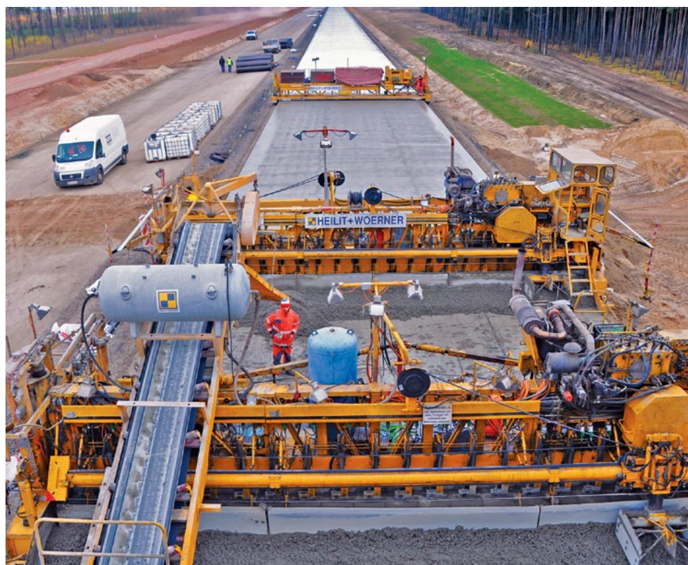
Układanie nawierzchni betonowej w okolicy Rogozińca, Autostrada Wielkopolska
