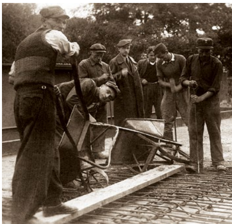
Betonowanie płyty na moście na rzece Kwisa w Szczecinie, okres międzywojenny
