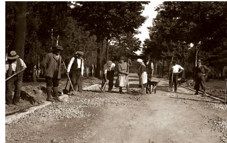
Ustawianie krawężników, droga Żory-Rybnik-Debic, 1933 r.
