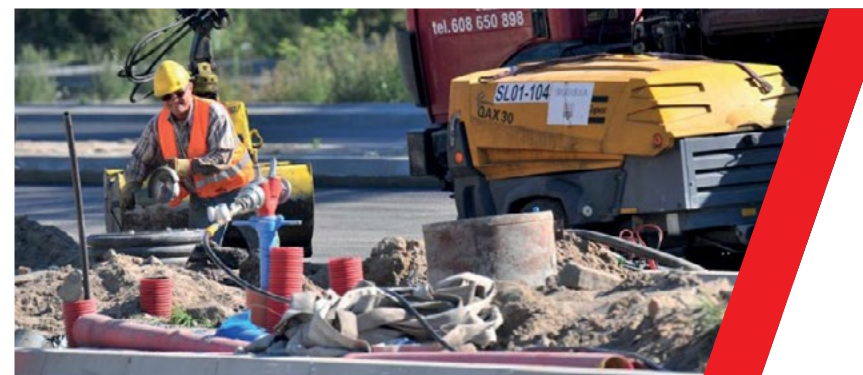
Przebudowa ul. Łódzkiej w Toruniu, Inwestor: MZD Toruń
