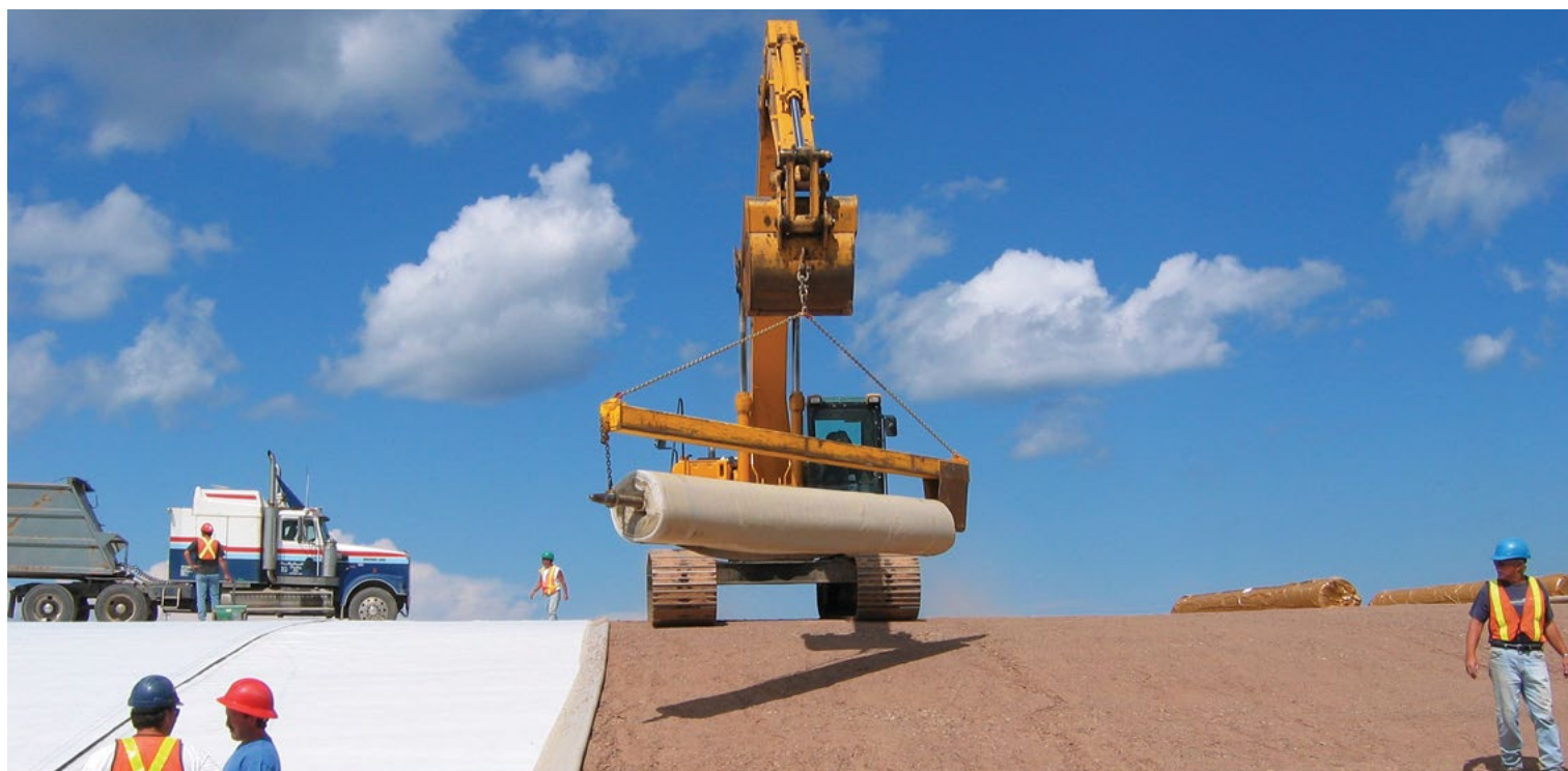
Do ochrony skarp przed erozją służą geomaty
