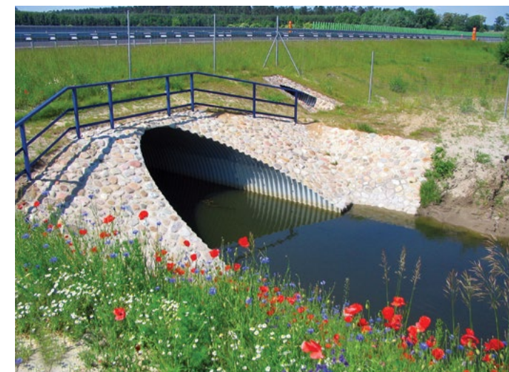
Przepust pod autostradą, Autostrada Wielkopolska
