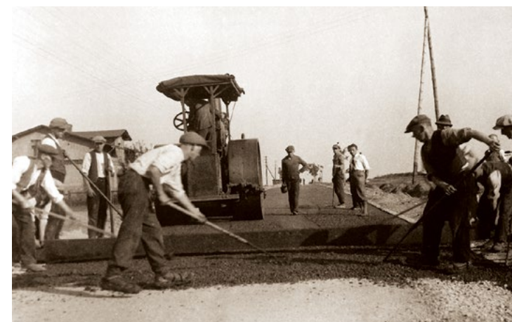
Układanie nawierzchni drogi Żory-Rybnik-Debic, 1933 r.
