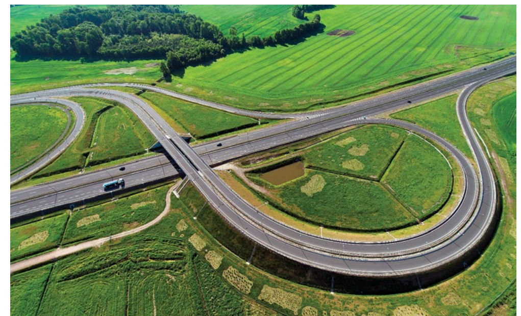
Autostrada A1 na odcinku Rusocin-Czerniewice, fot. Kacper Kowalski/aeromedia.pl, Gdańsk Transport Company
