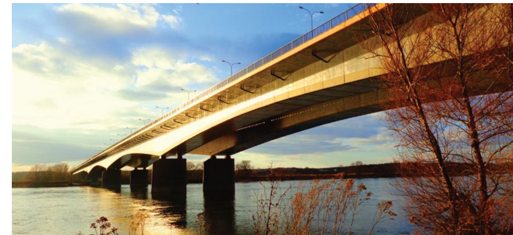
Most autostradowy A1 w Czerniewicach
