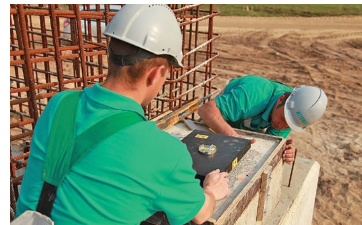
Poziomowanie łożysk przed montażem, BETOMAX
