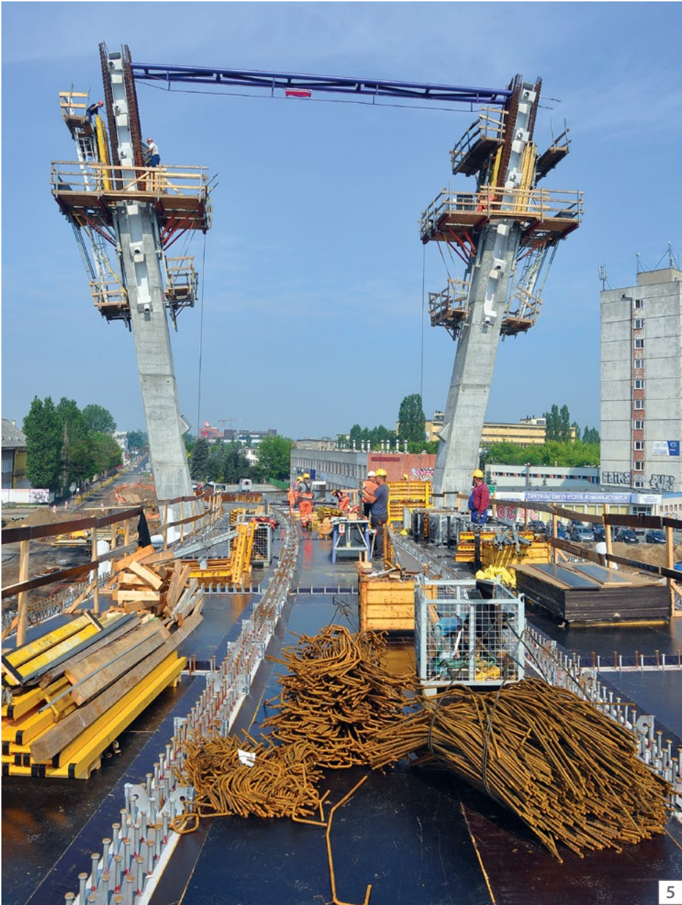
fot. 1. Zagęszczanie betonu (płyta denną tunelu), MZD Toruń fot. 2. Prace geodezyjne, MZD Toruń fot. 3. Prace przygotowawcze przed betonowaniem, MZD Toruń fot. 4. Montaż zbrojenia, MZD Toruń fot. 5. Montaż zbrojenia i budowa pylonu estakady przy ul. Żółkiewskiego, MZD Toruń
