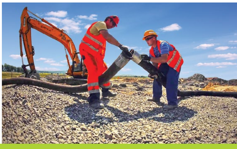
Keller Polska – pale wiercone CFA (ang. Continuous Flight Auger)
