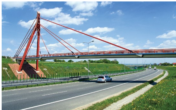
Kładka Krzywy Kij nad A4
