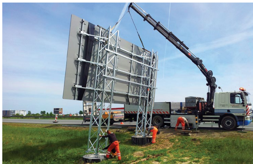
Montaż oznakowania pionowego przez firmę Erplast
