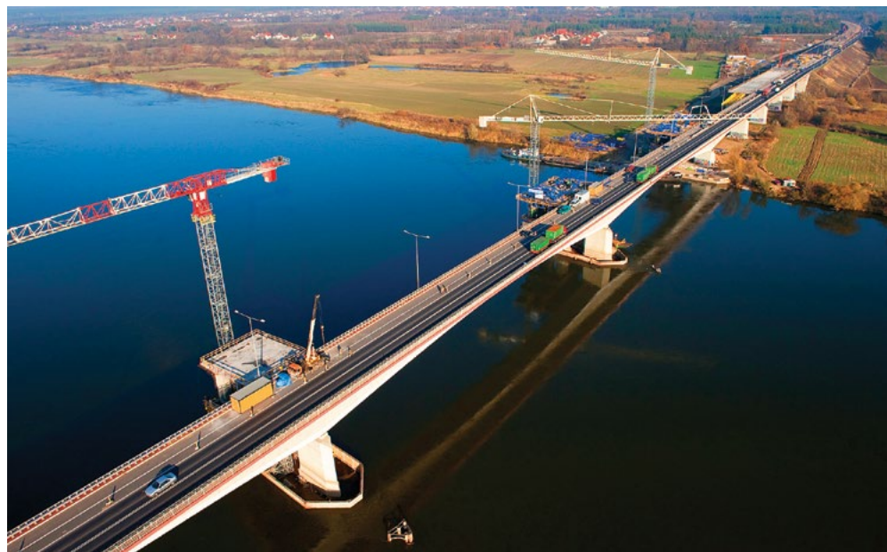
Budowa odcinka A1 Toruń-Nowe Marzy, most przez Wisłę, Gdańsk Transport Company
