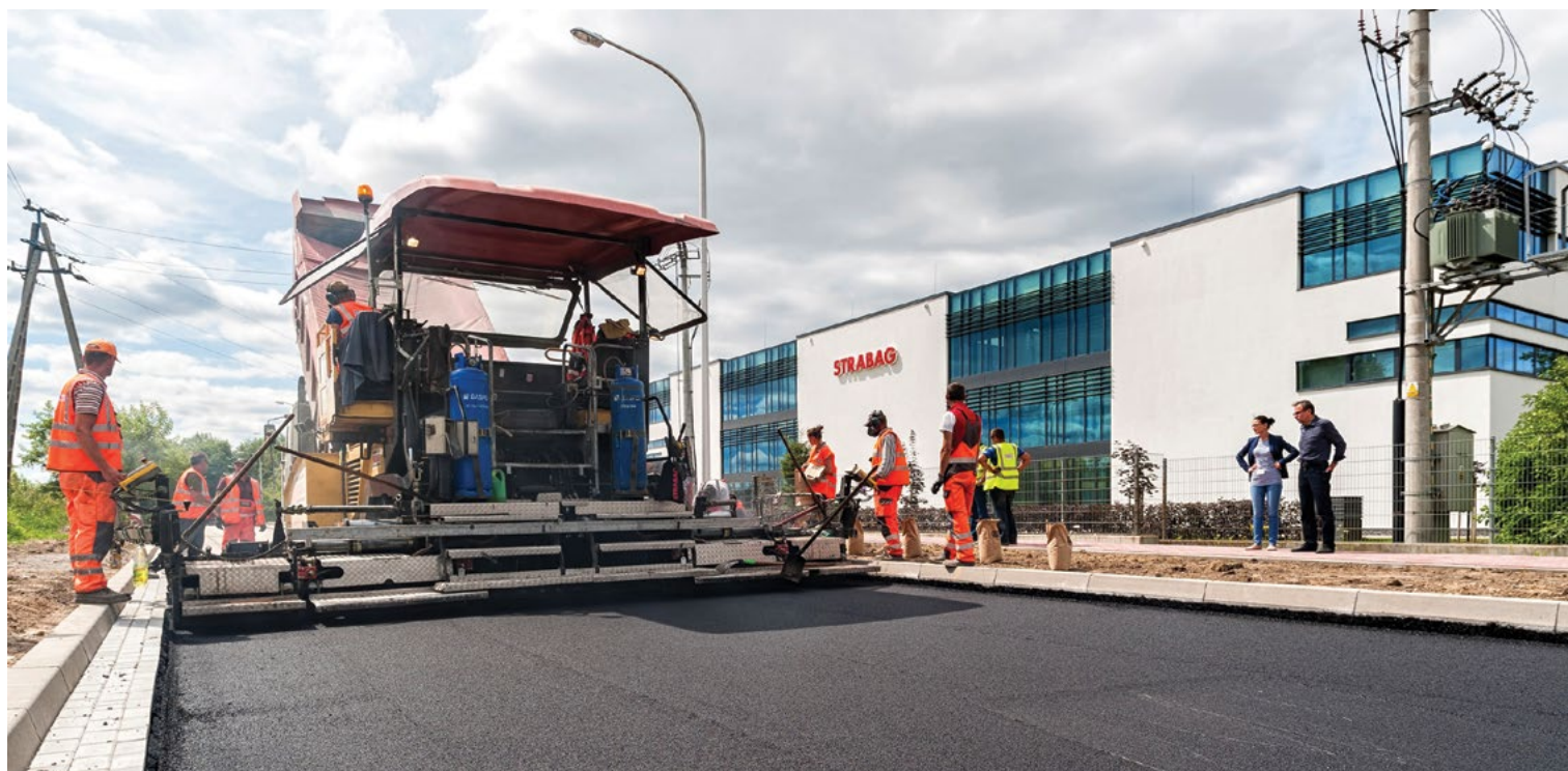
Układanie mma z asfaltem modyfikowanym gumą ze zużytych opon na ul. Parzniewskiej w Pruszkowie, STRABAG
