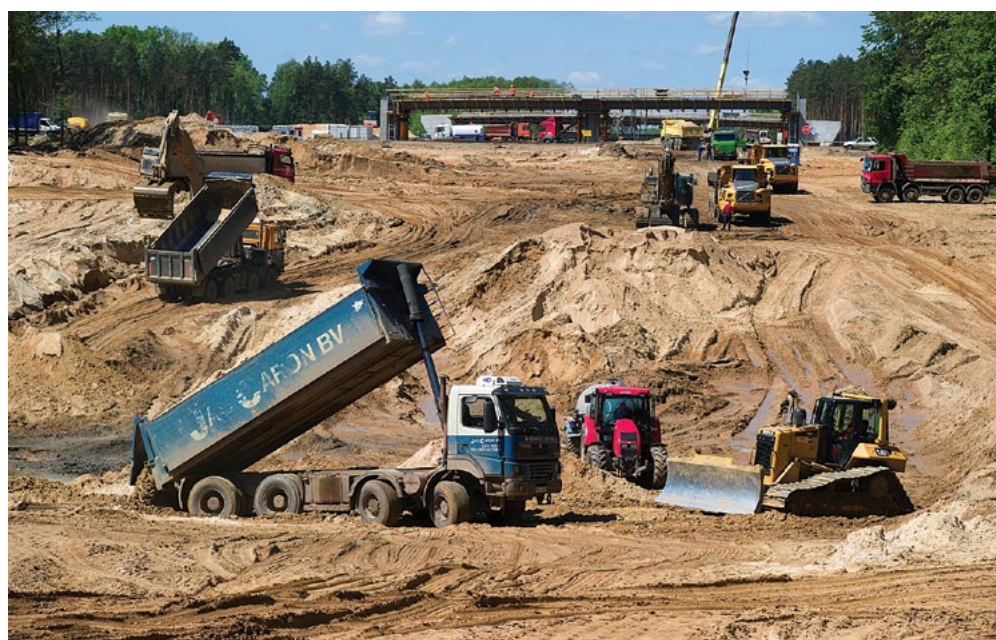
Układanie gruntów słabonośnych na A2, Autostrada Wielkopolska
