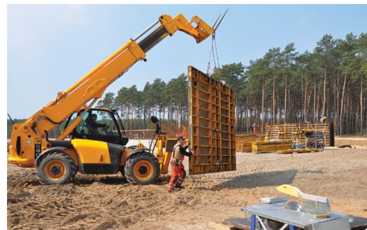
Montaż szalunków podczas budowy przejścia dla zwierząt w okolicy Trzmiela, Autostrada Wielkopolska
