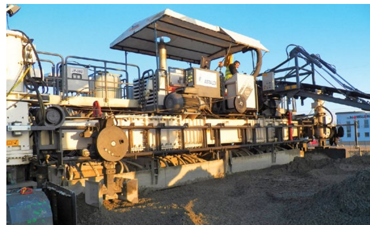
Układanie nawierzchni betonowej przez firmę Astaldi
