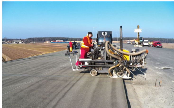
Układanie nawierzchni betonowej, Astaldi SA
