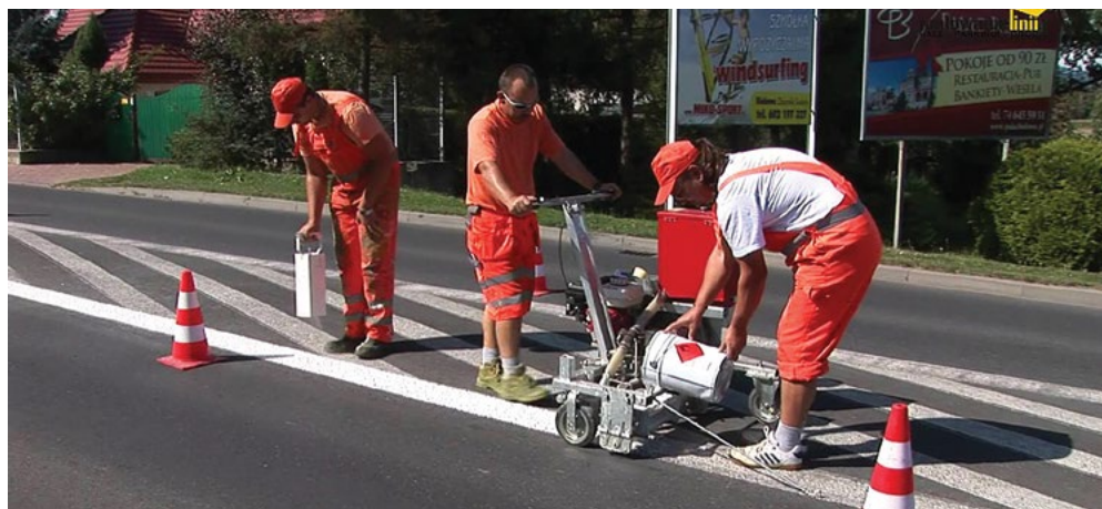
Malowanie oznakowania poziomego farbami wodorozcieńczalnymi
