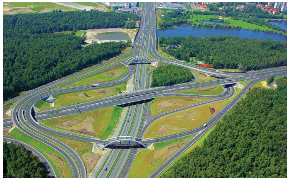
Węzeł Murkowska w Katowicach przy autostradzie A4 wykonany przez firmę Budimex
