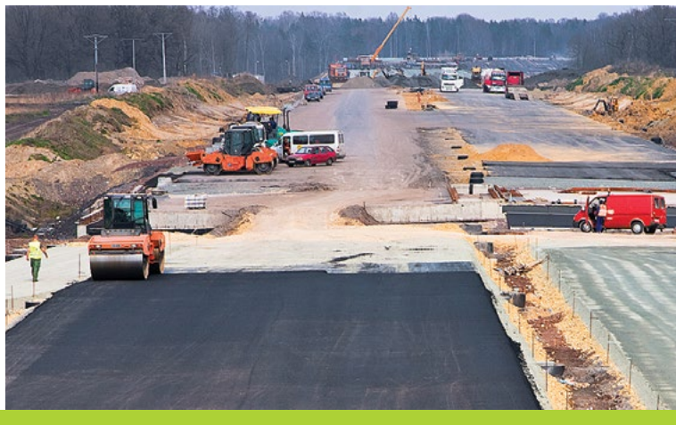
Budowa autostrady A2, której zarządcą jest Autostrada Wielkopolska, GDDKiA
