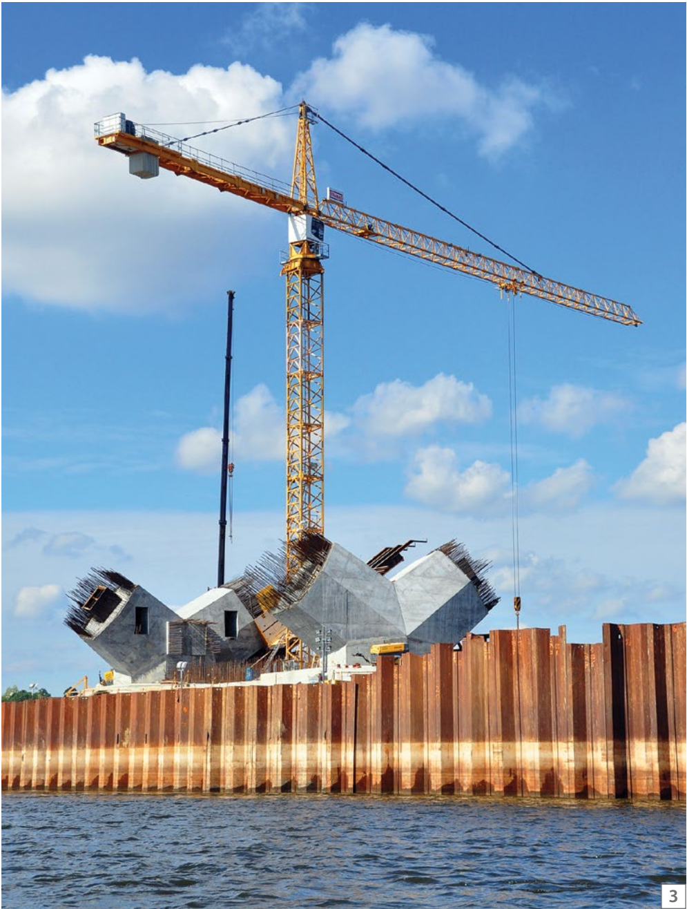
fot. 1-2. Montaż (scalanie) konstrukcji mostu, MZD Toruń fot. 3. Montaż podpory środkowej (nurtowej) mostu w nurcie Wisły na wyspie, MZD Toruń fot. 4. Montaż konstrukcji stalowej (estakad), MZD Toruń fot. 5. Deskowanie podpór (filarów), MZD Toruń fot. 6. Transport konstrukcji łukowej mostu, MZD Toruń fot. 7. Wykonanie konstrukcji pomostu (most przez Wisłę), MZD Toruń fot. 8. Wykonanie asfaltu lanego na moście, MZD Toruń
