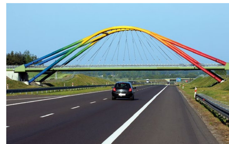
Kładka Tęcza na autostradzie A2, GDDKiA
