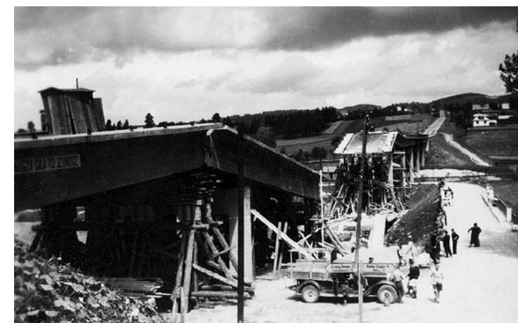
Odbudowa wiaduktu w Chabówce, 1946 r.
