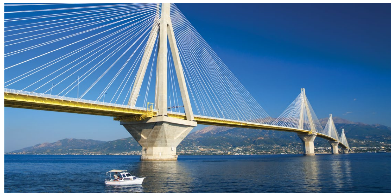
Nowoczesny most Rion-Antirion w Grecji oddano do użytku w 2004 r.
