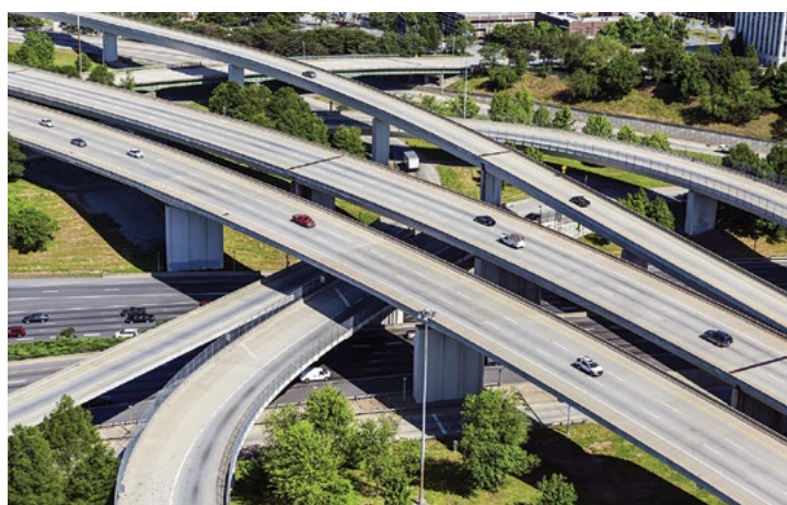
Autostrada w Detroit
