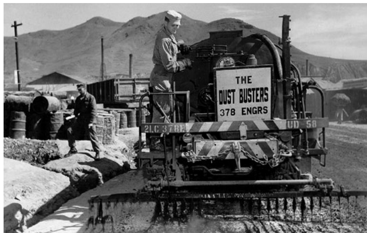
Budowa drogi w Korei w okolicy rzeki Han przez amerykańską armię, początek lat 50. XX w.
