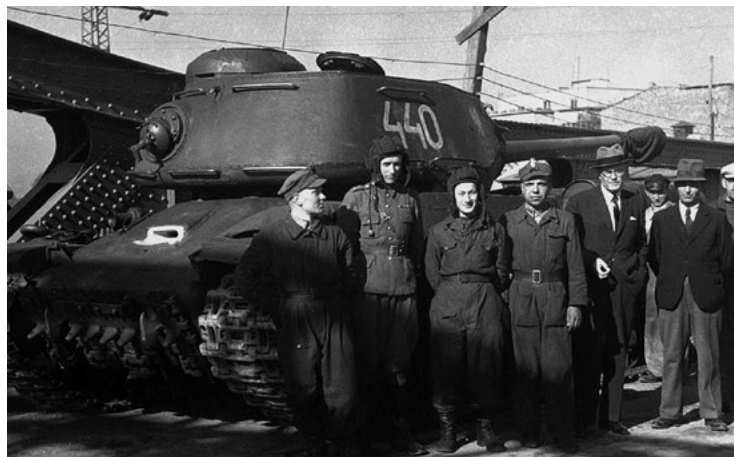
Obciążenie próbne odbudowanego w 1948 r. mostu Piłsudskiego w Krakowie
