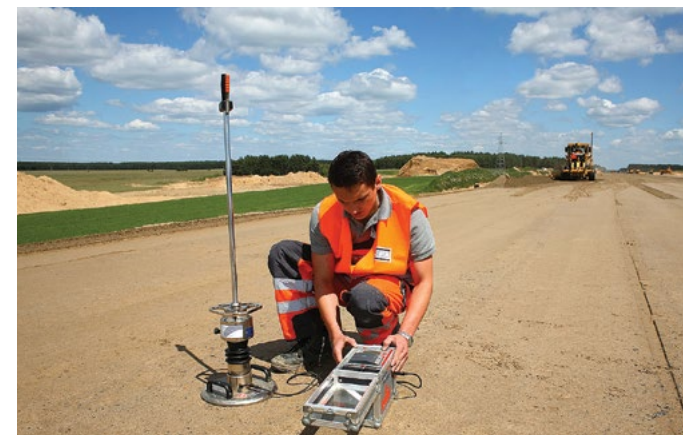
Badanie nawierzchni i pomiary jej równości, DHV Polska
