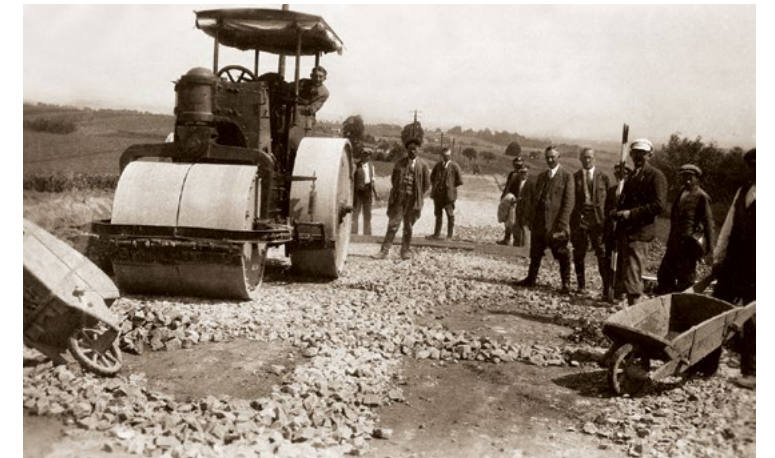
Budowa nawierzchni drogi Żory-Rybnik-Debic, 1933 r.
