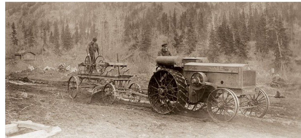
Budowa drogi w USA – 1916 r.
