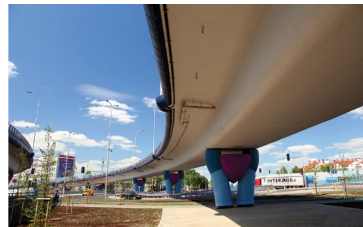
Betonowe filary estakady przy węźle Łopuszańska – Kleszczowa w Warszawie, BETOMAX
