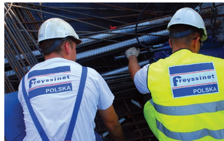
Pracownicy Freyssinet podczas sprężania mostu za pomocą stalowych prętów
