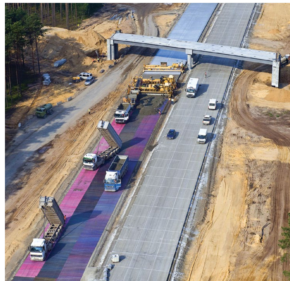
Budowa wiaduktu drogowego i układanie nawierzchni betonowej, Autostrada Wielkopolska
