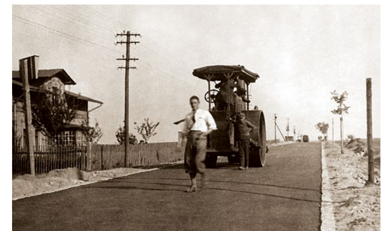
Wałowanie nawierzchni Żory-Rybnik-Debic, 1933 r.
