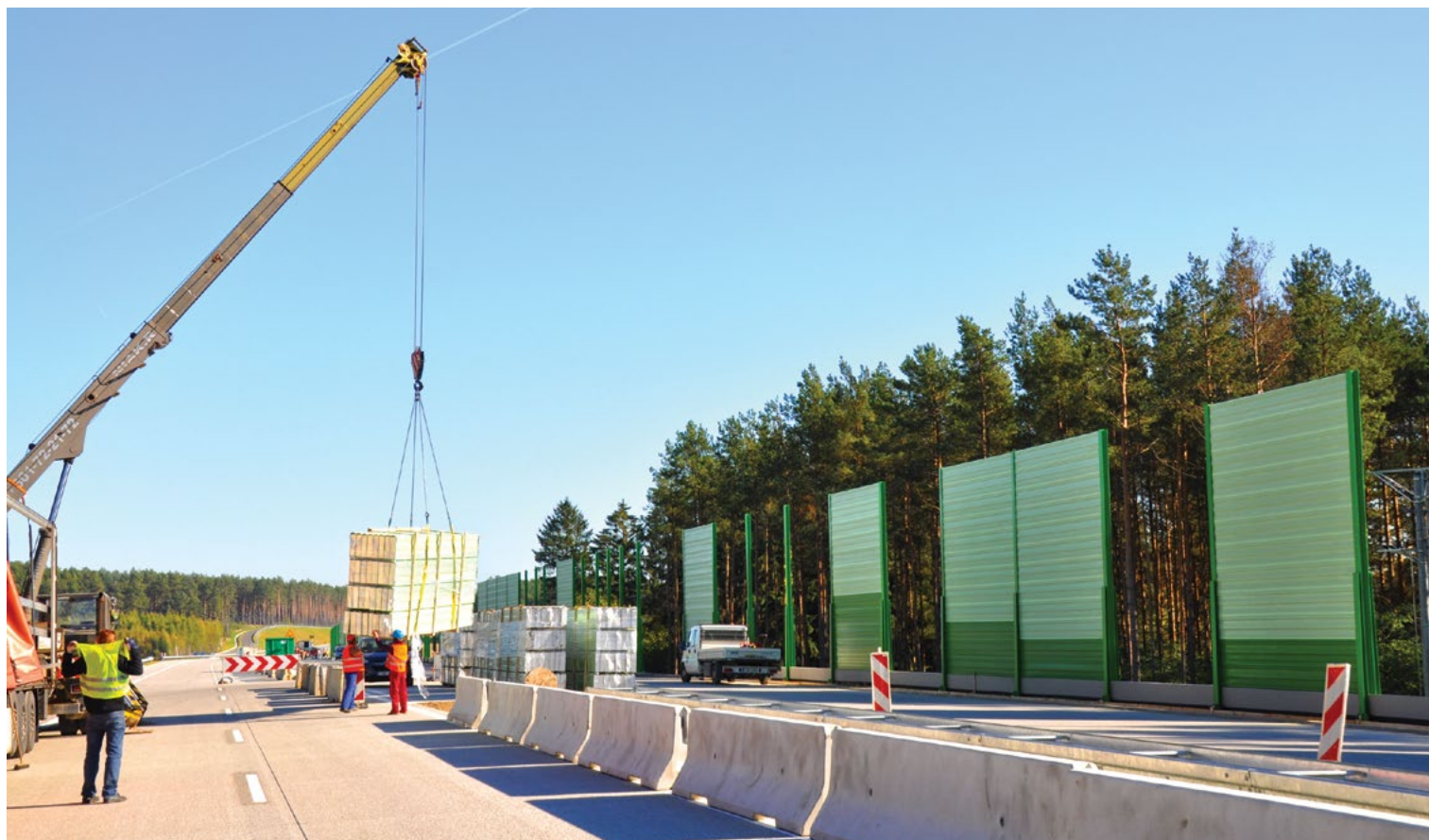
Montaż ekranów i barier ochronnych, Autostrada Wielkopolska
