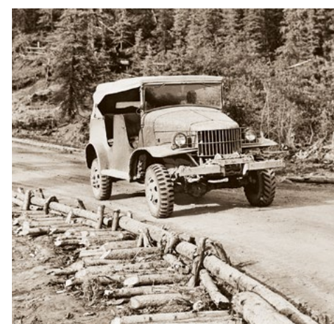
Budowa autostrady ALCAN – 1942 r.
