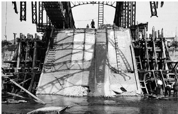
Odbudowa mostu Piłsudskiego w Krakowie, 1946 r.
