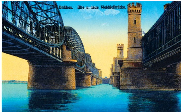
Most w Tczewie powstał w latach 1850-1857
