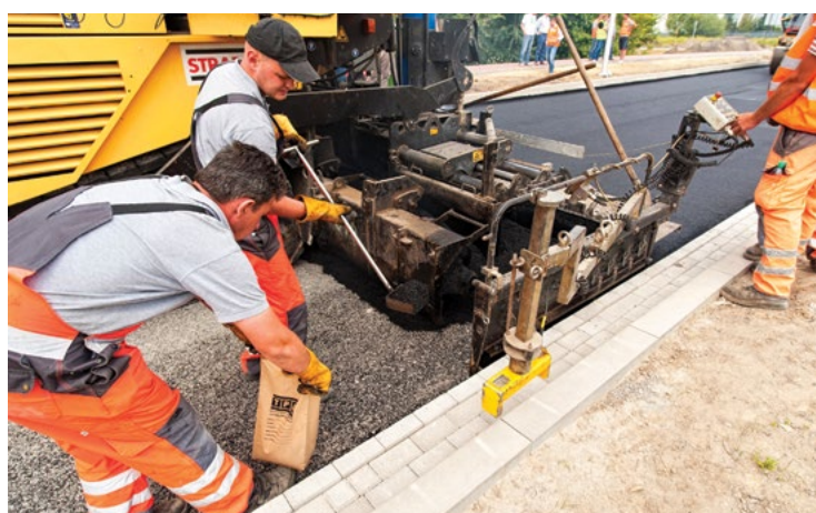
Pobór próbki mma z rozkładarki, STRABAG
