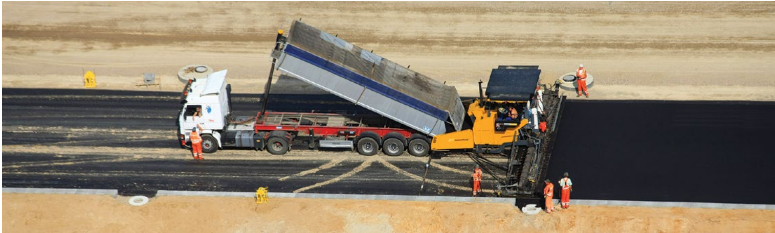
Budowa autostrady A1, kładzenie masy bitumicznej
