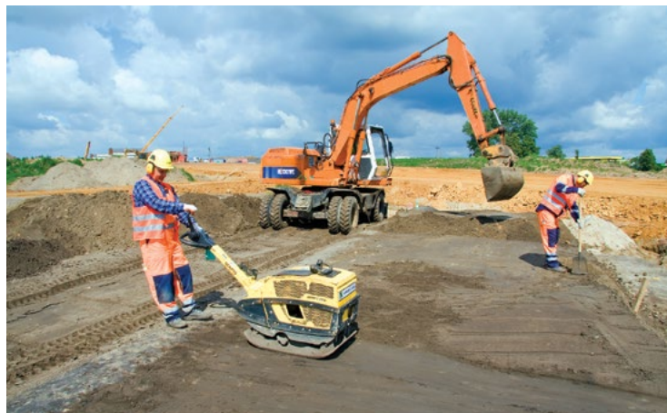
Budowa obwodnicy Siewierza, 2009 r., GDDKiA
