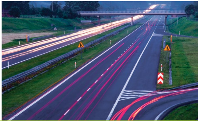
Autostrada A4 Katowice-Kraków, Stalexport Autostrada Małopolska
