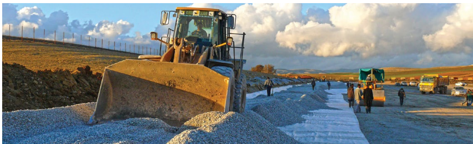
Ważnymi materiałami wykorzystywanymi do budowy dróg są geosyntetyki oraz kruszywa
