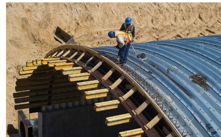
Deskowanie gzymsów podczas budowy przejścia dla zwierząt w okolicy Trzmiela, Autostrada Wielkopolska
