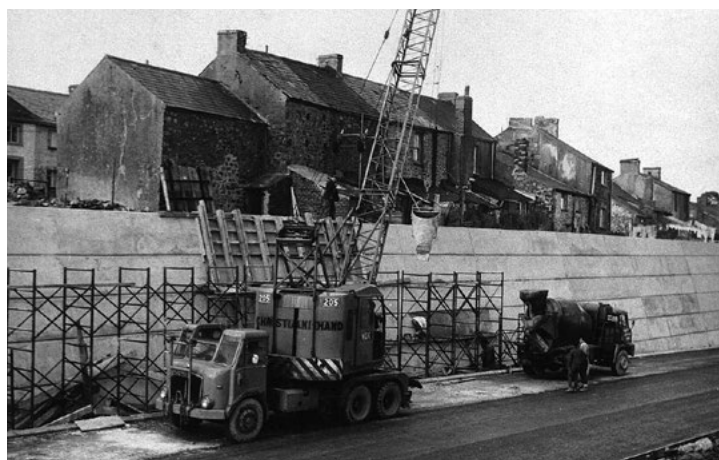
Budowa drogi w miejscowości Tredegar w Walii, 1964 r.
