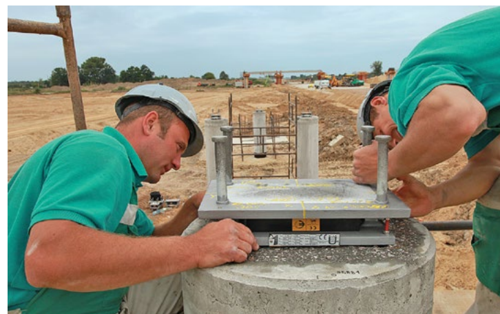
Ustawianie łożysk elastomerowych na ciosie podłożyskowym, BETOMAX
