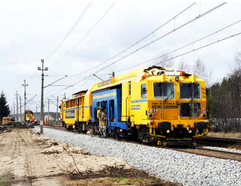
▼ Prace firmy PORR | PORR works
