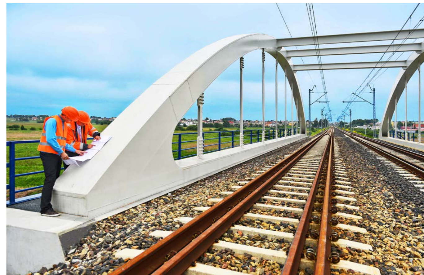
▼ Modernizacje prowadzone przez spółkę Trakcja PRKil | Modernisation works carried out by Trakcja PRKil
