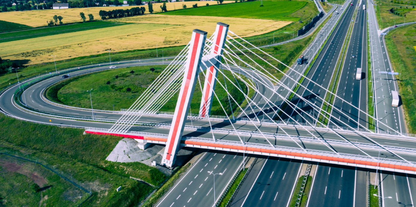
▲ Węzeł Sośnica | Węzeł Sośnica
