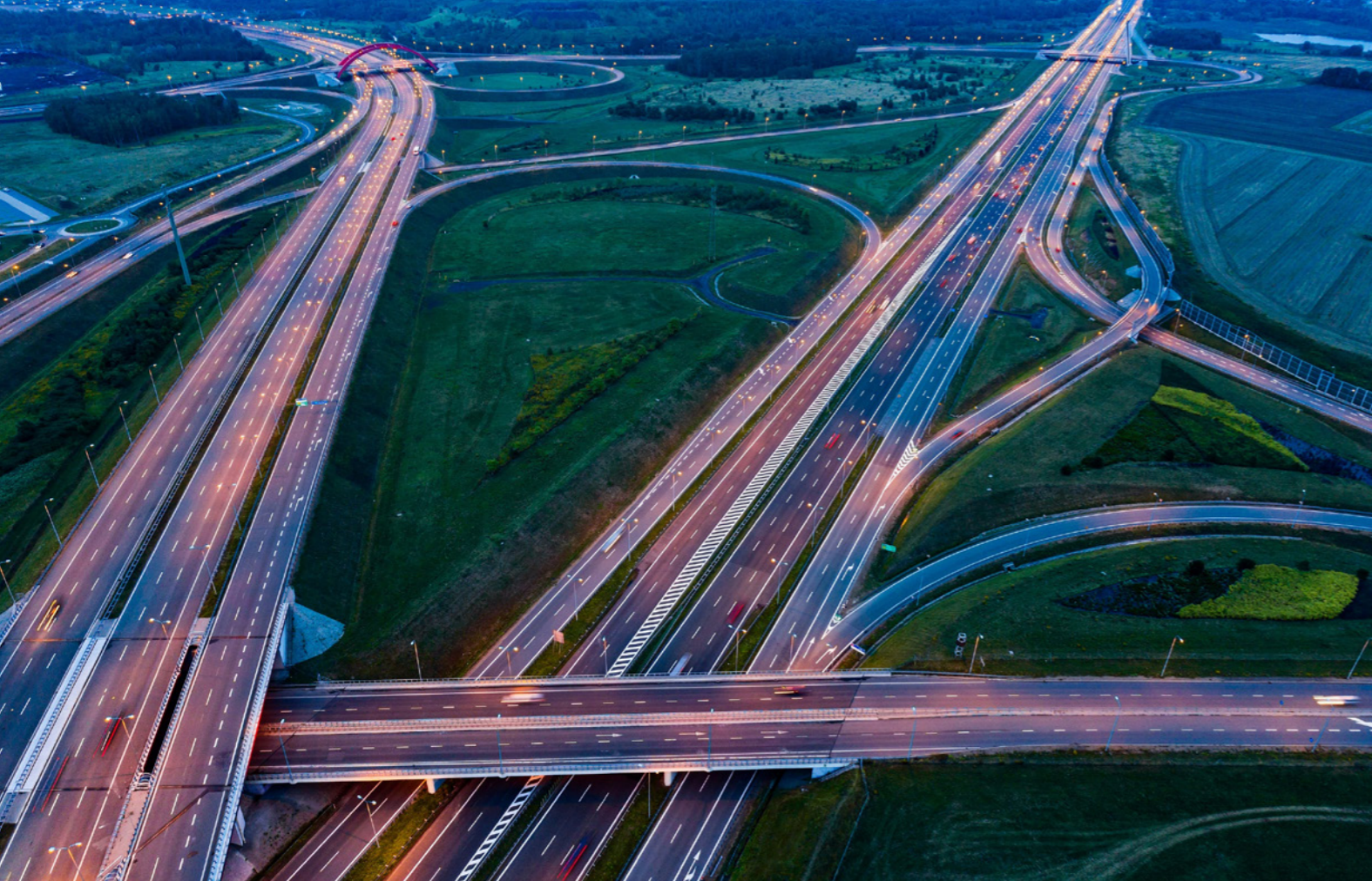
▲ Węzeł autostradowy łączący A1 oraz A4, Gliwice | Węzeł autostradowy łączący A1 oraz A4, Gliwice
