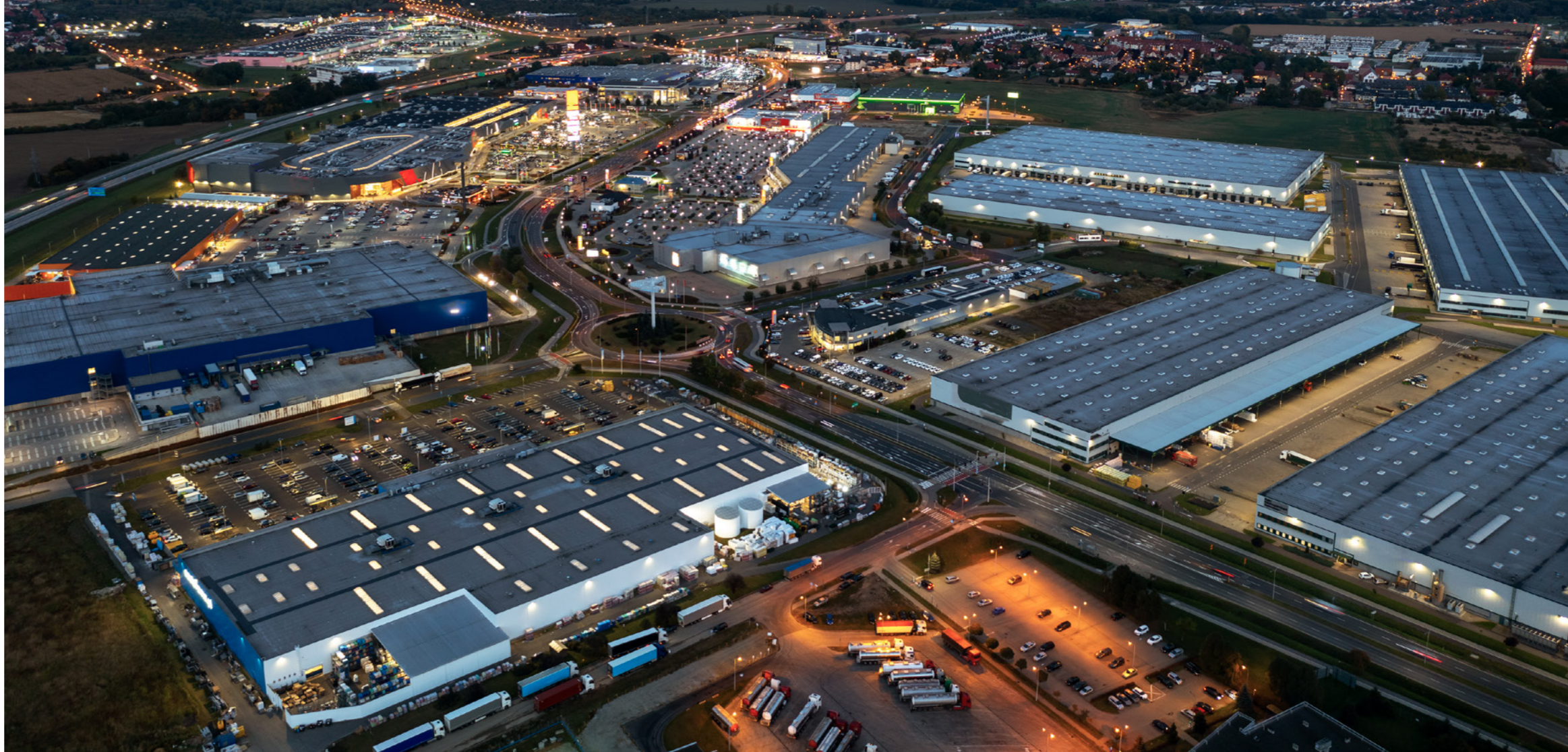
▲ Centrum Logistyczne, Wrocław | Centrum Logistyczne, Wrocław
