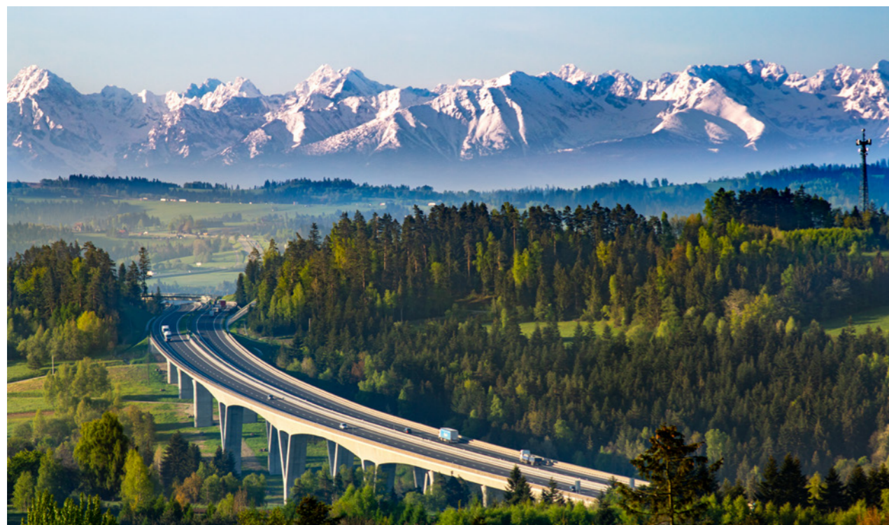
▼ Wiadukt w Skomielnej Białej | Wiadukt w Skomielnej Białej
