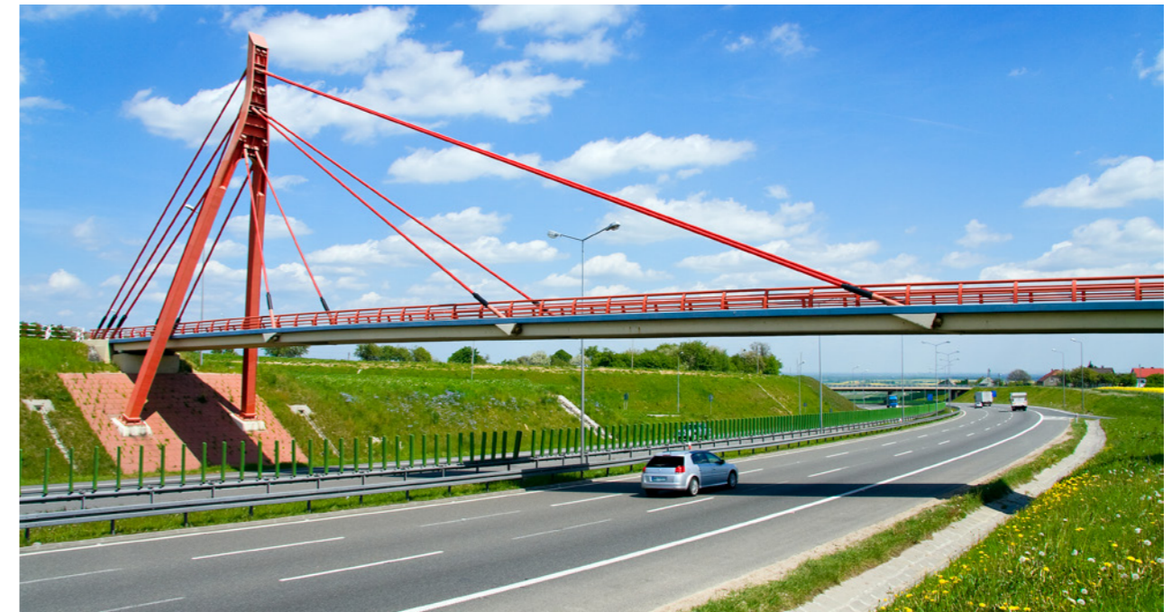
▼ Autostrada A4 | Autostrada A4
