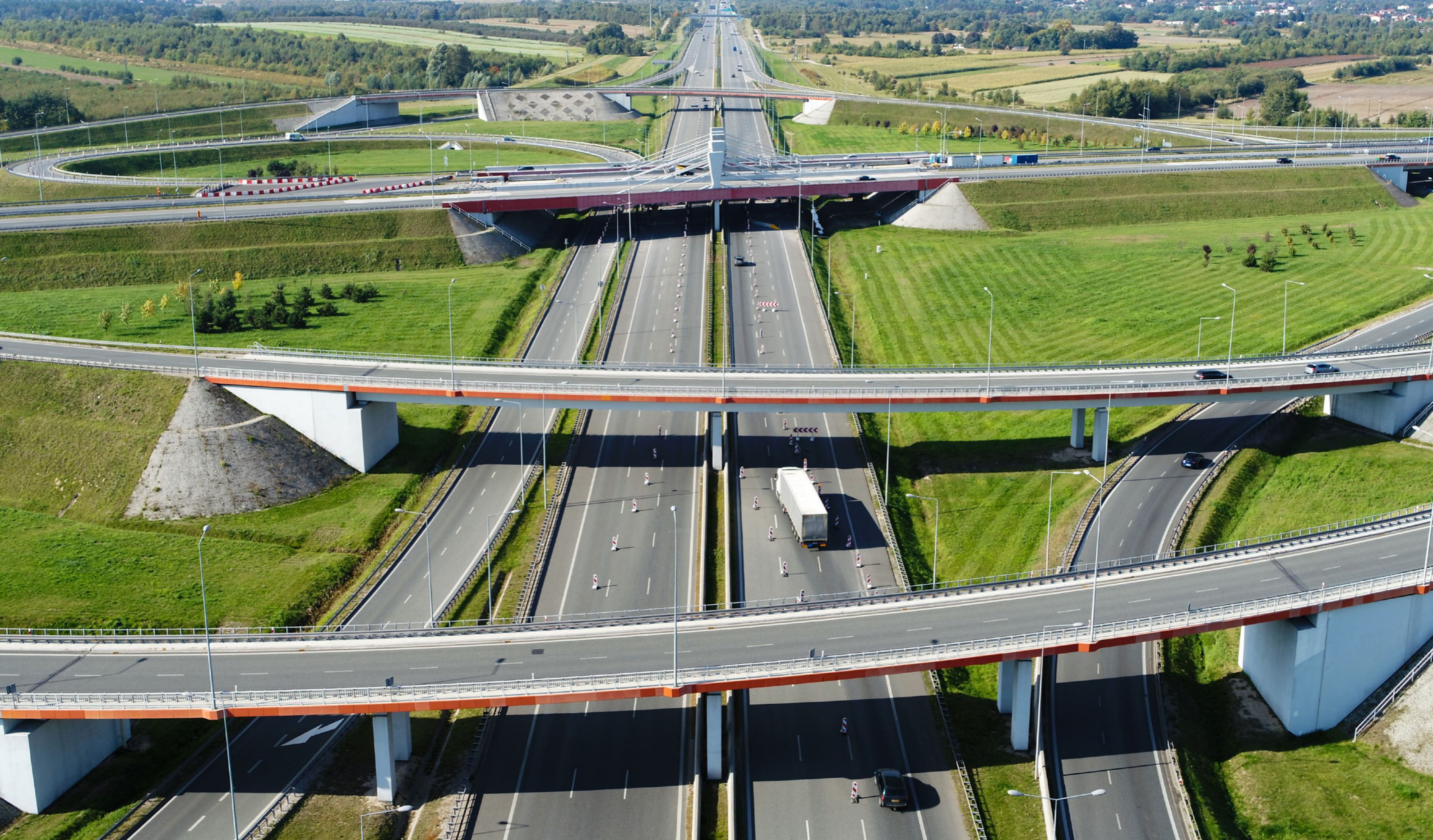
▲ Autostrada A2, węzeł Stryków | Autostrada A2, węzeł Stryków
