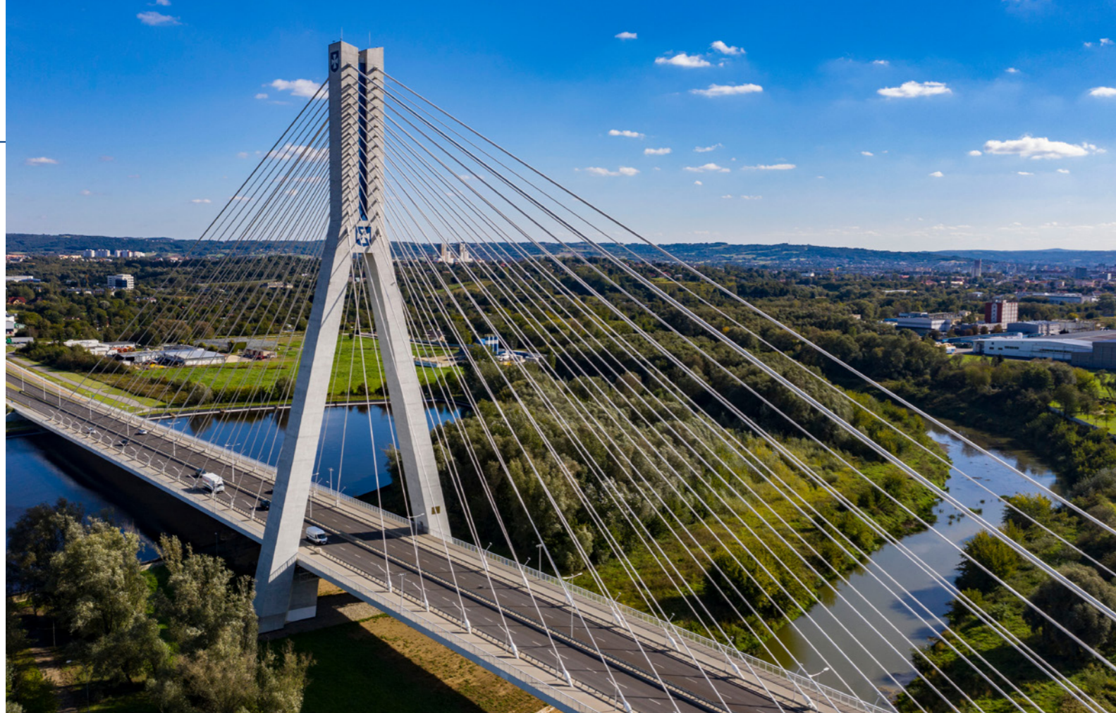
▲ Most im. Tadeusza Mazowieckiego w Rzeszowie | Most im. Tadeusza Mazowieckiego w Rzeszowie
