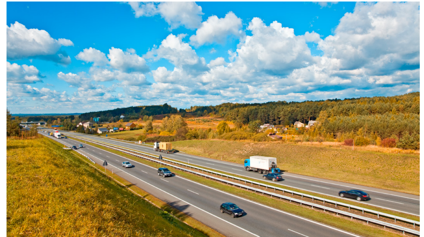
▲ Autostrada A1 | Autostrada A1
