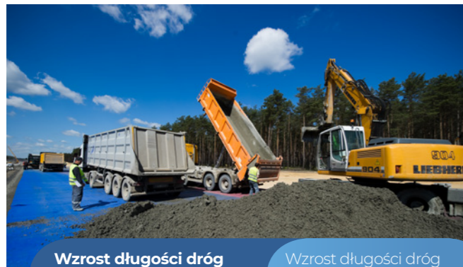
▼ Budowa obwodnicy Trzciela | Budowa obwodnicy Trzciela
