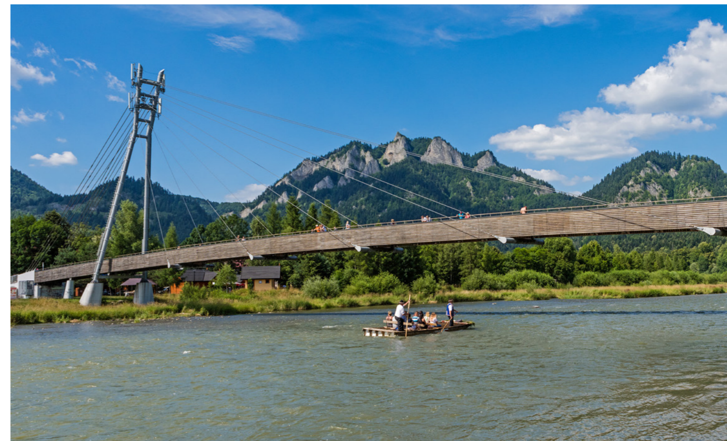
▼ Kładka nad Dunajcem w Sromowcach Niżnych | Kładka nad Dunajcem w Sromowcach Niżnych
